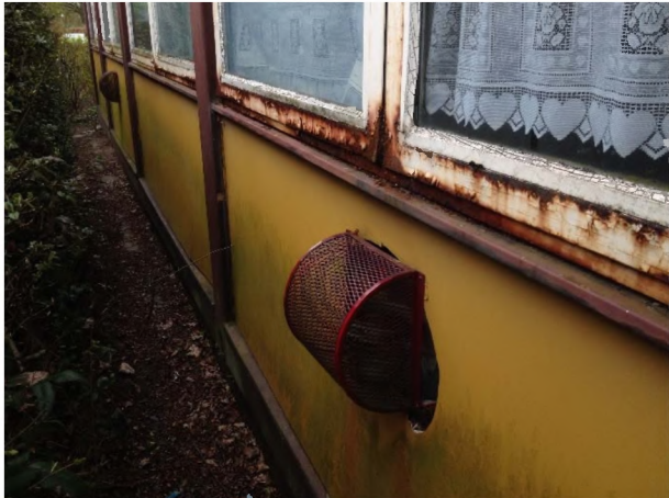
Abb. 18: Faserplatten Pavillon
