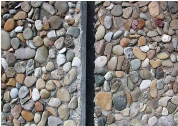
Abb. 4: Beispiel einer PCB-haltigen Fugendichtung
