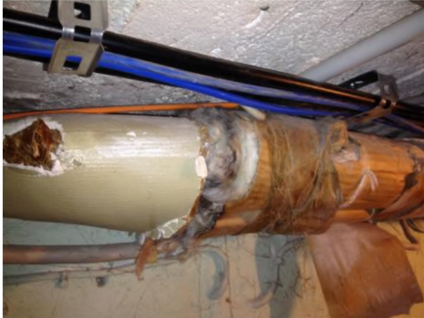
Abb. 20: KMF als Rohrleitungsummantelung
