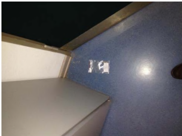
Abb. 8: asbesthaltiger Bodenbelag, Probe MP-Verw.-As.-02
