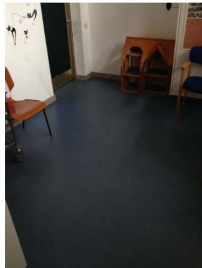
Abb. 9: asbesthaltiger Bodenbelag, Raumansicht
