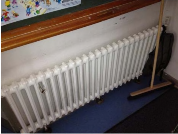
Abb. 17: Rippenheizkörper Pavillon
