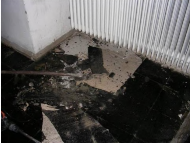
Abb. 3: Beispiel eines PAK-haltigen Gussasphaltestrichs
