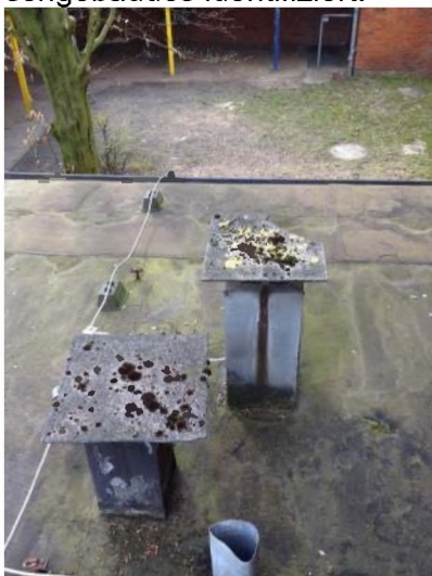
Abb. 13: AZ-Platten als Schornsteinabdeckungen
