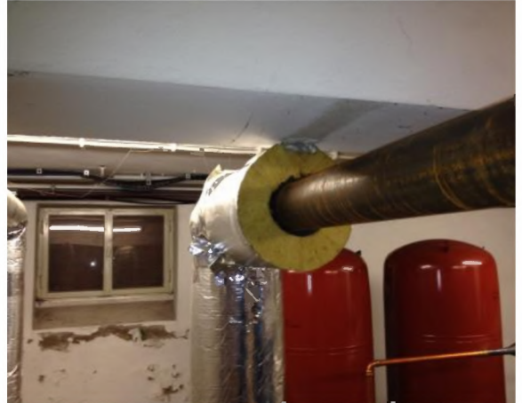
Abb. 21: KMF als Rohrleitungsummantelung
