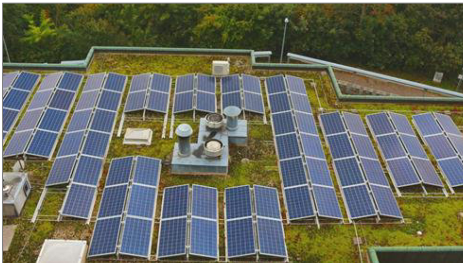
Abbildung 7: Gründach mit Photovoltaik als Ost-West System (Sattel) 6
