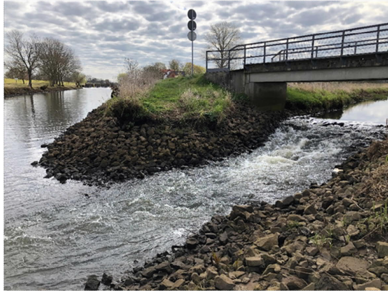
Abb. 2.2.5: Sohlrampe an der Einmündung der Roddau (rechts im Bild) in die Ilmenau mit der Wehranlage Fahrenholz (im Bildhintergrund links) bei Tideniedrigwasser
