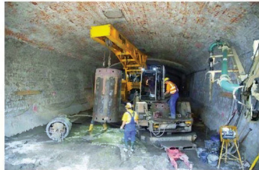
Hamburg, Kasematten: Herstellung unter beschränkter Höhe im Greiferverfahren
