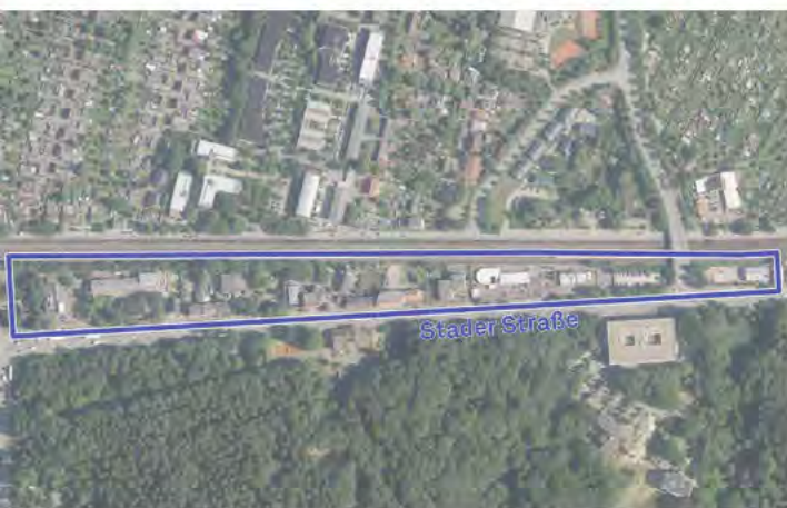
46 Abgrenzung des Lupenraums Bostelbek (Luftbild © Freie und Hansestadt Hamburg Landesbetrieb Geoinformation und Vermessung)
