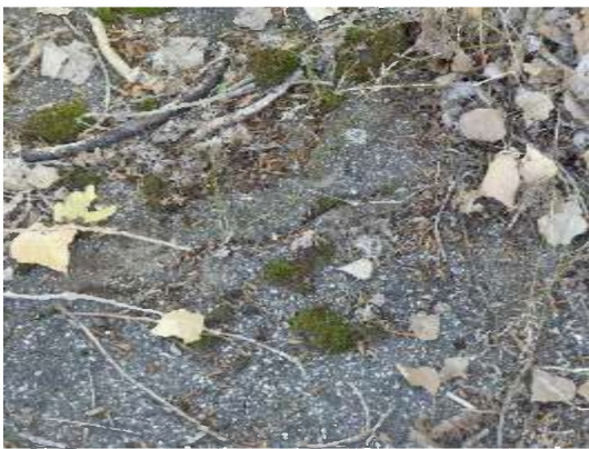
Asphaltriss, als Hinweis auf Wurzel- einwachsungen
