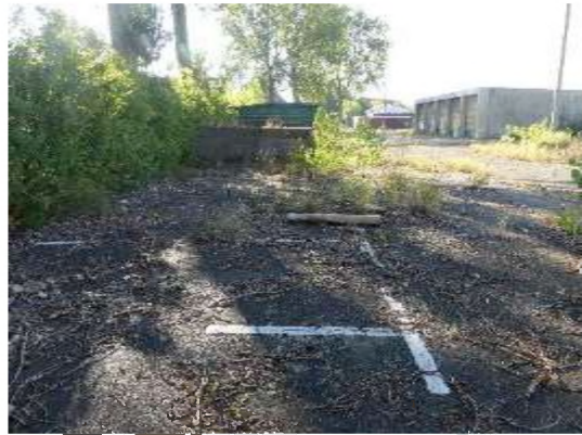
Asphaltfläche auf Betriebshof
