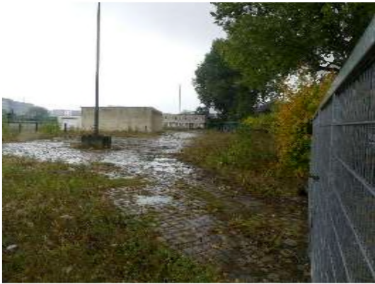
Betriebshof mit Granitgroßpflaster
