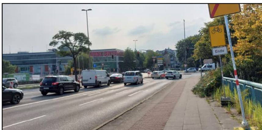
Abb. 14: Walter-Dudek-Brücke, Blick in Richtung Westen
