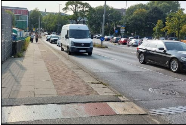
Abb. 20: Walter-Dudek-Brücke, Blick Richtung Westen, südliche Nebenflächen mit untermäßigem Radweg sowie Gehweg
