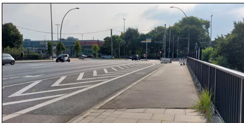
Abb. 12: Hannoversche Str. (Nord), Blick in Richtung Westen auf die Hannoversche Brücke.
