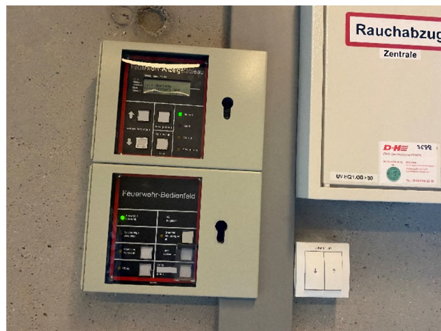
Abbildung 30: Brandmeldezentrale
