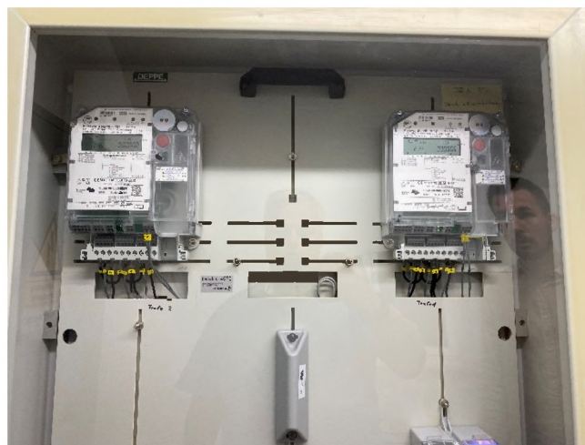
Abbildung 8: Zählerschrank
