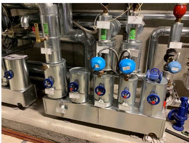
Abbildung 31: Heizungsverteiler
