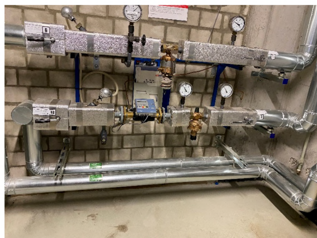
Abbildung 32: Fernwärmeübergabestation
