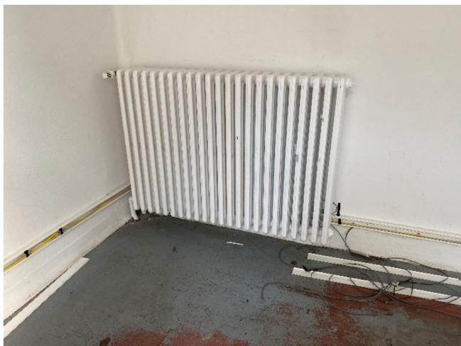
Abbildung 5: Gussheizkörper
