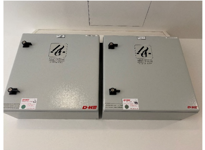
Abbildung 10: RWA-Anlage Treppenhaus
