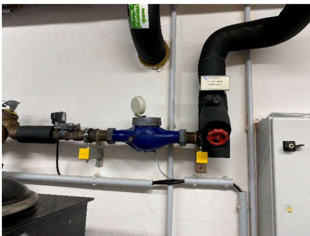
Abbildung 19: Trinkwasserhausanschluss
