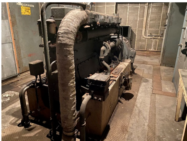
Abbildung 23: Notstromaggregat
