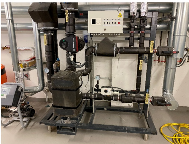
Abbildung 13: Fernwärmeübergabestation UG
