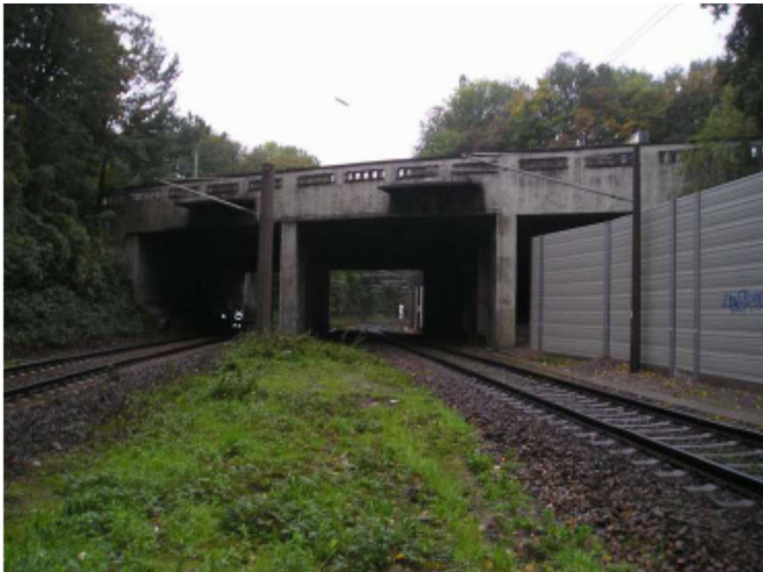
Bestandsbauwerk (Bw-Nr. 102-1), Ansicht von Norden
