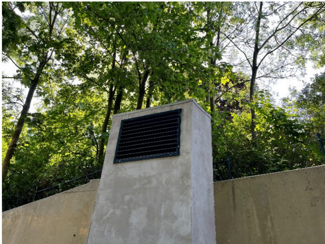
Abbildung 11: Außenluftgitter
