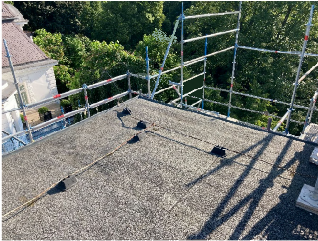
Abbildung 19: Blitzschutzleitungen auf dem Dach
