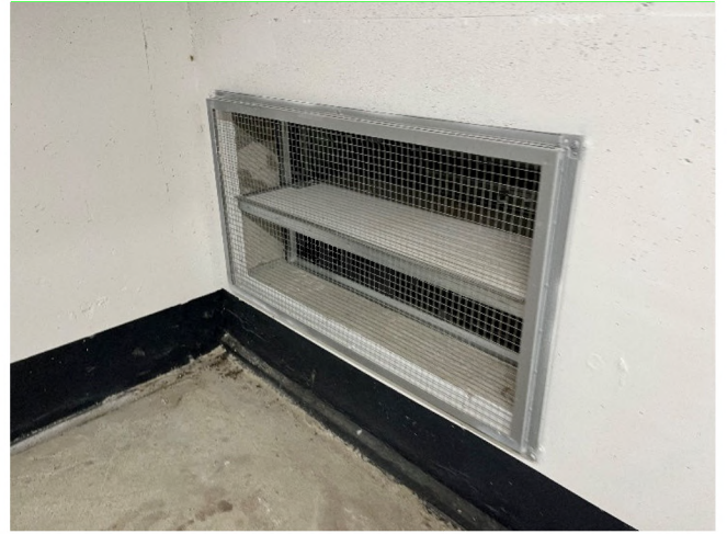
Abbildung 10: Brandschutzklappe mit Lüftungsgitter
