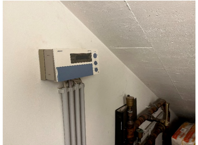
Abbildung 32: Regelgerät für die Fußbodenheizung
