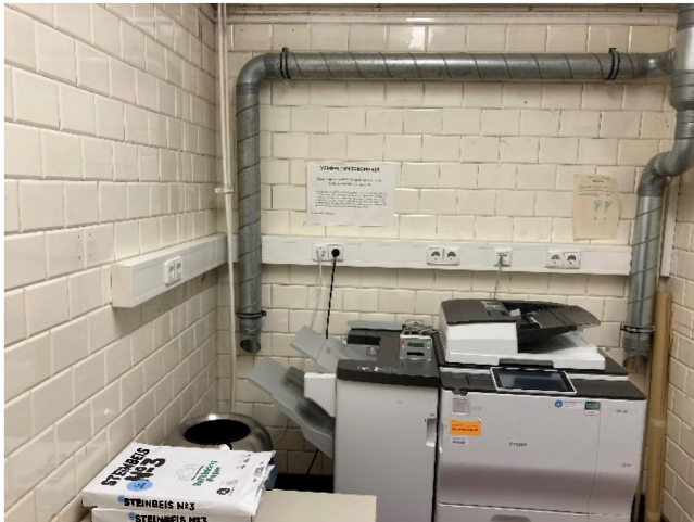
Abbildung 21: Abluftführung im Kopierraum
