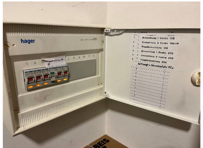
Abbildung 34: Unterverteilung Beleuchtung
