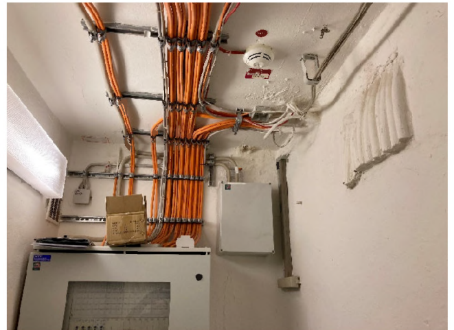
Abbildung 22: Zentrale der Sicherheitsbeleuchtung
