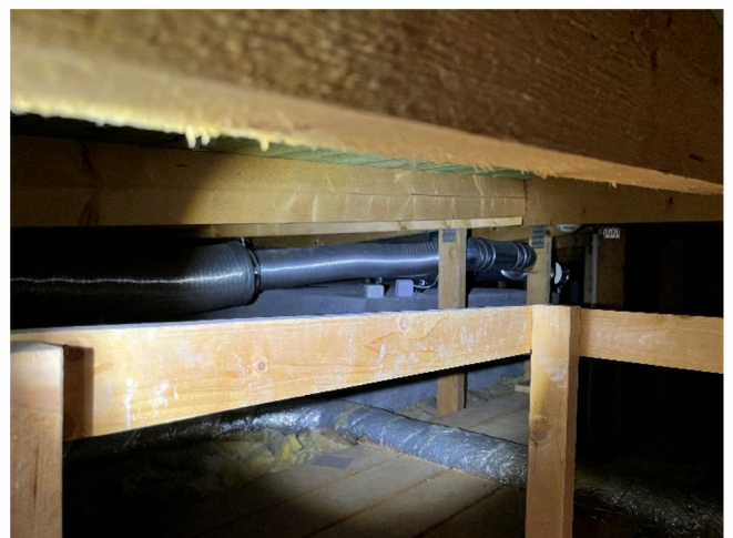
Abbildung 36: Luftleitungsführung in der Zwischendecke
