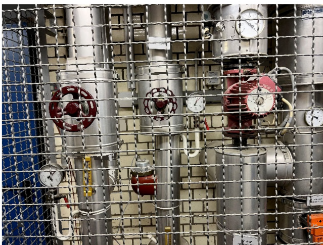
Abbildung 23: Heizkreisverteiler mit Umwälzpumpe
