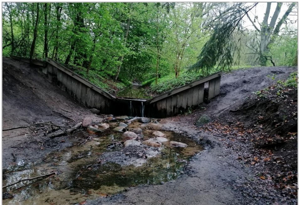
Abb. 10: Sohlabsturz an der Berner Au kurz vor Einmündung in das HRB
