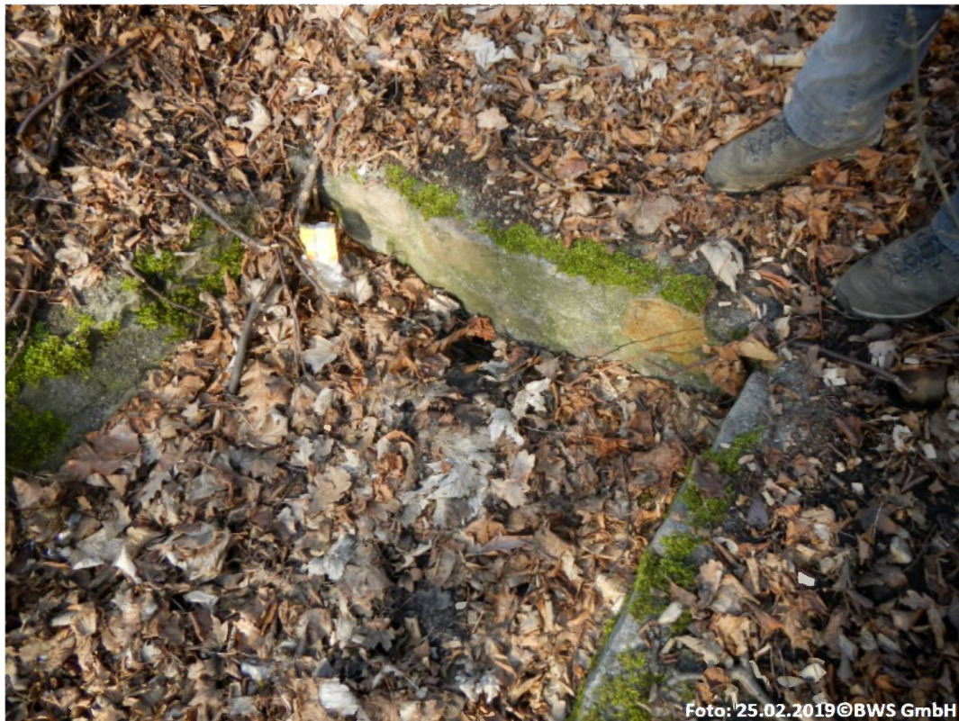
Foto 8: Straßenablauf und Zuleitung in den Bereich des Biotops 4 N 53°29.848' (53°29'50.9") E 9°59.919' (9°59'55.1") [DSCN3587.JPG]
