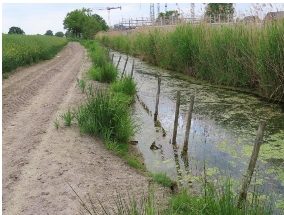
Abbildung 36: Exemplarische Uferschäden entlang eines Grabens im Stadtteil Kirchwerder, Bezirk Bergedorf. Zu sehen ist ein einjähriger Zaun der an der ursprünglichen Grabenkante gesetzt wurde. Quelle: LEWATANA, 2023.
