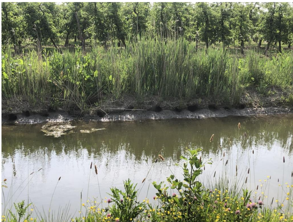
Abbildung 35: Unterhöhltes Ufer eines Grabens im Stadtteil Neuenfelde, Bezirk Harburg. Quelle: LEWATANA, 2023.
