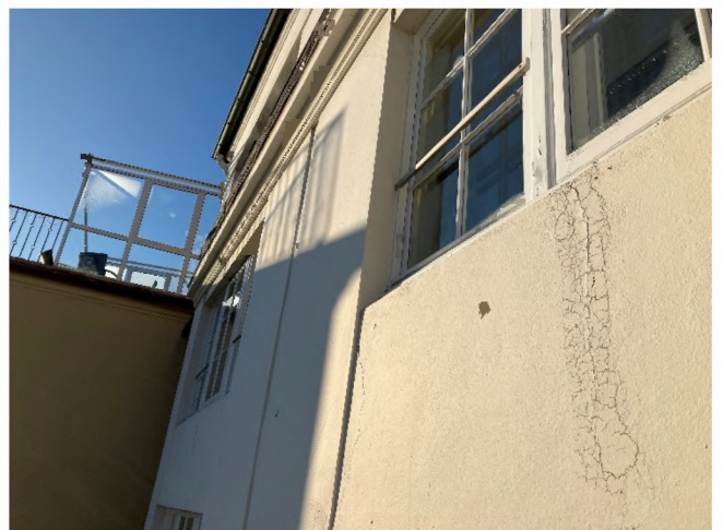
Abbildung 6: Exemplarische Farbabplatzungen Rückseite Gebäude
