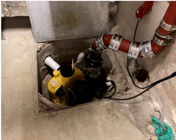
Abbildung 11: Hebeanlage Schmutzw
