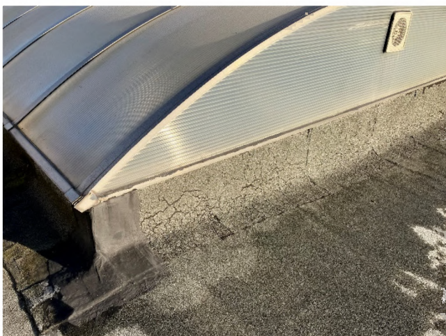
Abbildung 7: Poröse Dachabdichtung
