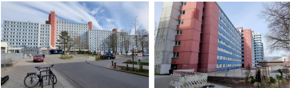
Abbildung 17: Großformatige Gebäude des Berufsförderungswerkes
