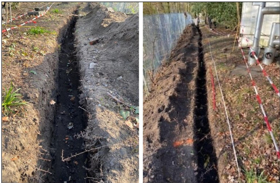
Abb. 32: In dem ca. 30 m langen Wurzelsuchgraben entlang des Grenzzaunes konnten bis in ca. 1 m Tiefe kaum Wurzeln vorgefunden werden (aus der Stellungnahme von [REDACTED] vom 22.08.2022)
