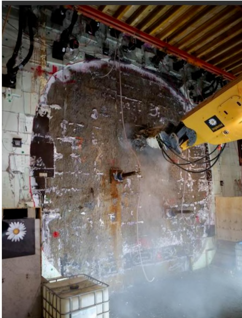
Abbildung 242 Anschlagwand des Tunnels, nachdem der Baugrund gefroren wurde. (Quelle: Amberg Engineering)
