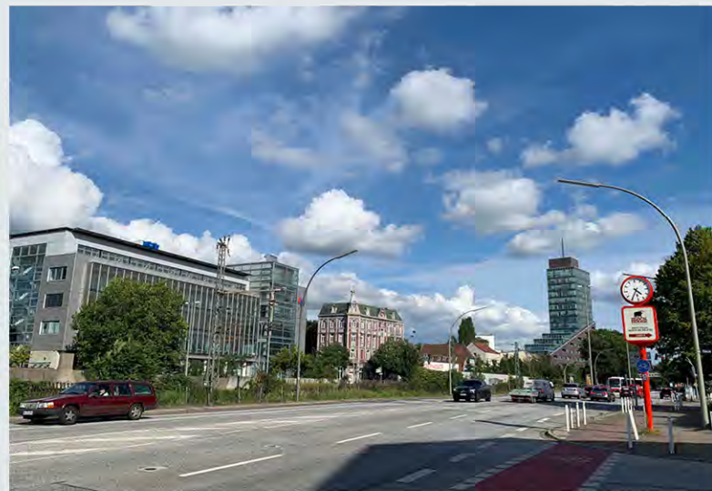
Blick zum Channel Tower
