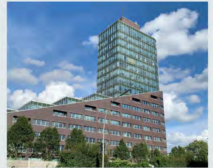
Orientierungspunkt Channel Tower
