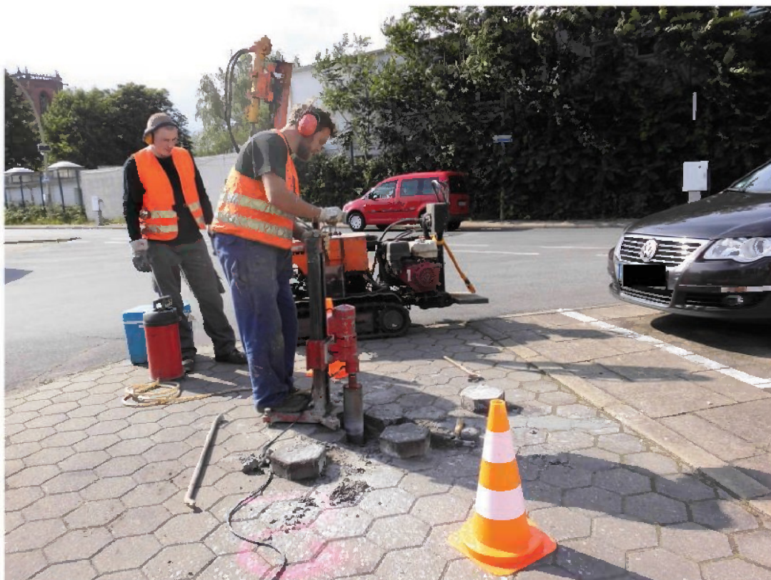
RKS 2 im Nordostteil des Busbetriebshofes, Kernbohrung wegen oberflächennaher Betonlage
