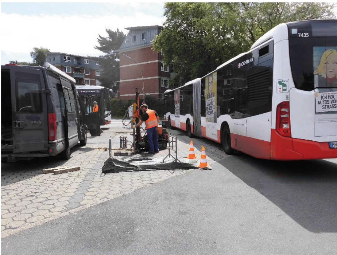
RKS 6 im Südwestteil des Busbetriebshofes (Auffüllung enthält hier teilw. Teerklumpen)
