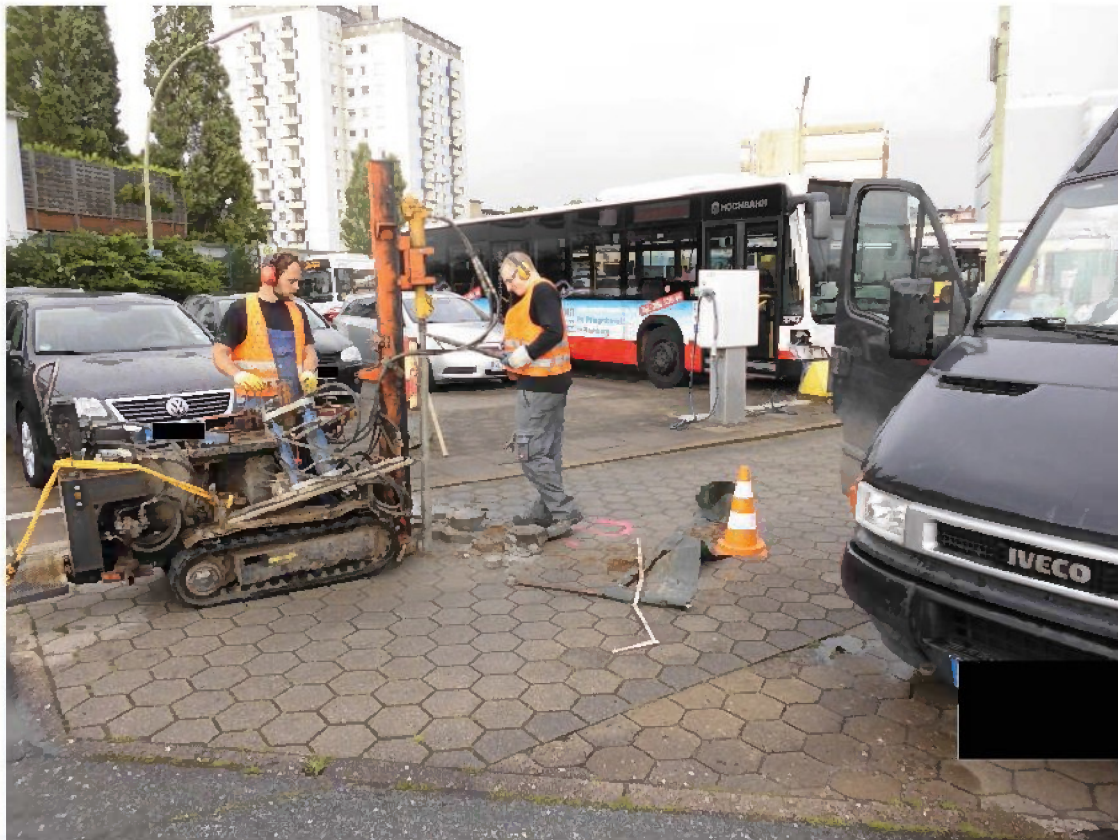
RKS 2 Durchführung der Rammkernsondierung
