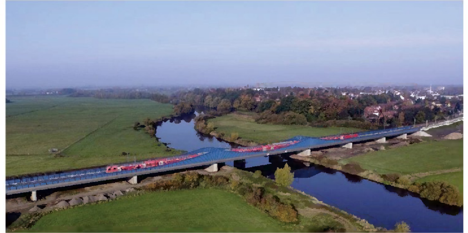
Eisenbahnbrücke über die Aller, Verden
