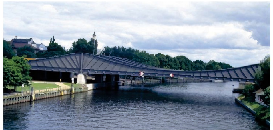
Havelbrücke, Berlin (Spandau)
