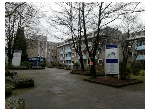
Abb. 1: Bestand Seniorenzentrum, Westfassade (Foto: 11.02.2022)
