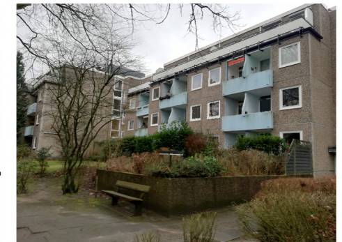
Abb. 2: Bestand Seniorenzentrum, Westfassade (Foto: 11.02.2022)
