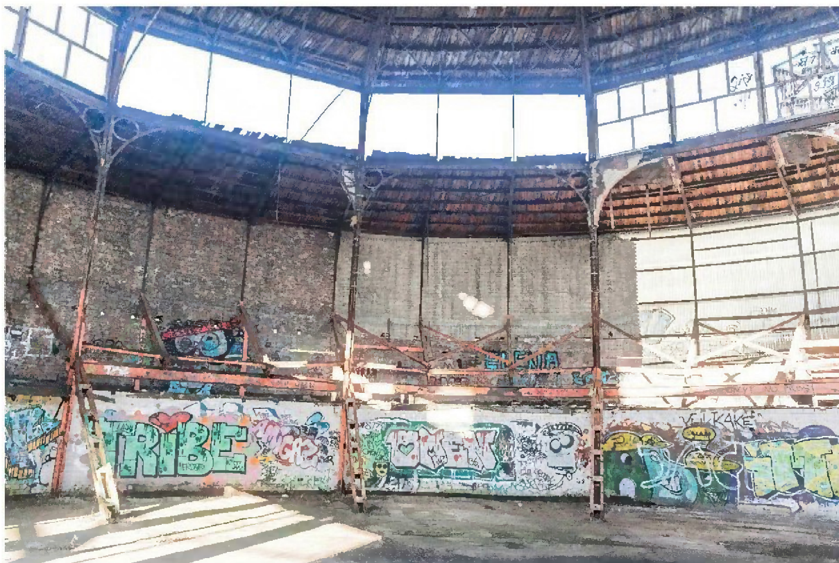
Blick auf den Rundanbau, die Tribünen-Konstruktion und die Innenstützen
