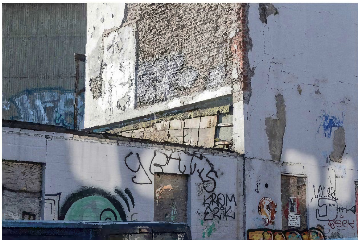
Außenansicht Anbauten im Außenbereich der Schiller-Oper
