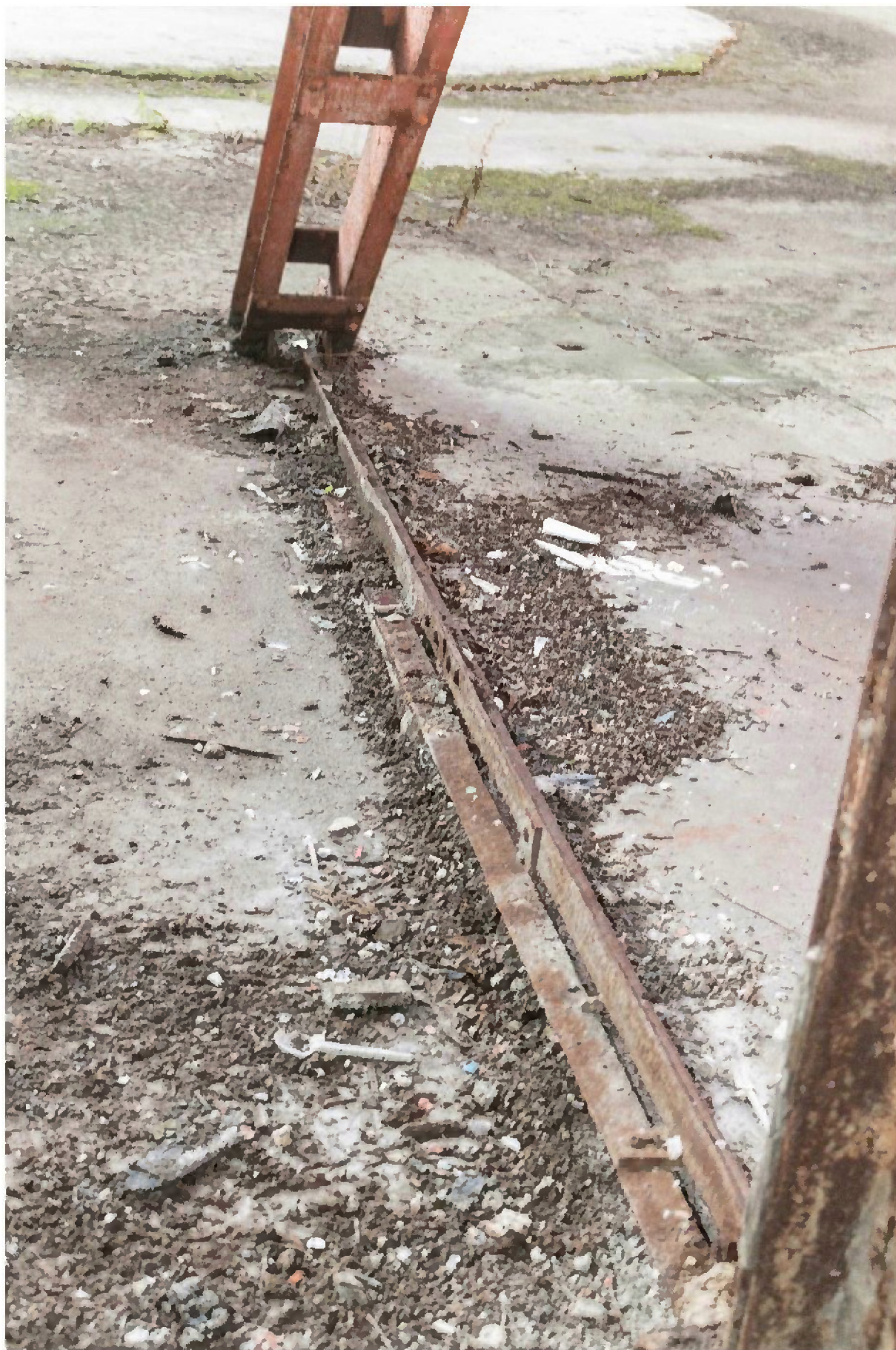
Blick entlang des in der Fußbodenebene verlaufendem Zugbands des unteren Tribünenrängers (hier ohne Substanzverlust)
