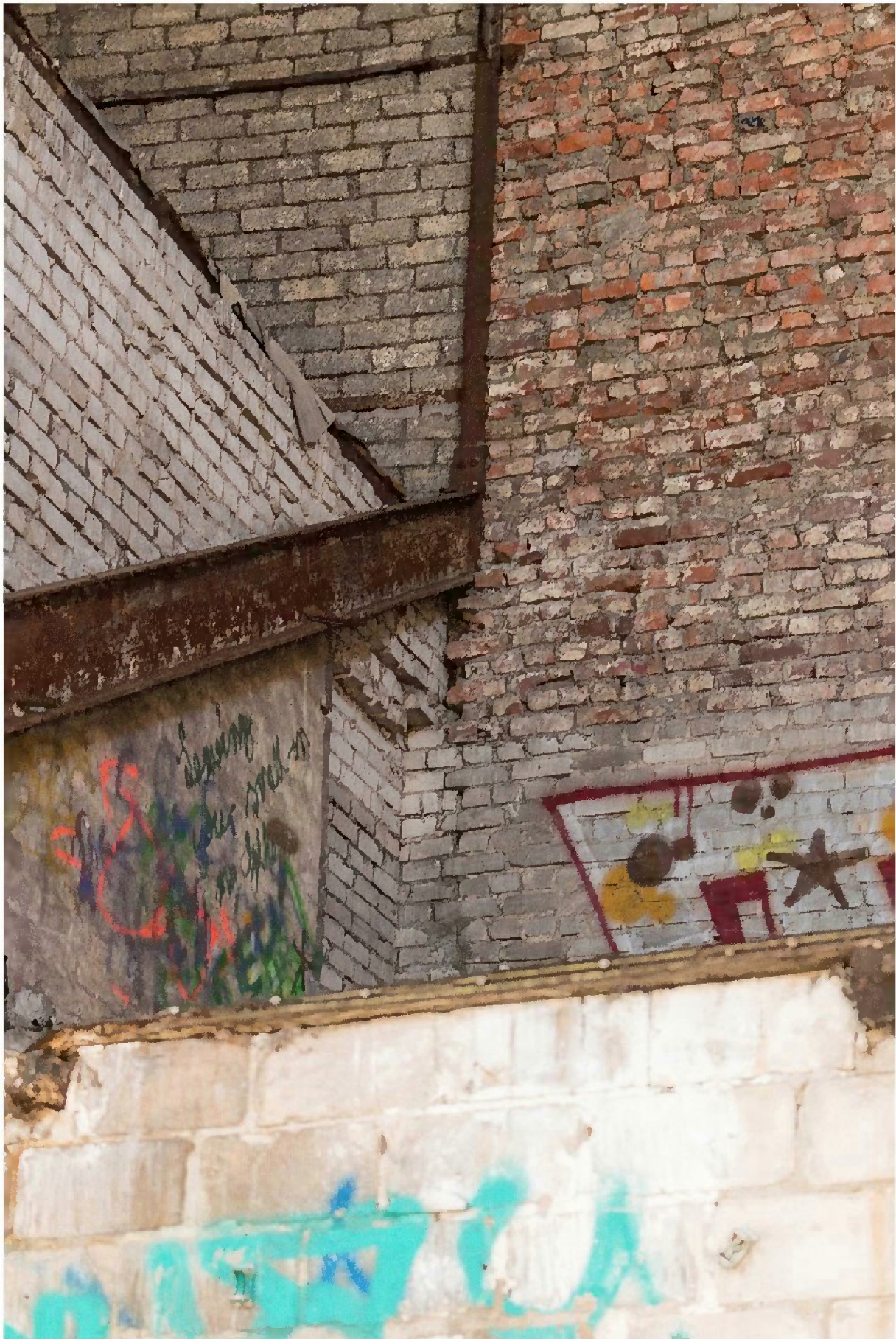
Außenstütze des Rندانbaus im unteren Bereich sichtbar (einzige Punkt an der die Stütze unterhalb des Tribünenträgeranschlusses zu erkennen ist)
