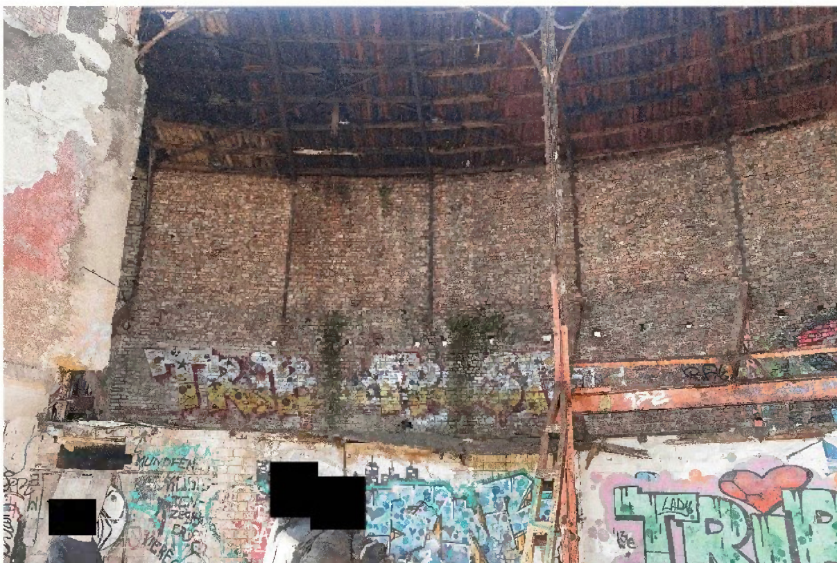
Blick auf die Außenstützen des Rundanbaus (Stützen nur in oberen Bereich sichtbar, evtl. im unteren Teil nicht mehr vorhanden)
