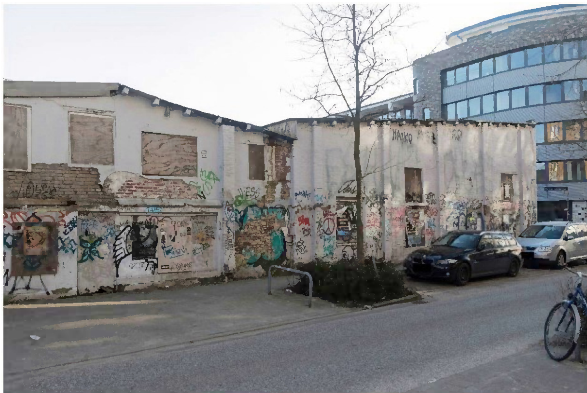
Außenansicht Anbauten im Außenbereich der Schiller-Oper
