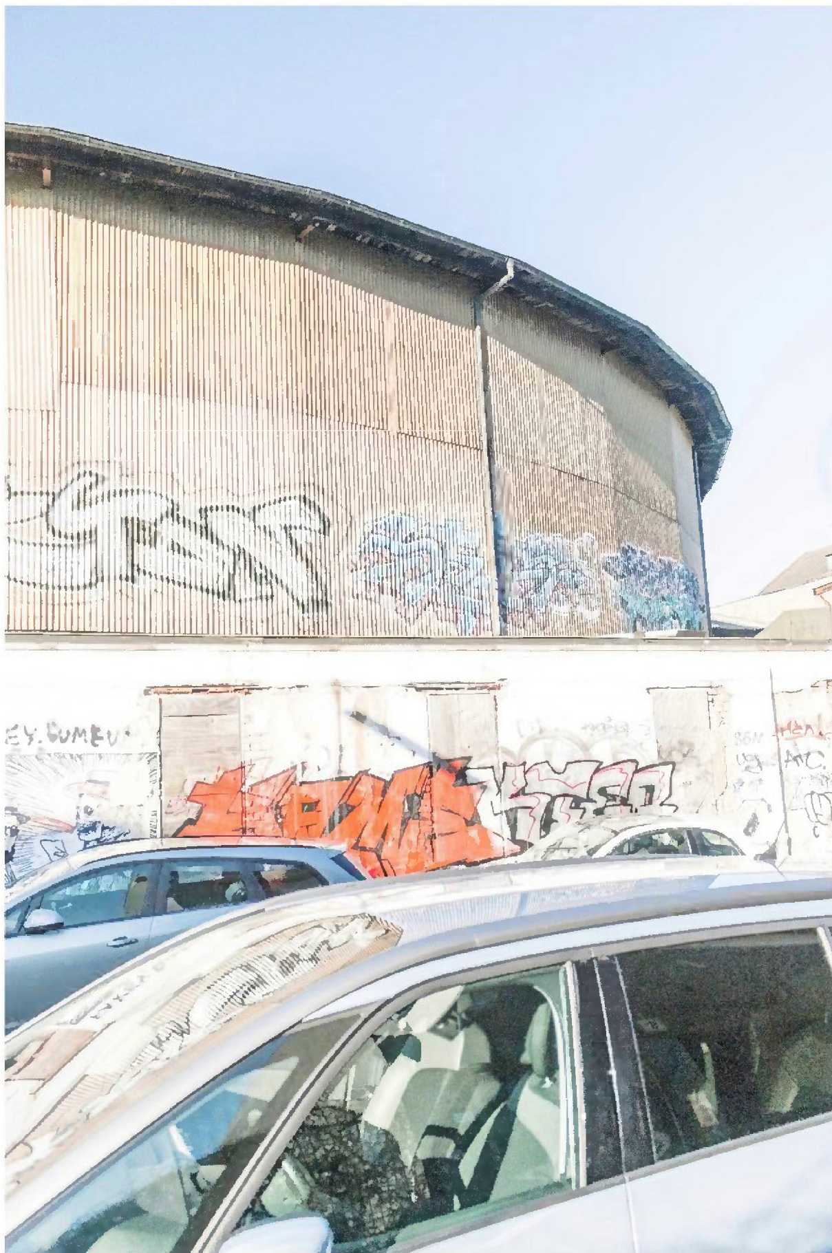
Außenansicht Anbauten im Außenbereich der Schiller-Oper
