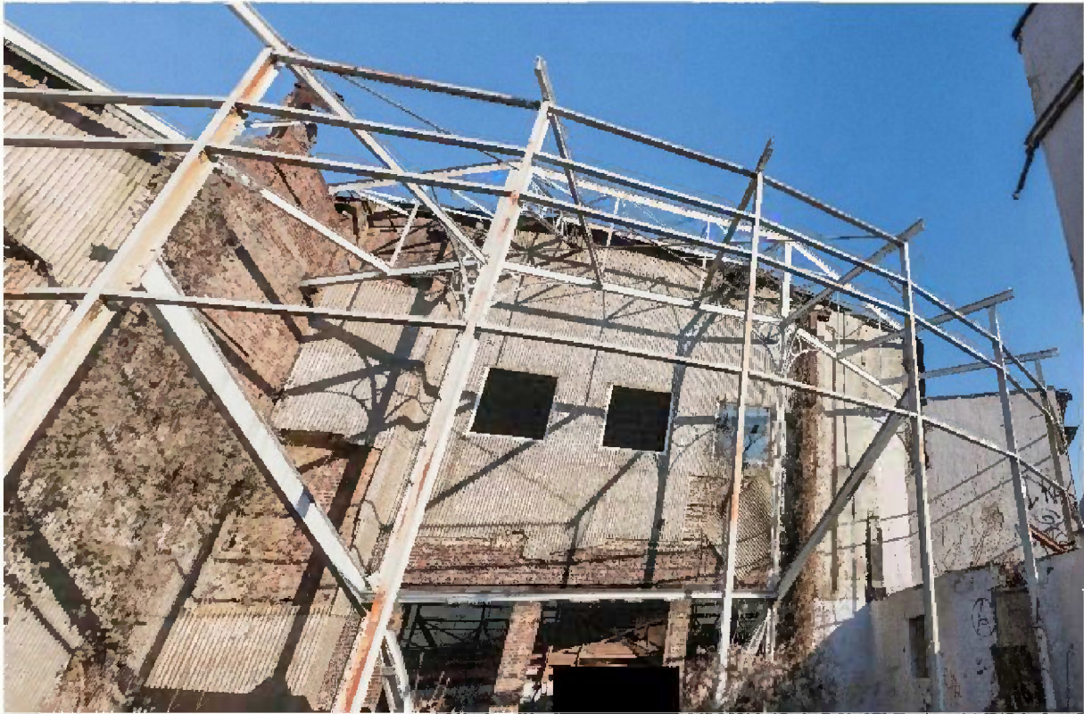
Blick auf die wiederhergestellte Rundbau-Konstruktion im Außenbereich
