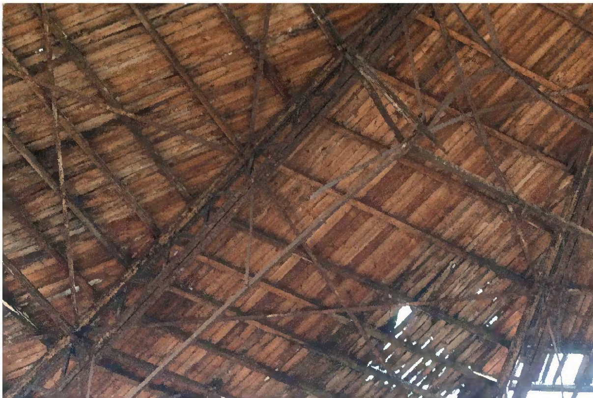
Fachwerkbinder im Feldbereich zwischen Druck- und Zugring
