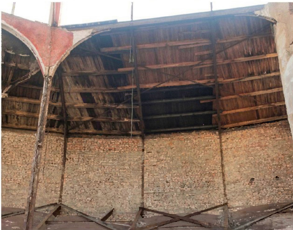
Sparrendach-Konstruktion des Rundanbaus oberhalb der Tribüne
