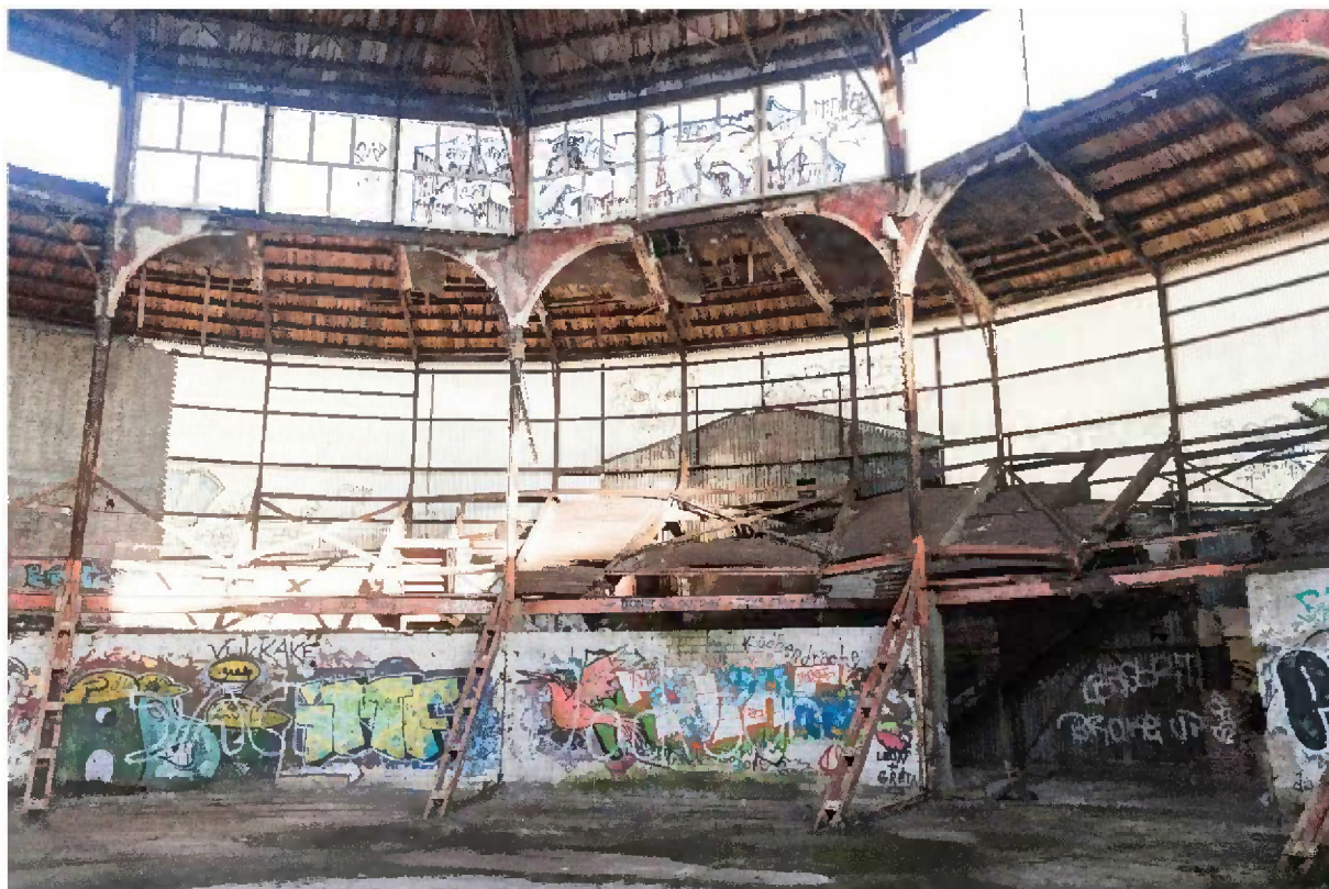
Blick auf den Rundanbau, die Tribünen-Konstruktion und die Innenstützen (Kreuzstützen)
