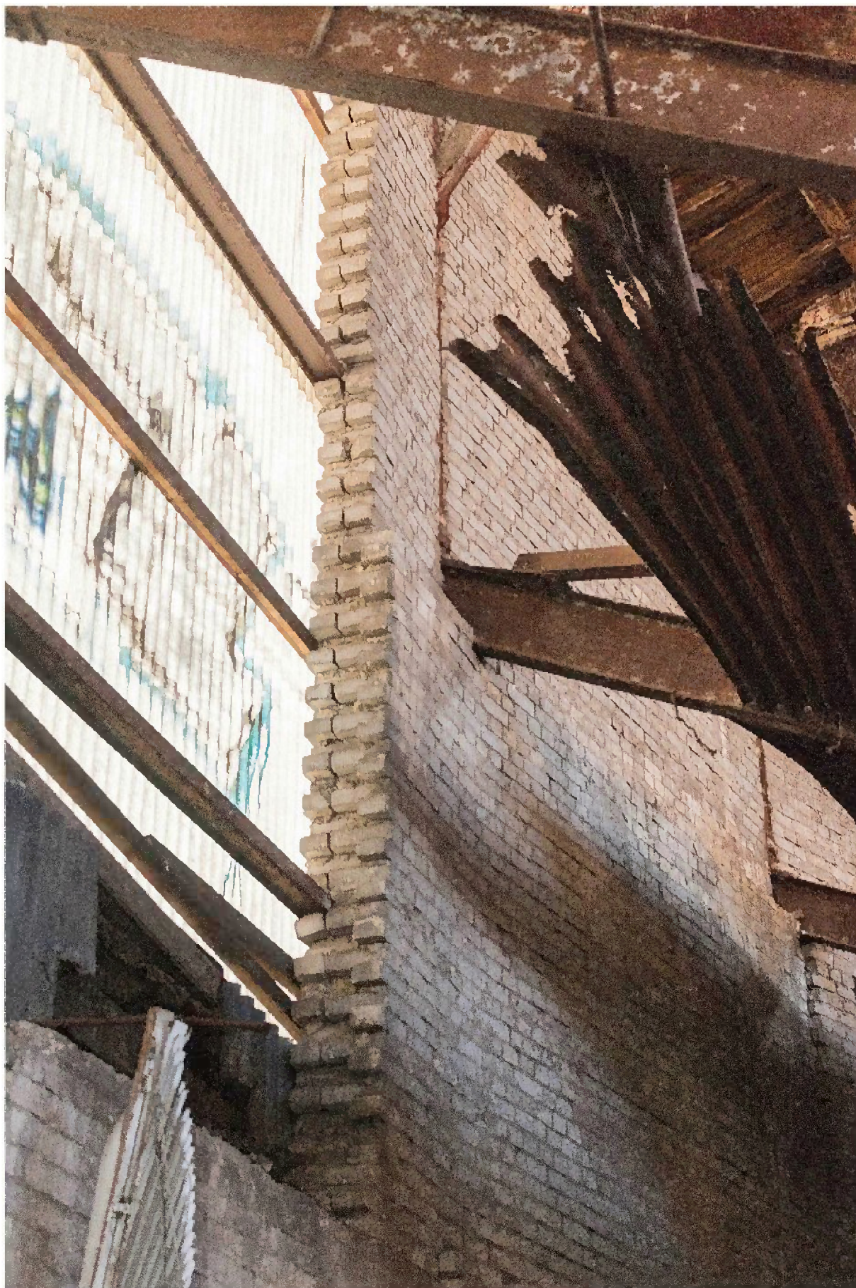
Mauerwerk unterhalb des Anschlusspunktes der Außenstützen des Rundanbaus und der oberen Tribünenträger (vorgesetztes Mauerwerk verdeckt die Sicht auf den unteren Teil der Stützen)
