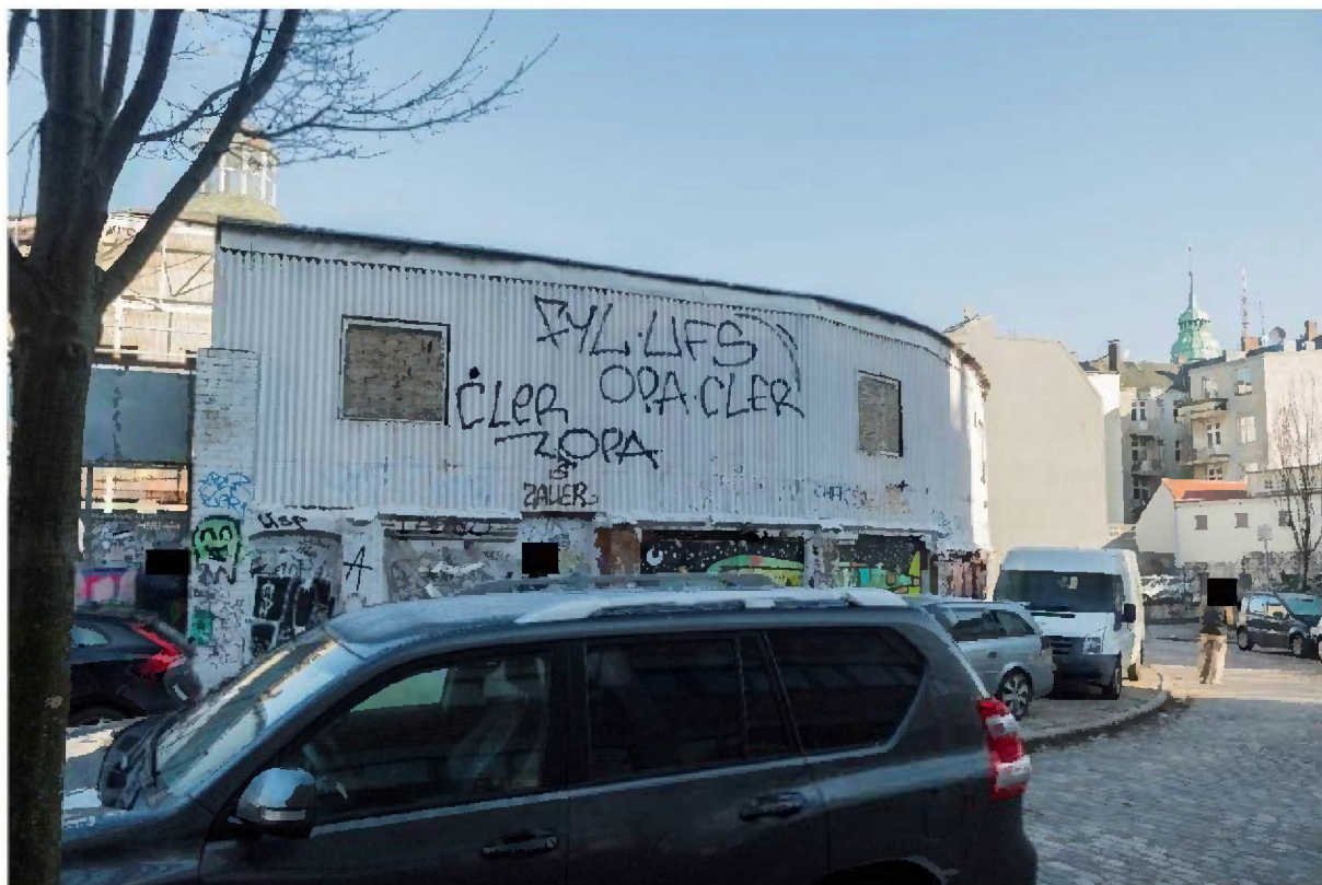
Außenansicht Anbauten im Außenbereich der Schiller-Oper
