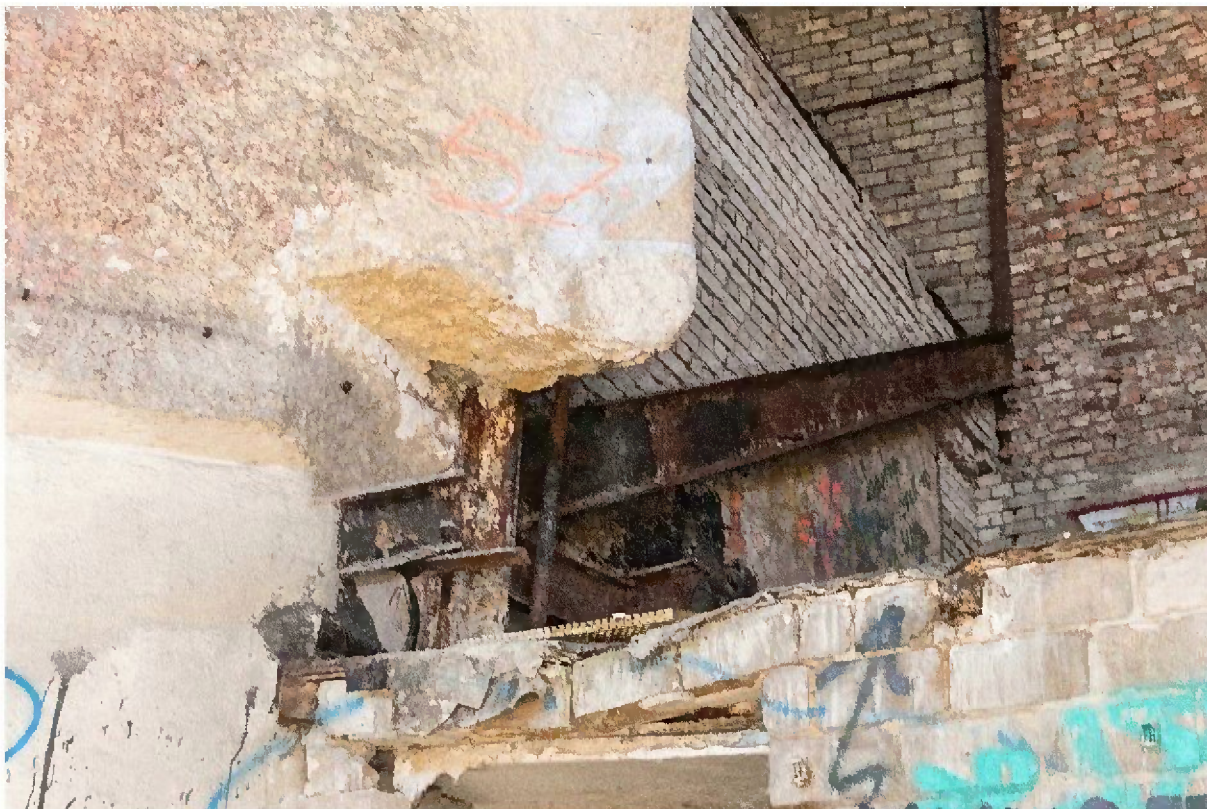
Tribüenträger im Übergangsbereich zur ehem. Bühne
