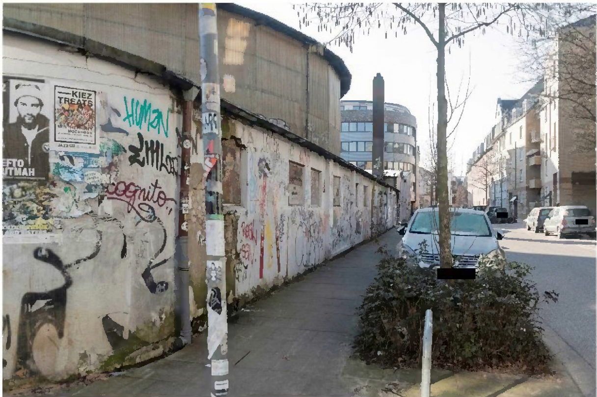
Außenansicht Anbauten im Außenbereich der Schiller-Oper
