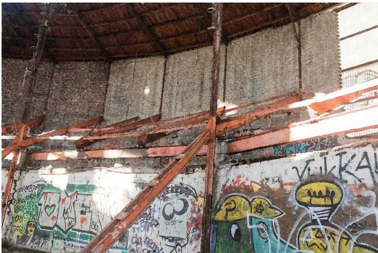
Blick auf die Tribünen-Konstruktion
