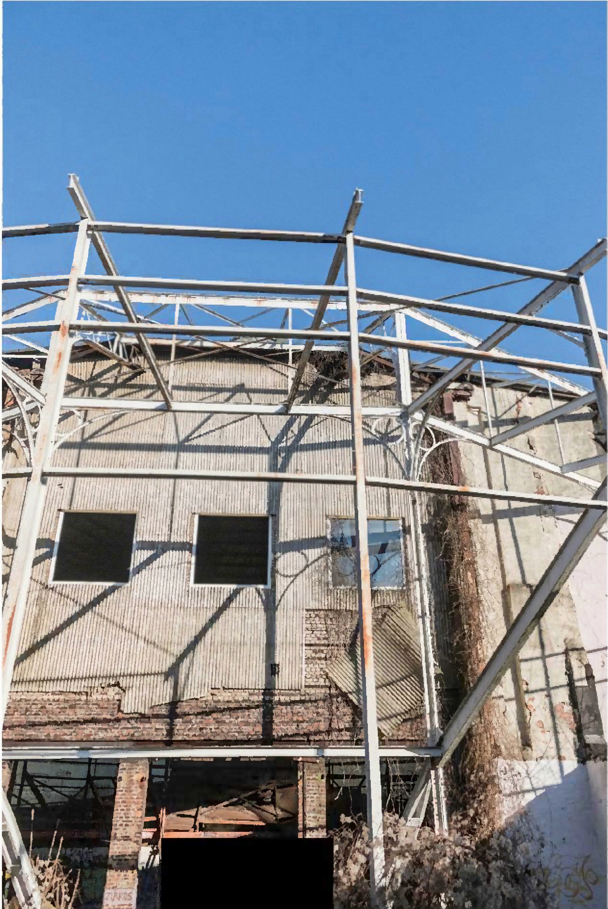
A Blick auf die wiederhergestellte Rundbau-Konstruktion im Außenbereich
