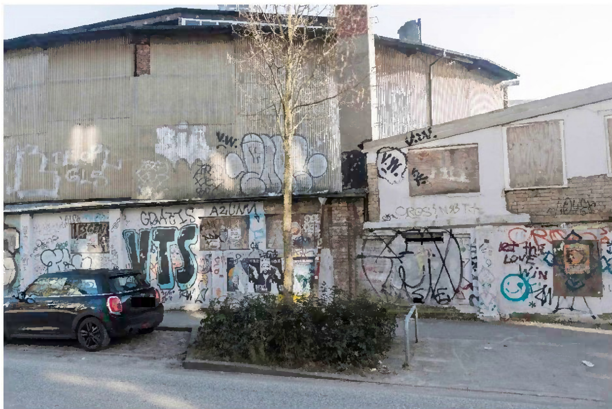
Außenansicht Anbauten im Außenbereich der Schiller-Oper
