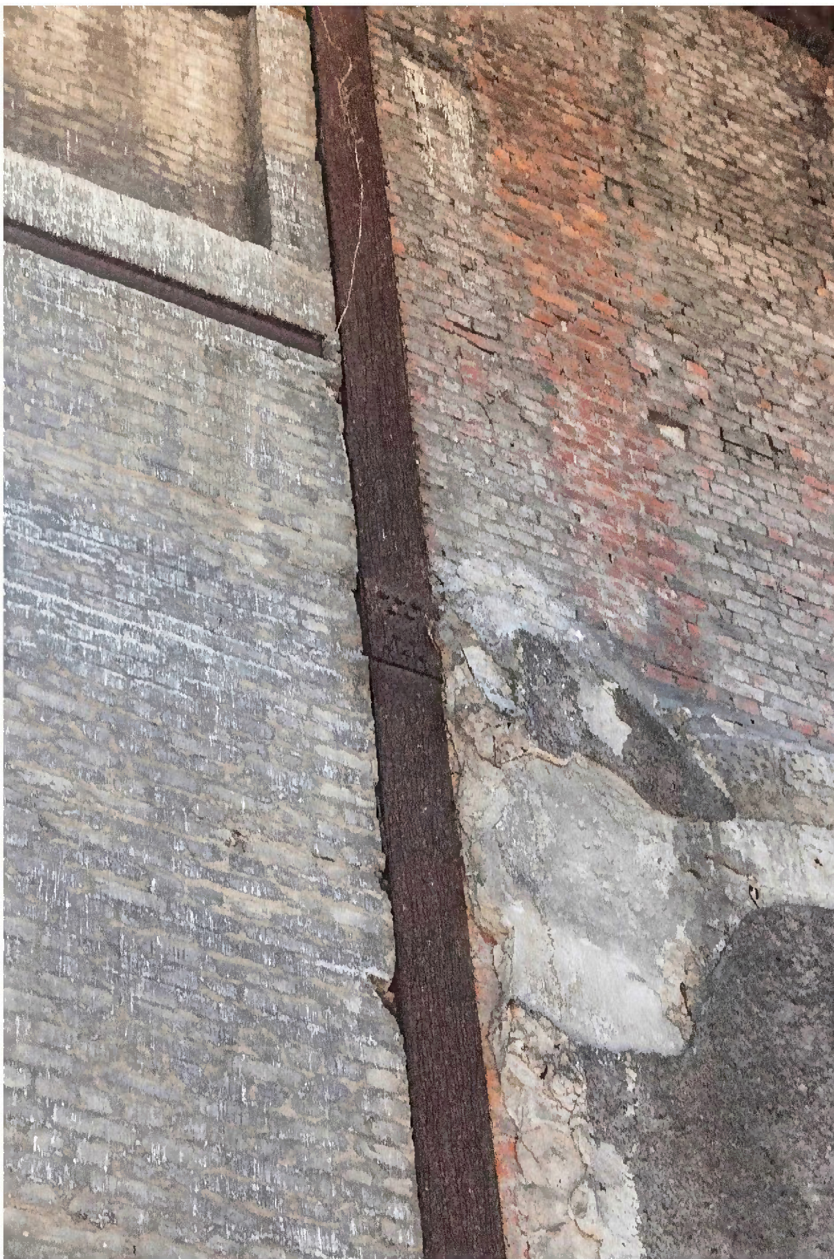
Portalstütze mit Laschenstoß (unten genietet oben geschraubt)
