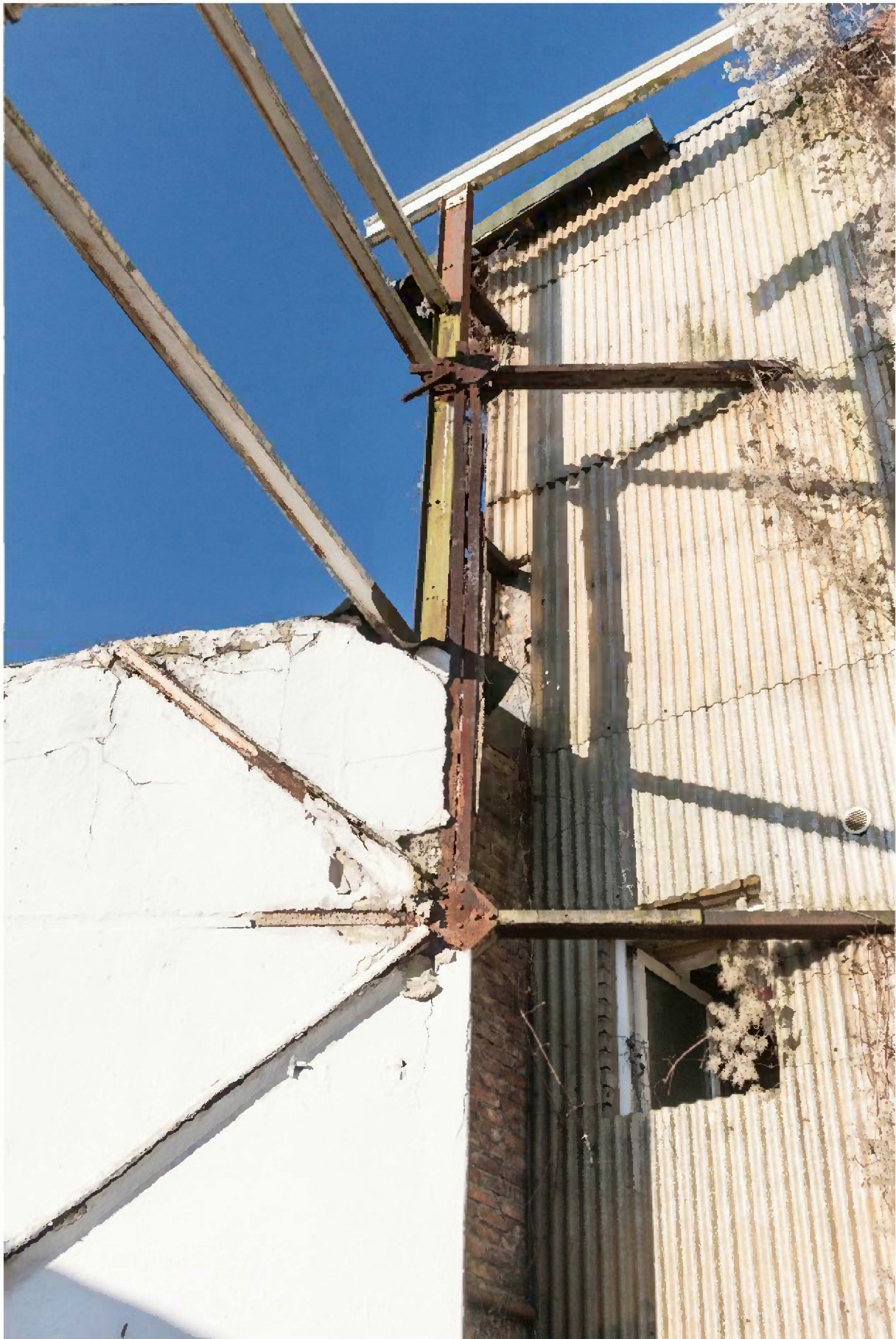
Anschluss Bestandskonstruktion an die wiederhergestellte Rundbau-Konstruktion
