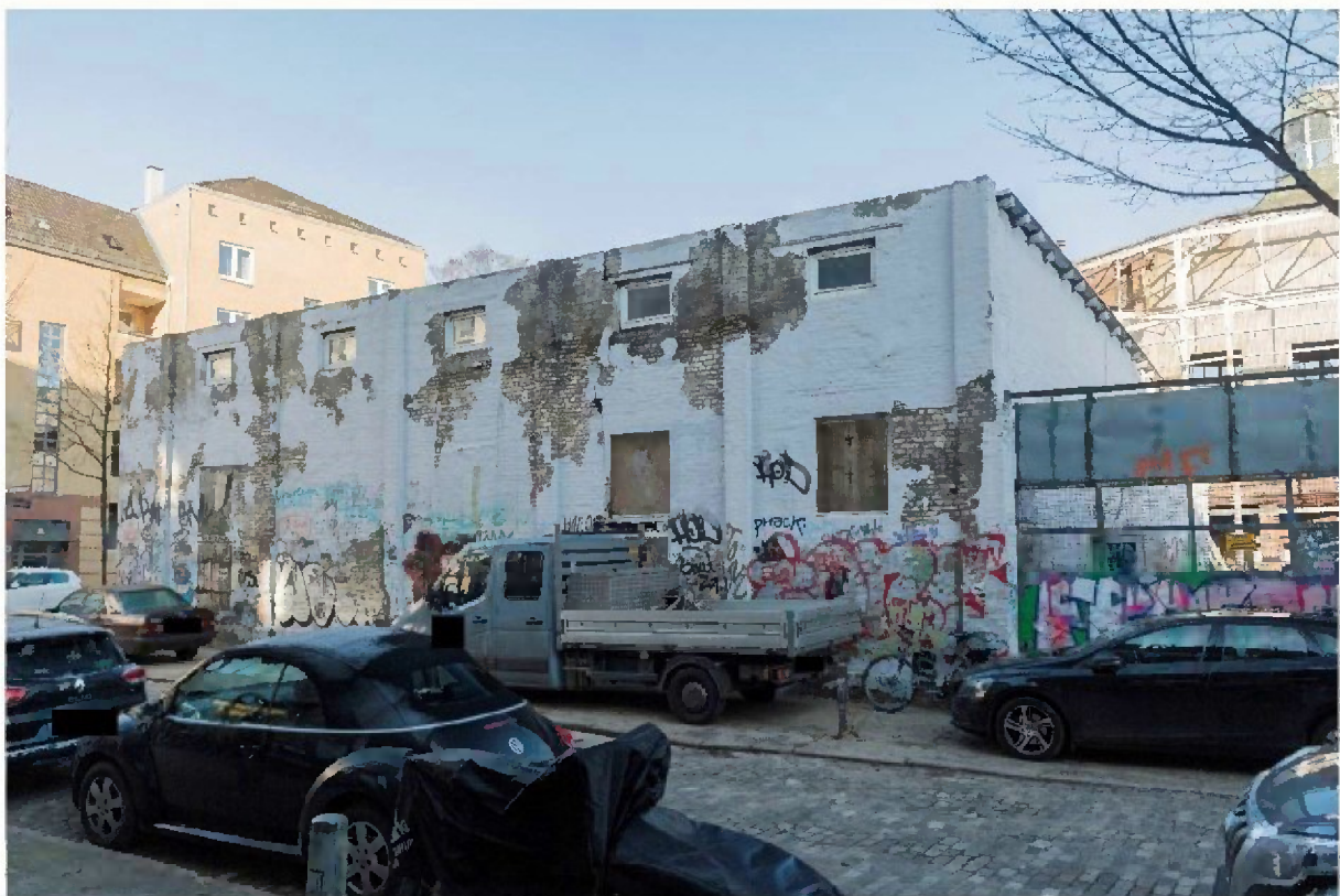
Außenansicht Anbauten im Außenbereich der Schiller-Oper
