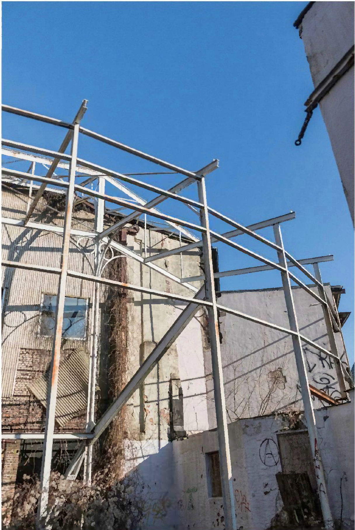
Blick auf die wiederhergestellte Rundbau-Konstruktion im Außenbereich
