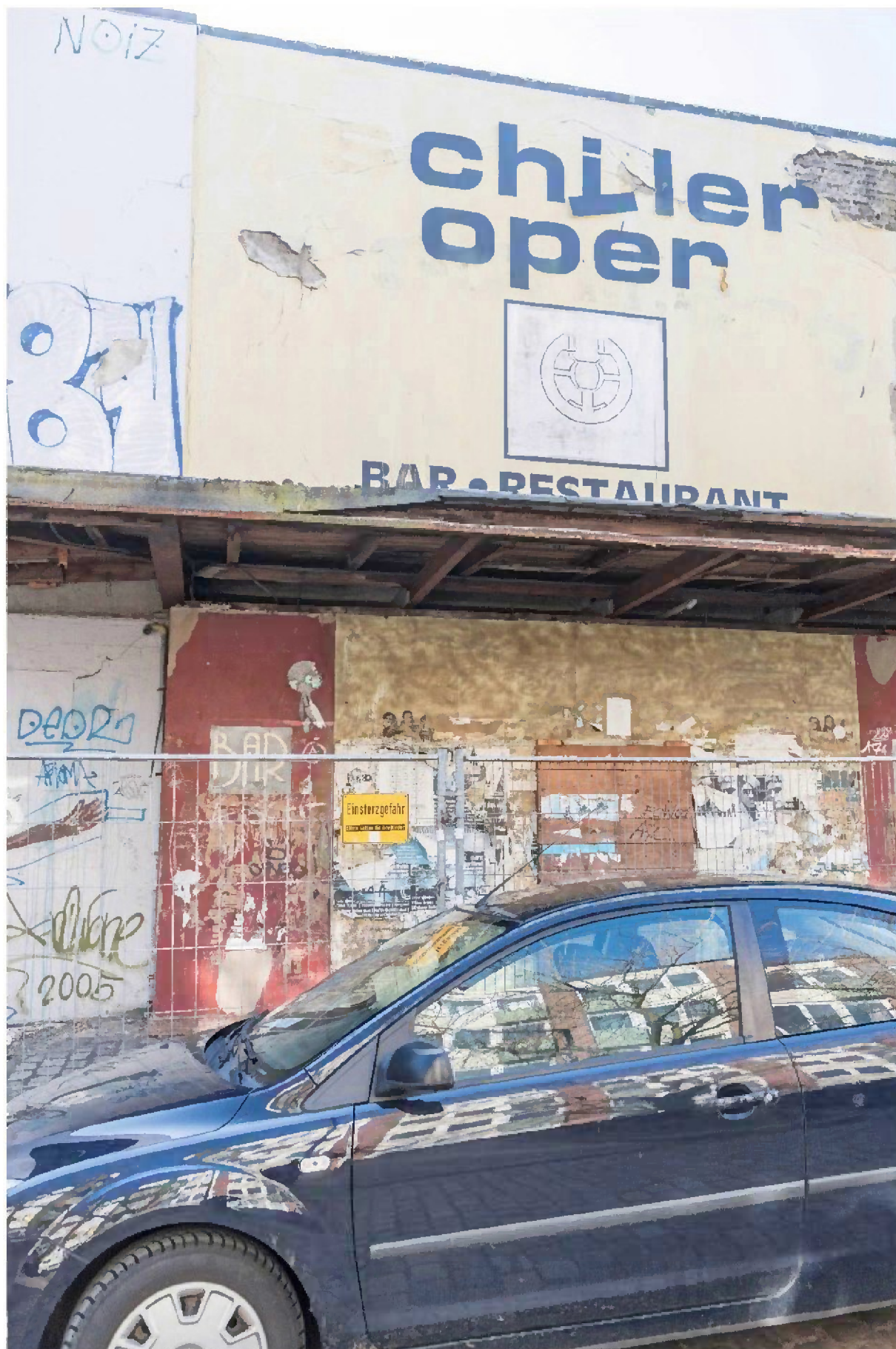
Außenansicht Anbauten und Vordach-Konstruktion im Außenbereich der Schiller-Oper
