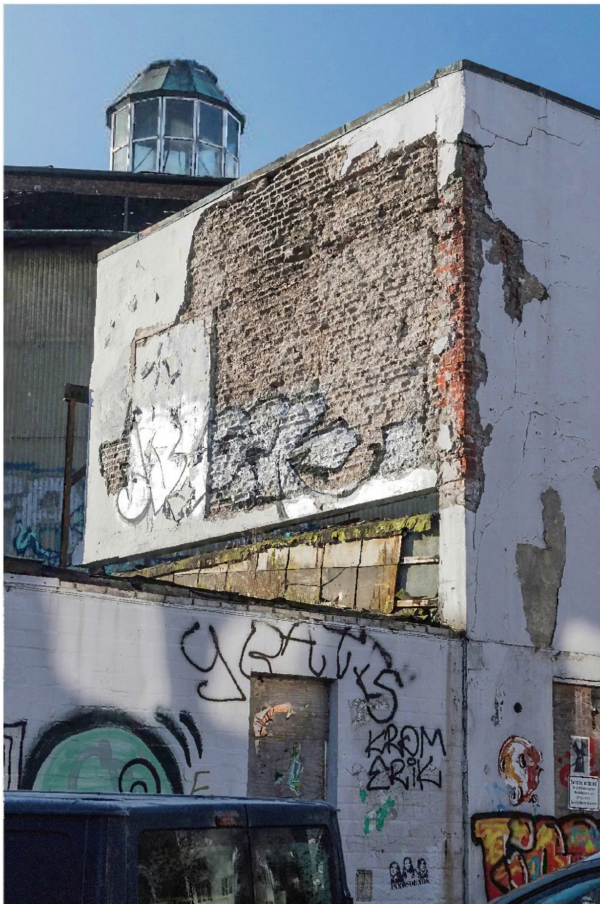
Außenansicht Anbauten im Außenbereich der Schiller-Oper
