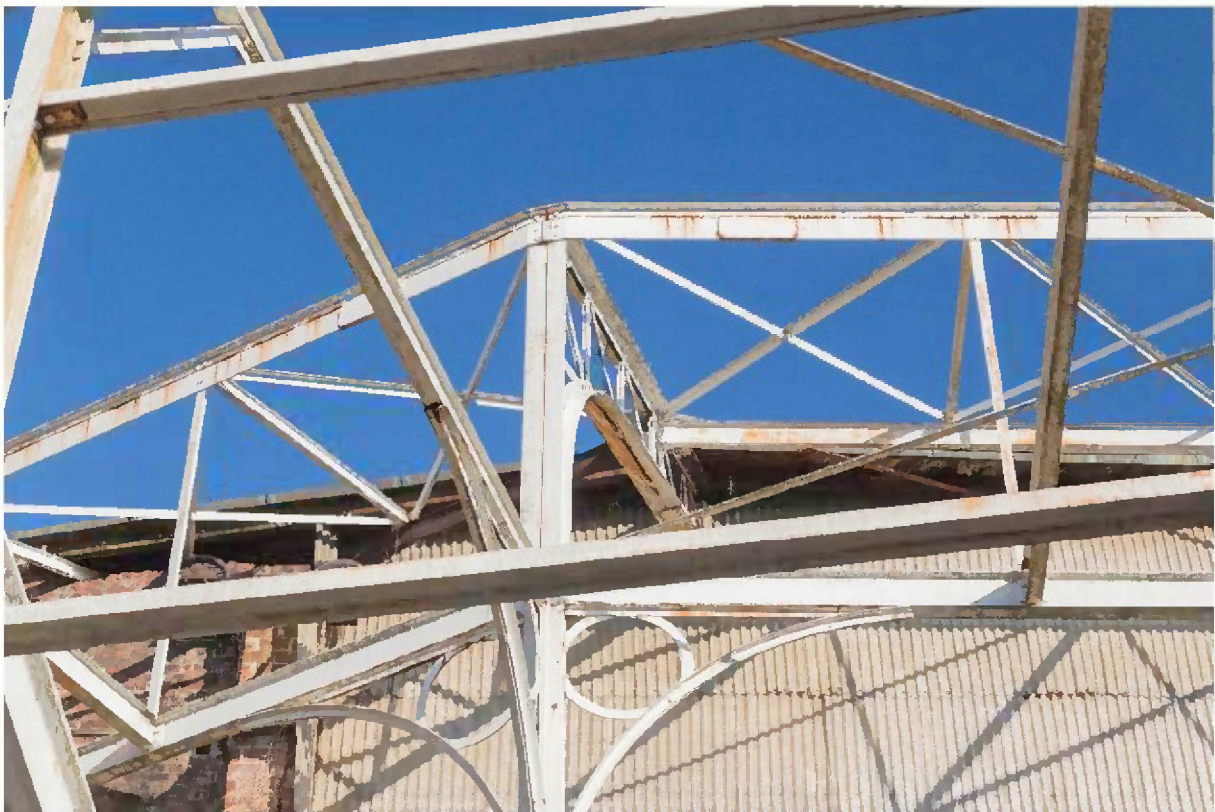
Blick auf den wiederhergestellten Fachwerkbinder (auch hier ist das Ausknicken der Diagonalen erkennbar)
