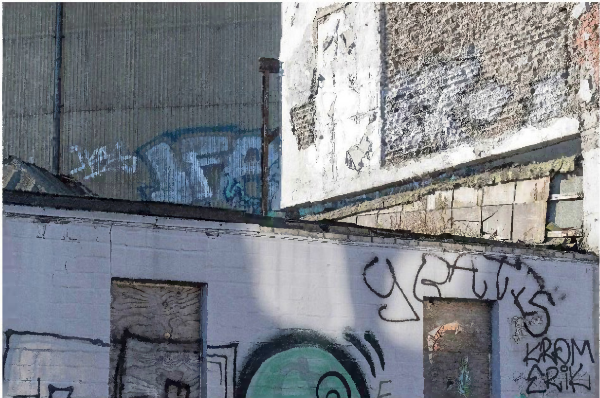
Außenansicht Anbauten im Außenbereich der Schiller-Oper
