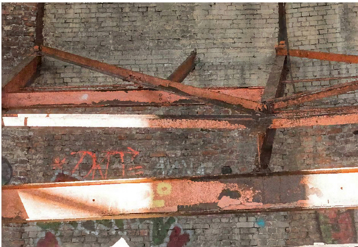
Wechsel in der Tribünen-Konstruktion mit ins Mauerwerk verlaufendem Nebenträger
