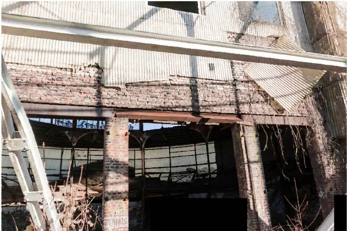
Blick von außen auf das Portal (Abfangeträger gekippt und durch Laschen am Untergurt gesichert)
