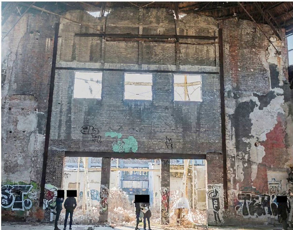
Innenansicht des ausgemauerten Portals (ehem. Bühne)
