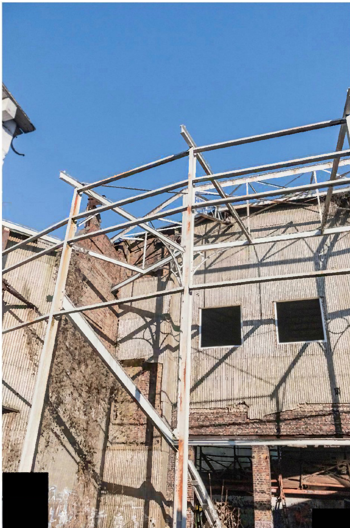
Blick auf die wiederhergestellte Rundbau-Konstruktion im Außenbereich
