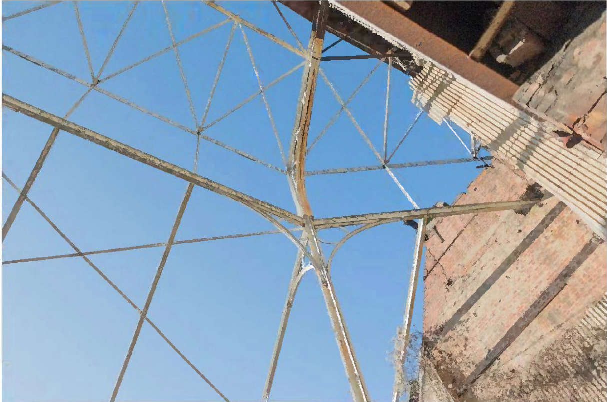
Blick auf die wiederhergestellte Rundbau-Konstruktion im Außenbereich
