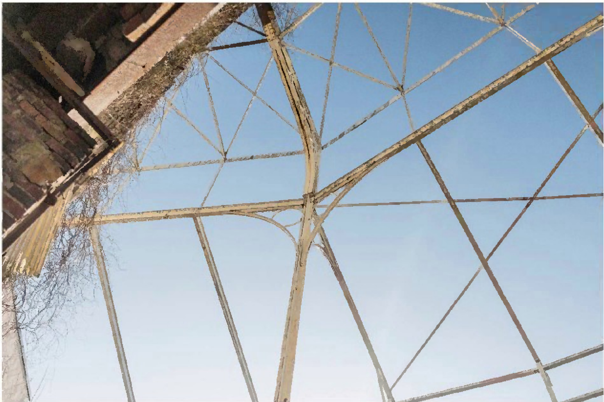
Blick auf die wiederhergestellte Rundbau-Konstruktion im Außenbereich
