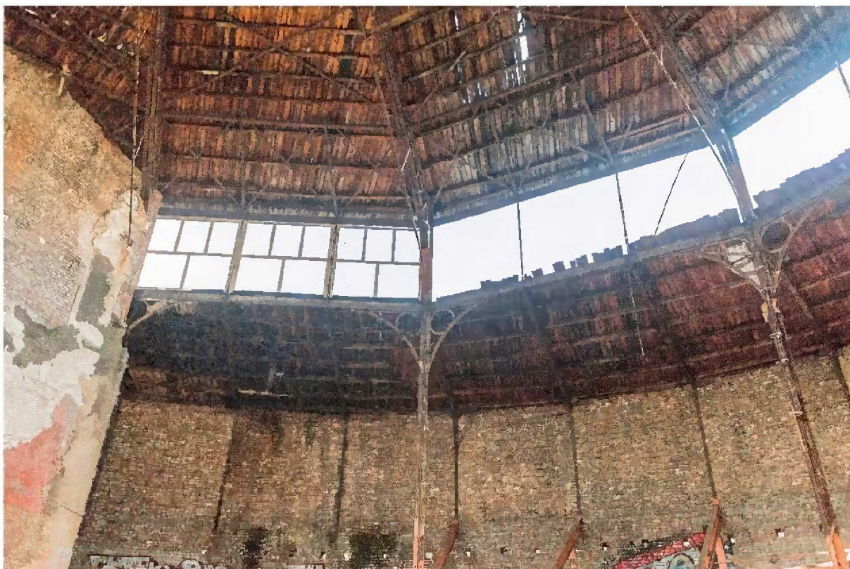
Blick auf die Kreuz-Stützenköpfe, die Rundanbau-Sparren-Konstruktion und die darüberliegende teilw. verglaste Traufe
