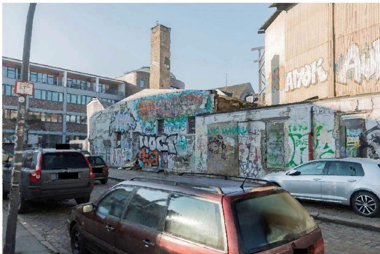
Außenansicht Anbauten im Außenbereich der Schiller-Oper
