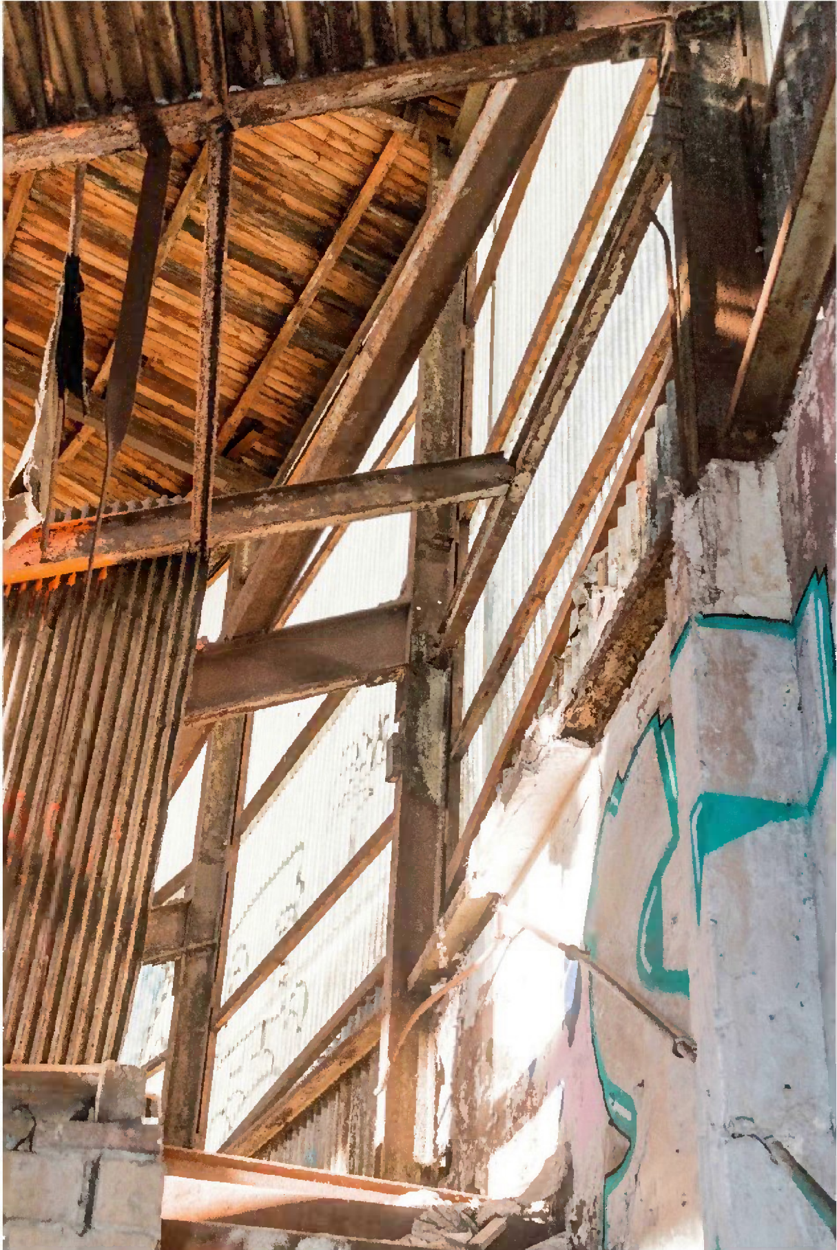
Anschlusspunkt des oberen Tribünenträgers und der Außenstützen des Rundanbaus
