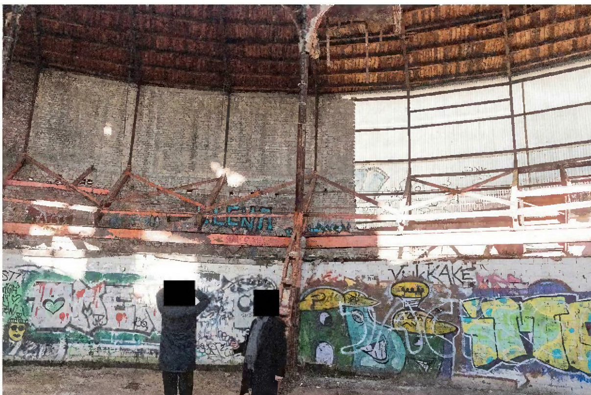
Blick auf die Tribünen-Konstruktion mit Ausfachung
