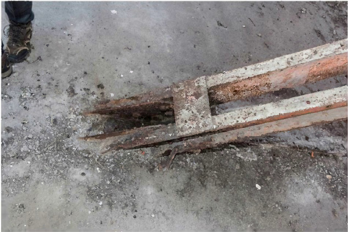
Fußpunkt des unteren Tribünenträgers
