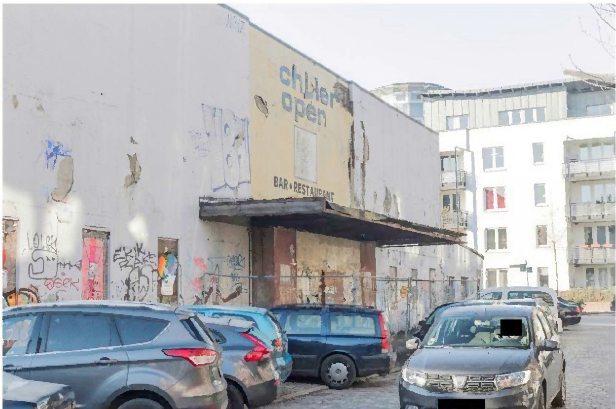
Außenansicht Anbauten und Vordach-Konstruktion im Außenbereich der Schiller-Oper
