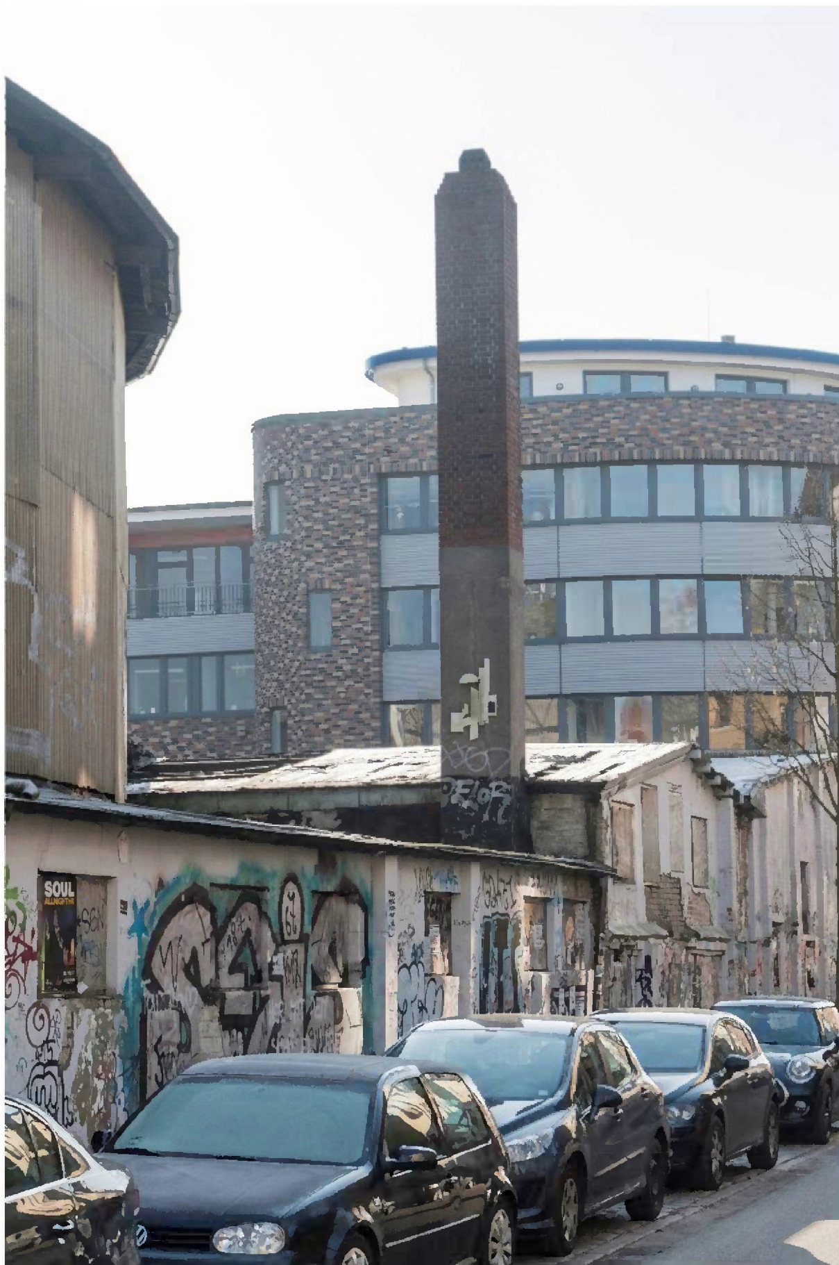
Außenansicht Anbauten und Schornstein im Außenbereich der Schiller-Oper
