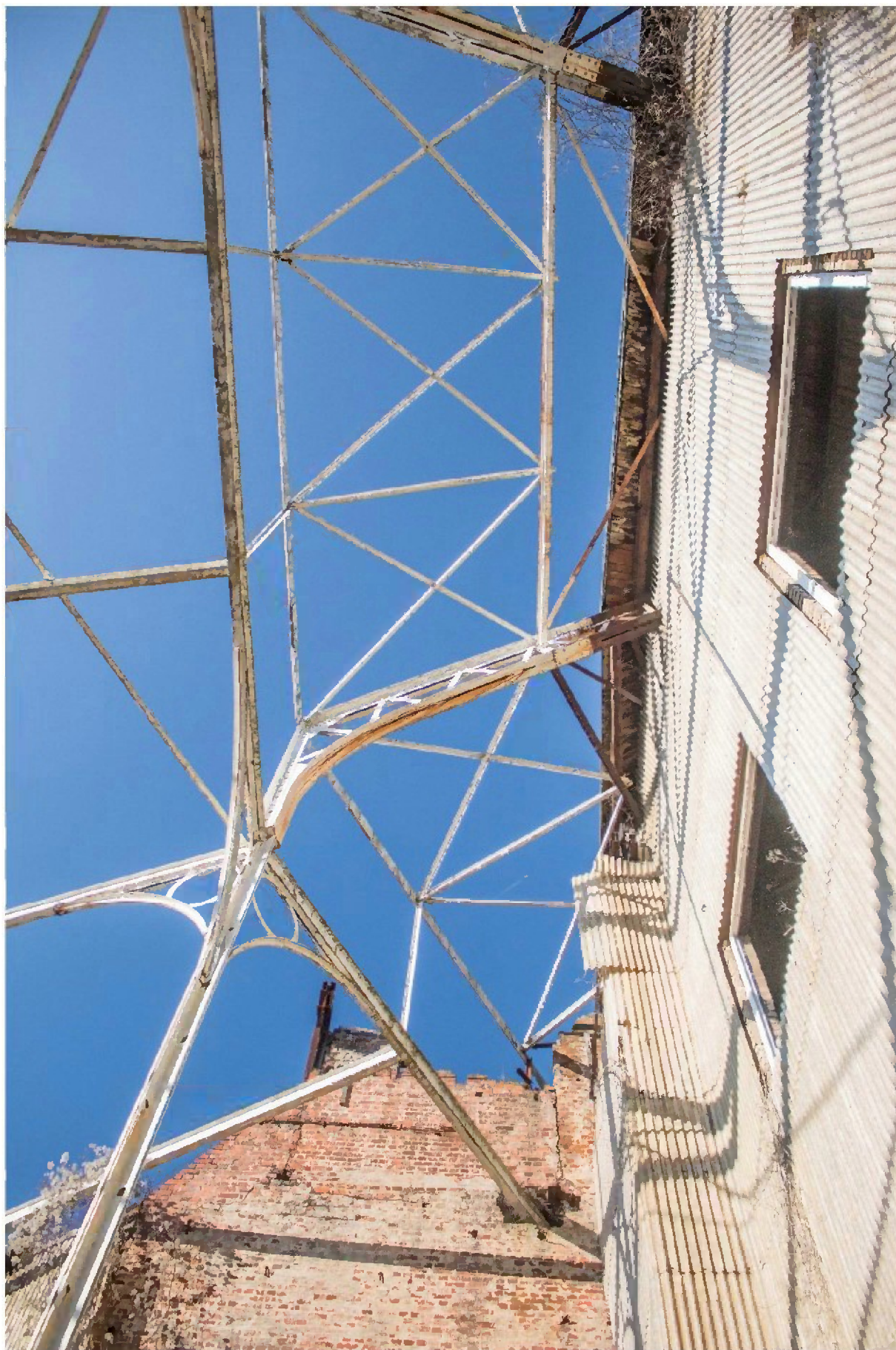
Blick auf die wiederhergestellte Rundbau-Konstruktion im Außenbereich
