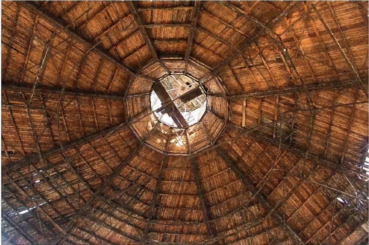
Blick auf die Dachkonstruktion der Rotunde mit Druckring und Laterne
