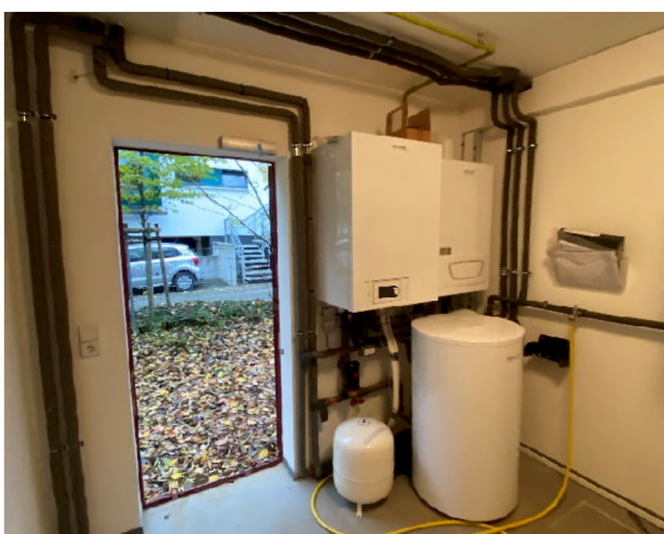
Abbildung 166: Heizkessel und Warmwasserspeicher
