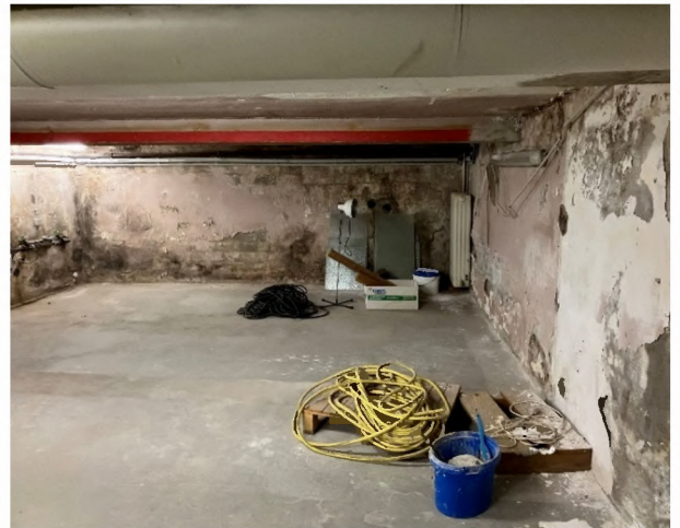
Abbildung 157: Exemplarische Feuchtigkeitsschäden KG
