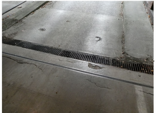
Abbildung 91: Abplatzungen an Ein- Ausfahrt
