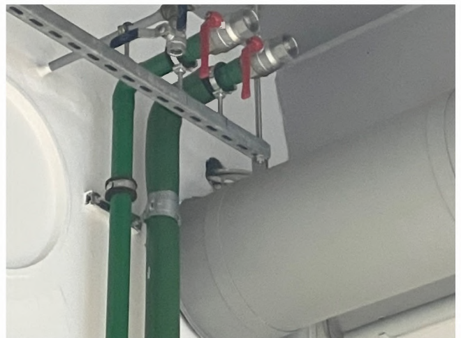
Abbildung 129: Exemplarische fehlende / ungenügende Brandschottung
