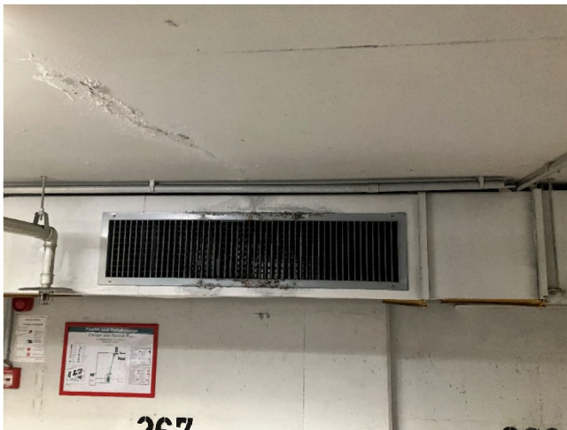
Abbildung 98: Garagenabluft / Gefahrenmelder
