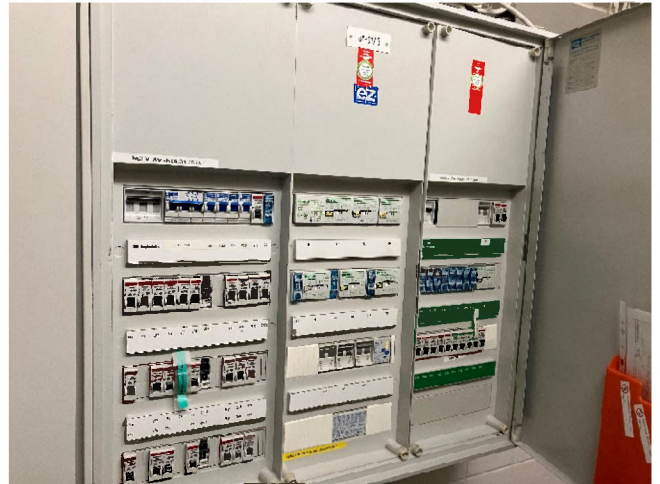
Abbildung 109: Elektrounterverteilung
