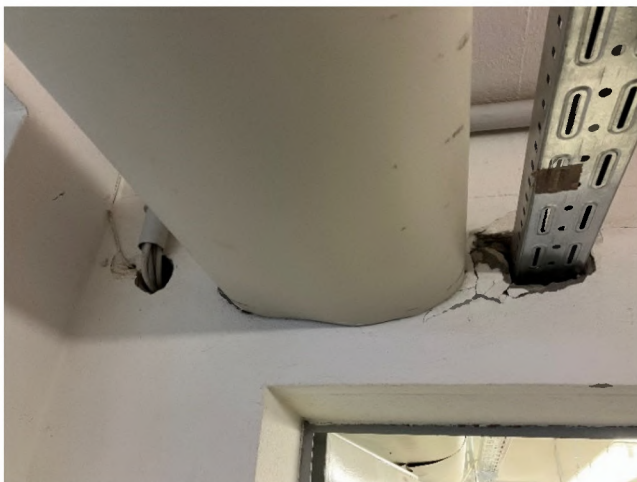
Abbildung 158: Exemplarische fehlende / ungenügende Brandschottung
