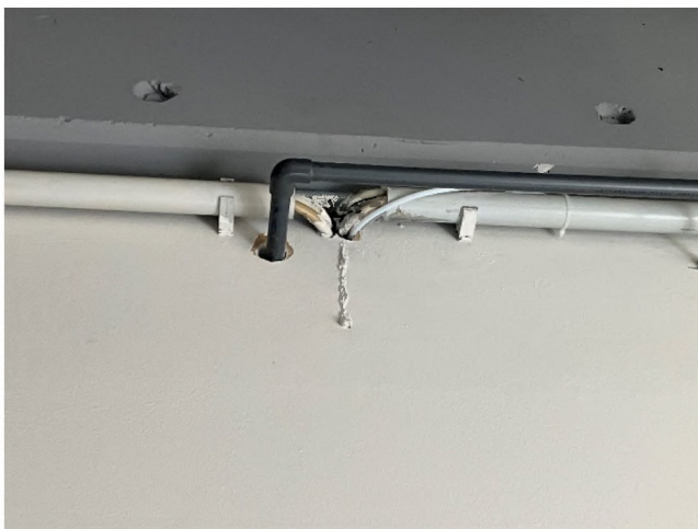
Abbildung 52: Fehlende bzw. ungenügende Brandschottungen
