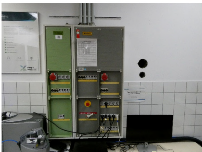
Abbildung 58: Elektro Unterverteilung
