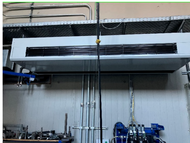
Abbildung 85: Umluftkühler
