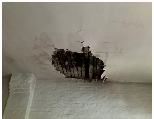
Abbildung 161: Morsche Dachkonstruktion
