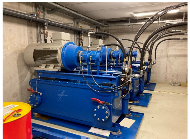
Abbildung 81: Kompressoren-Hydraulikanlage
