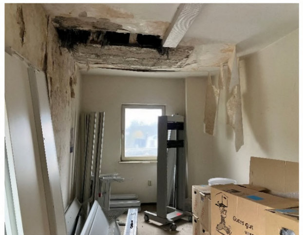
Abbildung 159: Schadhafte Dachaufbau
