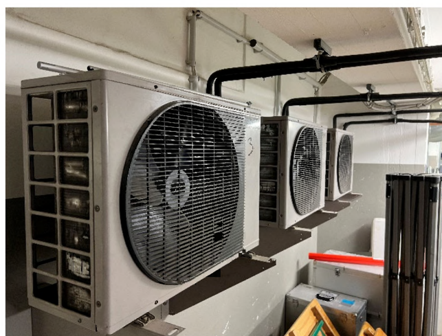
Abbildung 155: Spilt-Kälte Rückkühler
