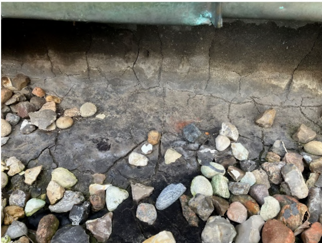
Abbildung 126: Poröse Flachdachabdichtung
