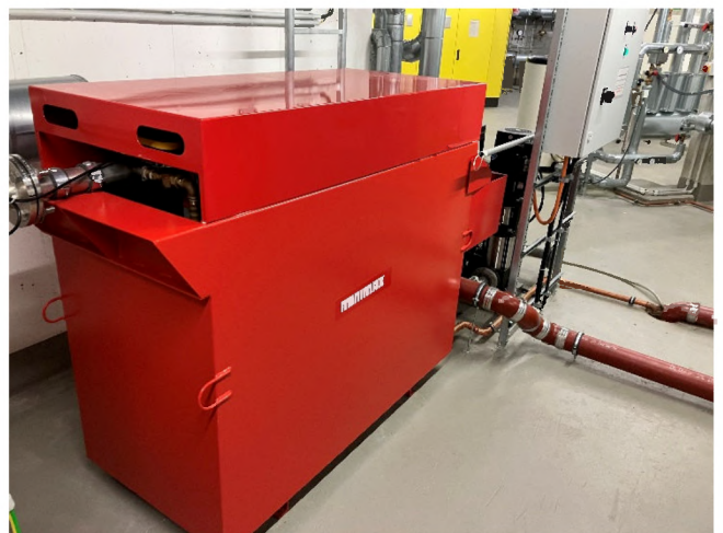
Abbildung 113: Trennstation Löschanlagen
