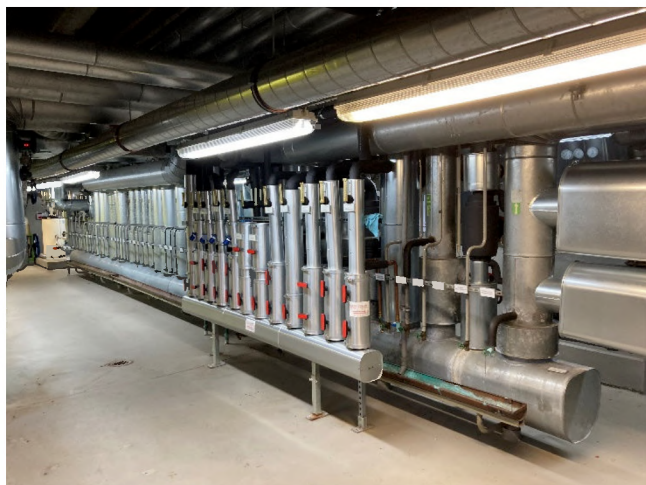
Abbildung 132: Heizungsverteiler
