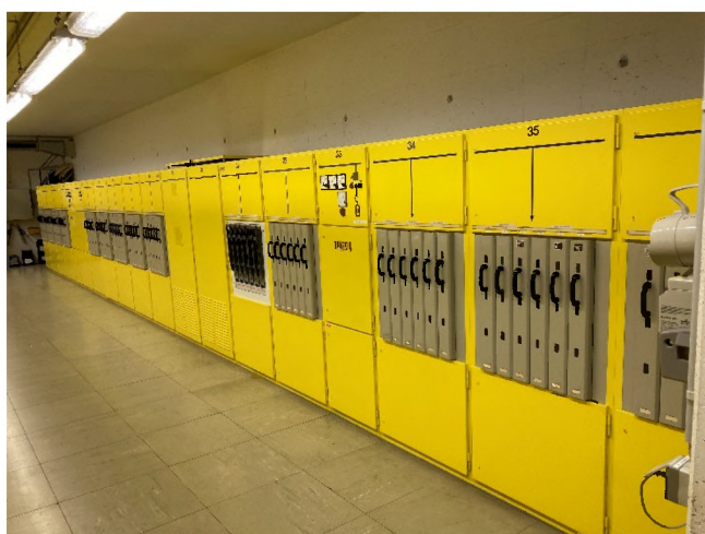
Abbildung 136: Mittel- und Niederspannungsanlage
