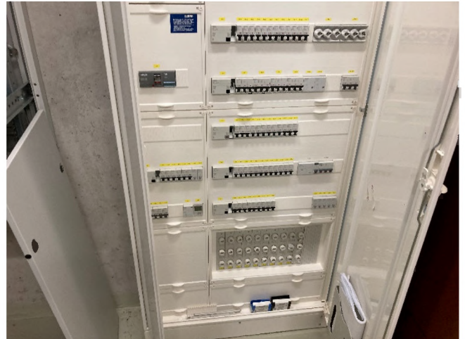
Abbildung 79: Elektro-Unterverteilung
