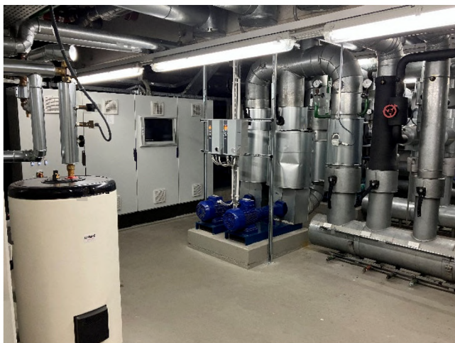
Abbildung 84: Heizungs-Unterstation
