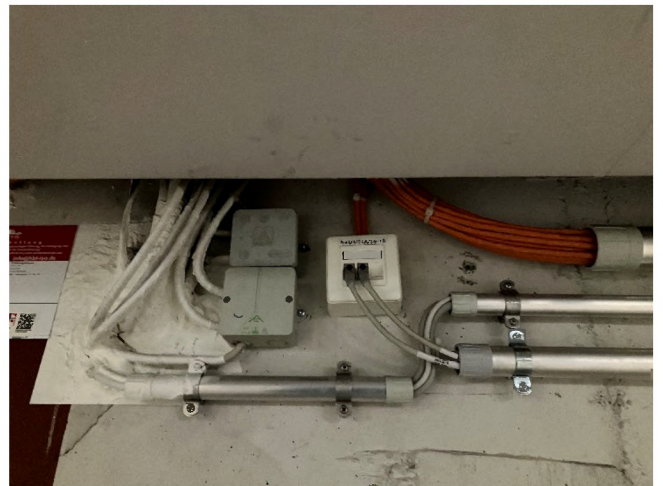
Abbildung 99: Verkabelungen / Schottungen
