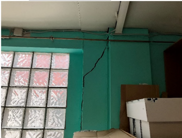
Abbildung 156: Riss Lagerraum EG
