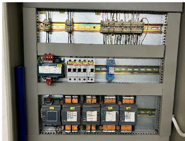
Abbildung 13: Pumpensteuerung
