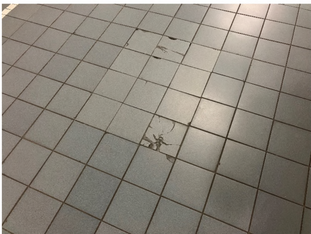
Abbildung 106: Exemplarische Fliesenschäden
