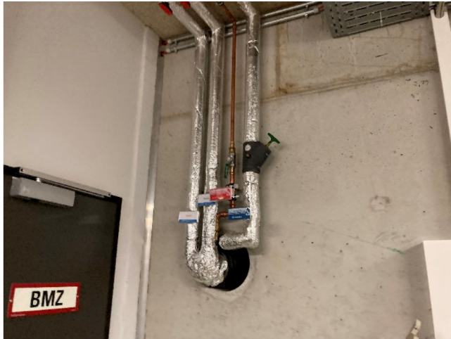
Abbildung 78: Medienversorgung (Wasser, Heizung, Druckluft)
