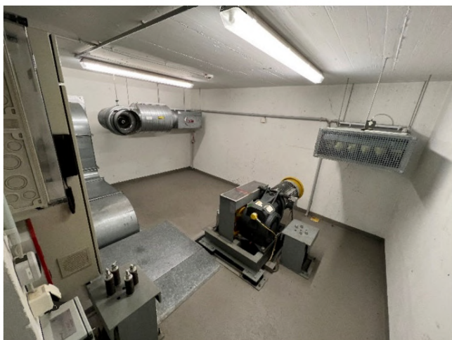
Abbildung 32: Aufzugsmaschinenraum
