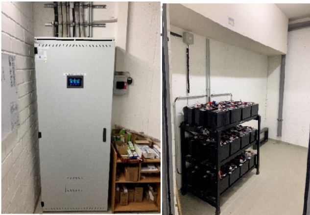
Abbildung 20: Sicherheitsbeleuchtung und zugehörige Bat.Anlage
