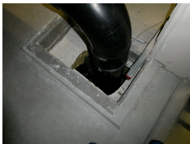
Abbildung 89: Offener Schacht / Brandschutz
