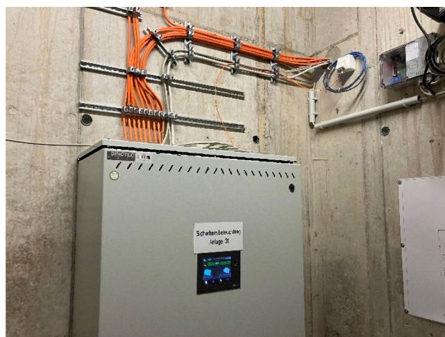
Abbildung 87: Sicherheitsbeleuchtungsanlage
