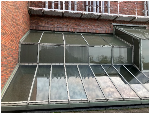
Abbildung 48: Schadhafte Pfosten-Riegel-Konstruktion
