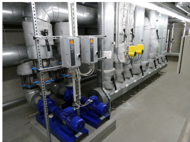
Abbildung 55: Heizungsverteiler
