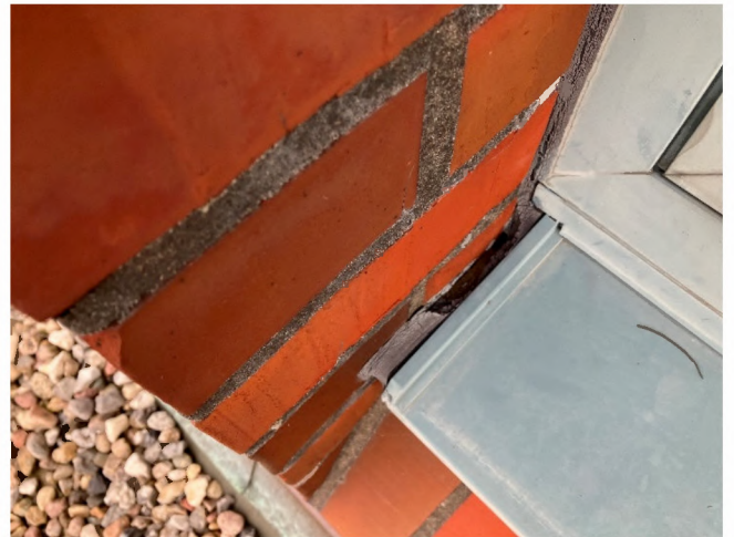
Abbildung 103: Exemplarische poröse Fensterabdichtung
