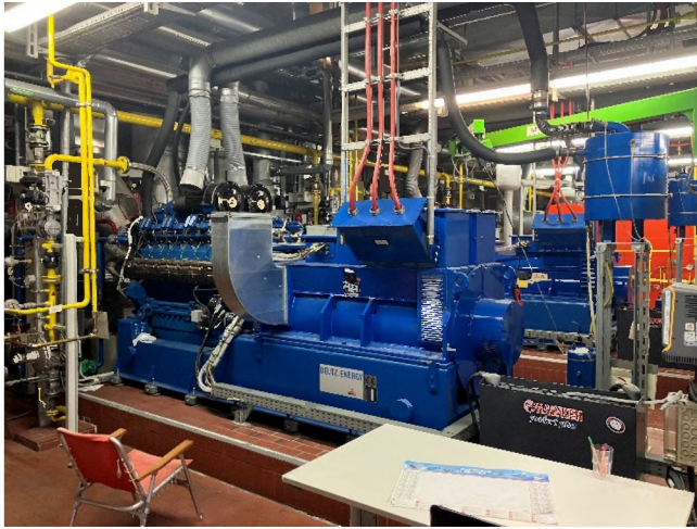
Abbildung 66: Blockheizkraftwerk
