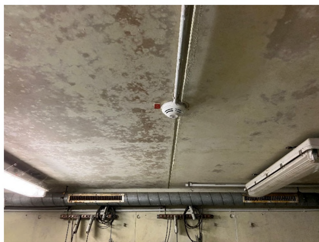
Abbildung 123: Abluftrohre und Rauchmelder
