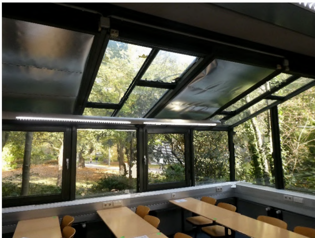
Abbildung 62: Innenliegender Sonnenschutz
