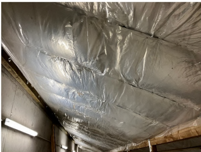
Abbildung 50: Schadhafte Dampfsperre
