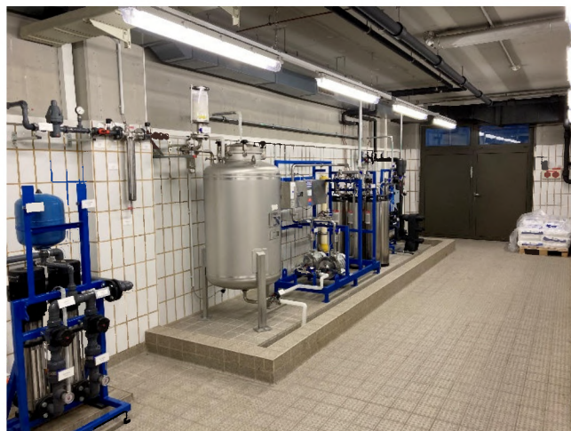
Abbildung 133: Wasseraufbereitung / VE-Wasser
