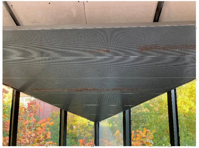
Abbildung 61: Schadhafte Deckenverkleidung
