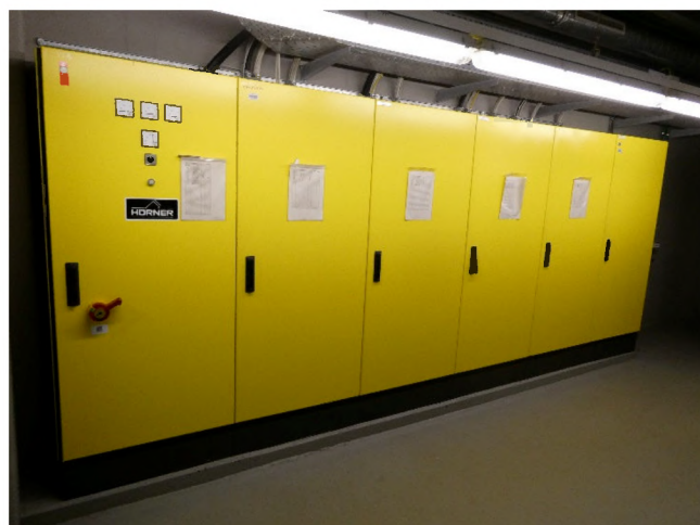
Abbildung 57: Steuerungsschränke Lüftung
