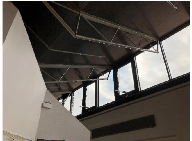
Abbildung 127: Undichte Glasfront
