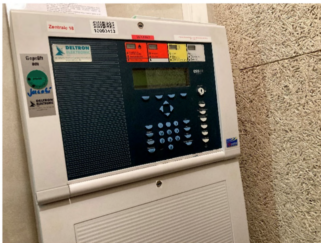
Abbildung 80: Brandmeldeanlage
