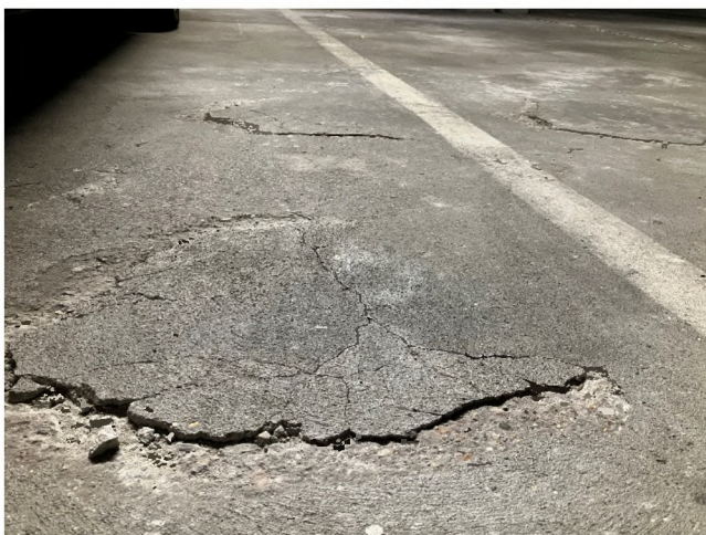
Abbildung 92: Abplatzungen Bodenbelag
