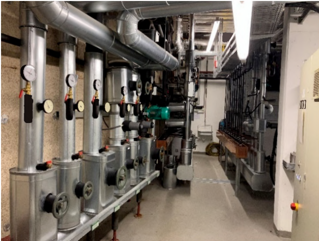
Abbildung 18: Heiz- und Kühlwasser-Verteiler
