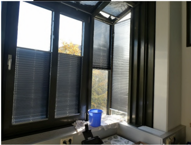
Abbildung 60: Undichte Schrägverglasung
