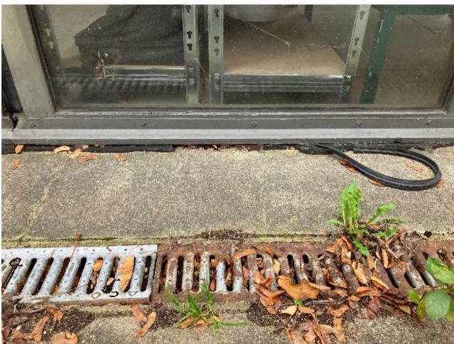
Abbildung 128: Exemplarische Gummiabdichtung Werkshallentore
