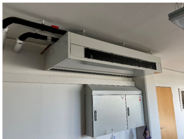
Abbildung 45: Umluftkälte und ELT-Unterverteilungen
