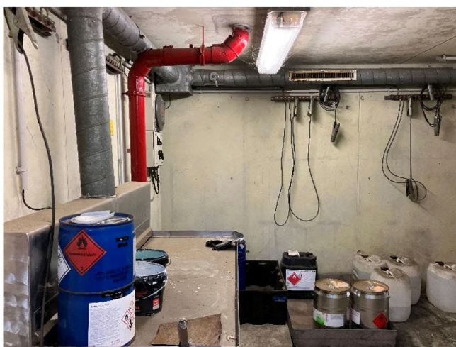
Abbildung 122: Abluft- und Abwasserleitungen
