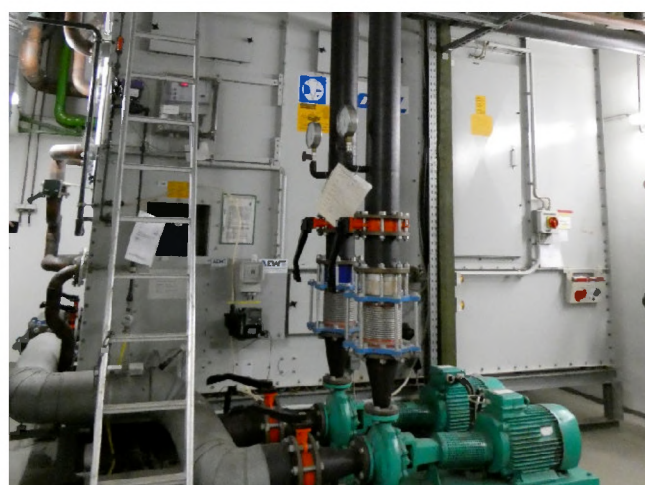
Abbildung 59: Rückkühler Kälteanlagen
