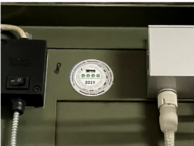
Abbildung 130: Überfällige Prüfung Feststellanlage
