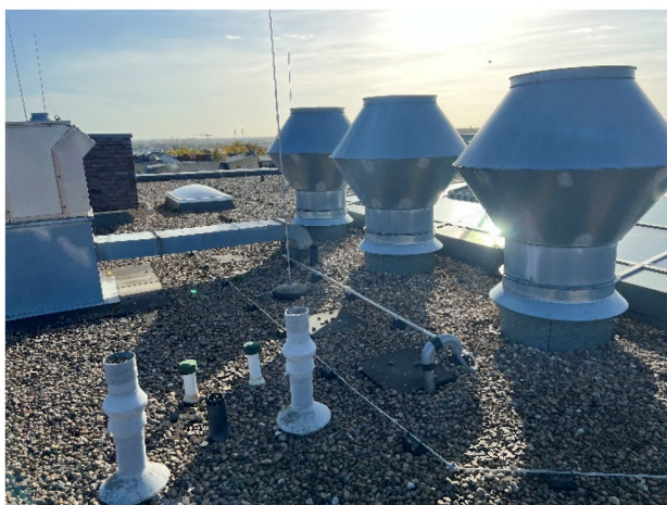
Abbildung 44: Lüftungshauben und Dachentlüfter
