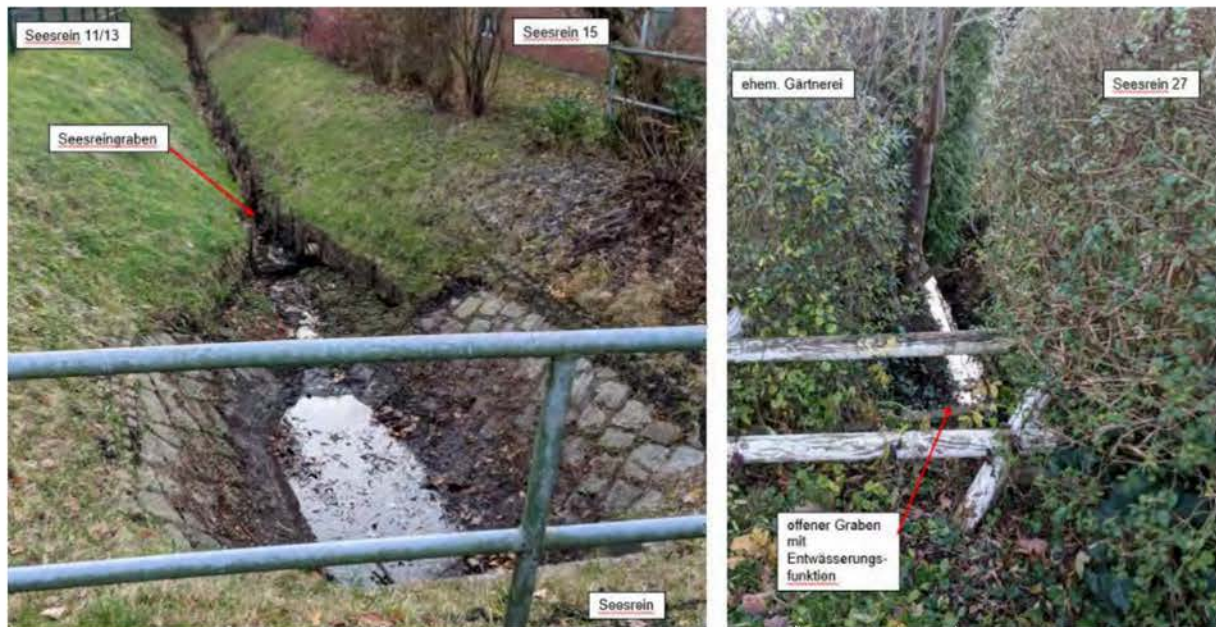
Abbildung 7: Seesreingraben und offener Graben mit Entwässerungsfunktion im Seesrein
