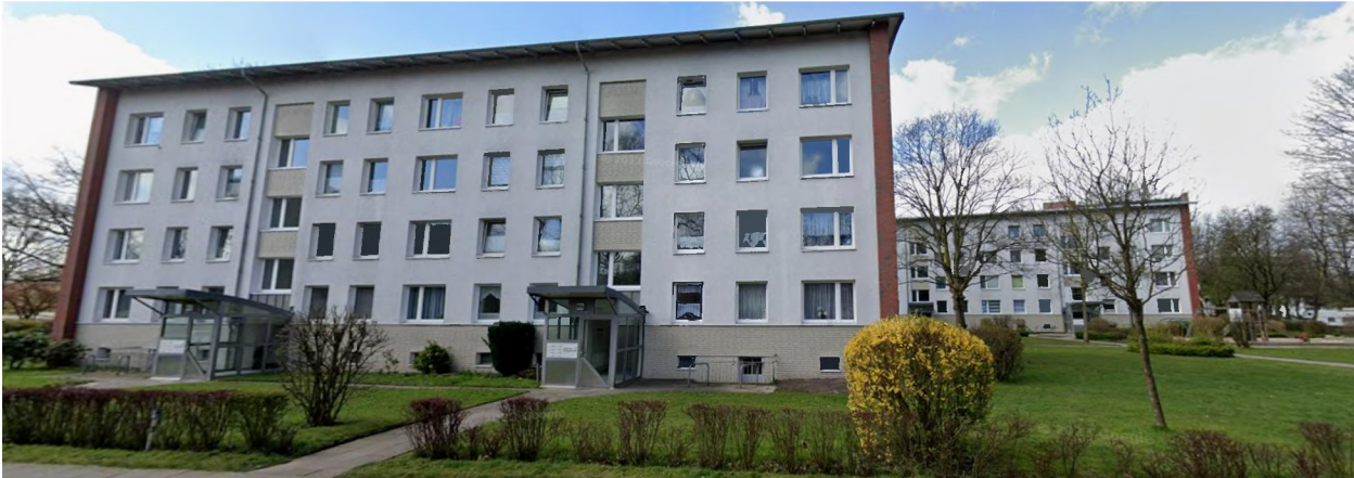
Abbildung 4-24: Zeilengebäude Krummer Kamp
