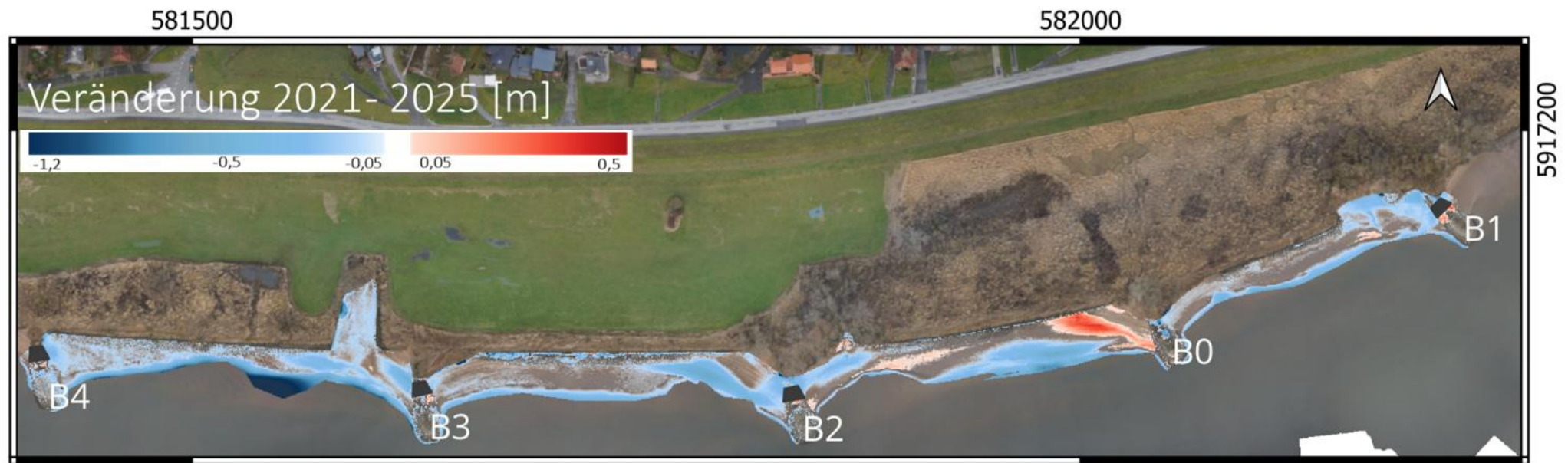
Abbildung 10: Übersicht über morphologische Veränderungen der Geländehöhe im vegetationslosen Watt an der Elbe vor West- Krauel. Datengrundlage ist das Digitale Geländemodell aus dem Bildflug (ALS) im Januar 2021 und die Ergebnisse aus dem TLS – Monitoring.
