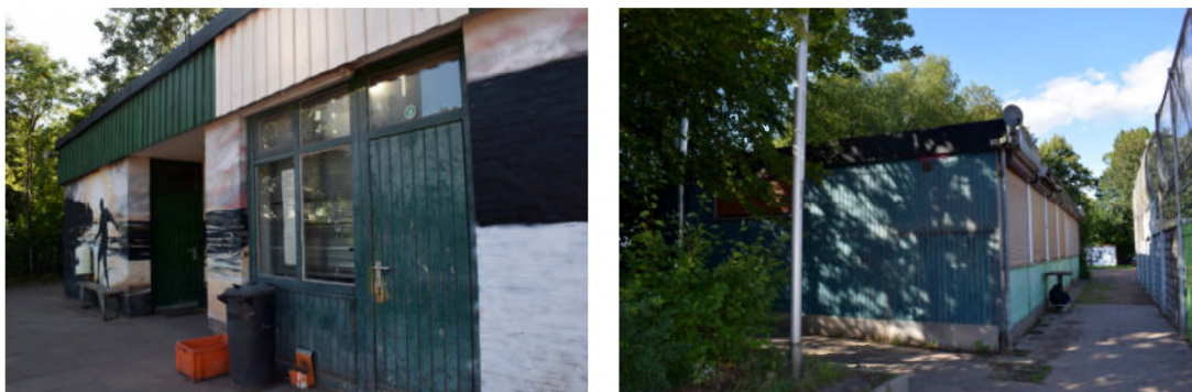
Abb. XII-XIII: Teilfläche FLA Gebäude B1a; Teilfläche FLA Gebäude B1b und B1c
