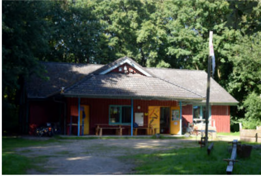
Abb. XX: Teilfläche FLB Gebäude B4
