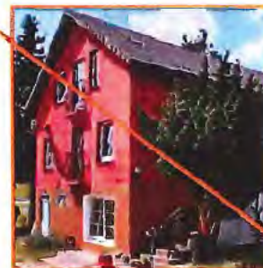
Abb. 16: Rot verputzte Fassade
