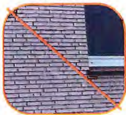
Abb. 41: sehr glattes Mauerwerk
