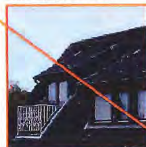
Abb. 9: Loggia in Dachfläche
