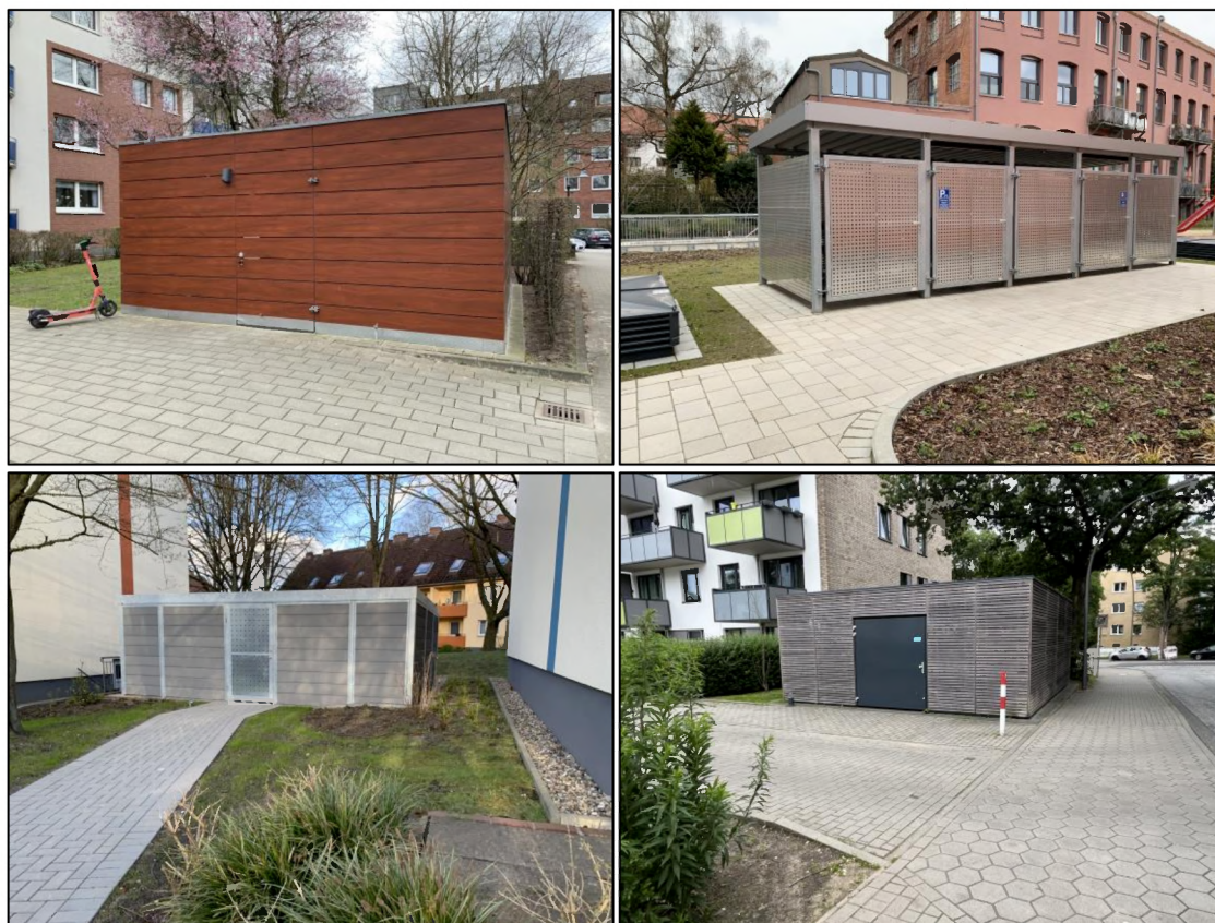
Abbildung 22: Beispiele für ebenerdige Fahrradabstellanlagen (eigene Aufnahmen)
