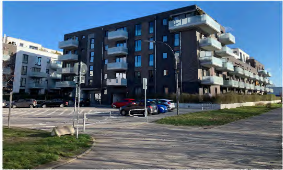
Abb. 6: Glasbläserhöfe 8 (Nordwest- und Südwestfassade, Stand: 24.01.2021)
