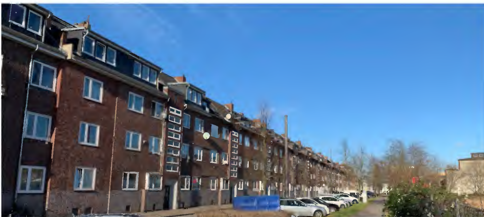
Abb. 5: Weidenbaumsweg 136-110 (Blick Richtung Norden, Stand: 24.01.2021)
