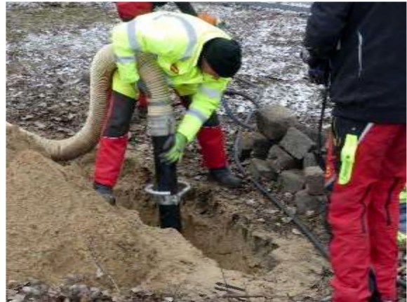
Saugschlauch im Graben (Beispiel)
