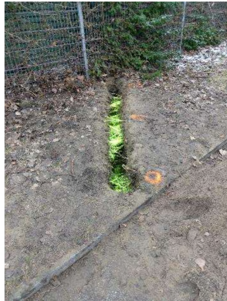
Graben mit markiertem Wurzelwerk
