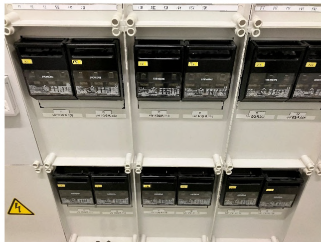
Abbildung 16: Niederspannungshauptverteilung
