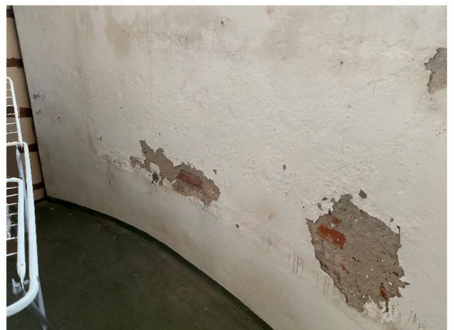
Abbildung 14: Feuchtigkeitsschäden im Keller
