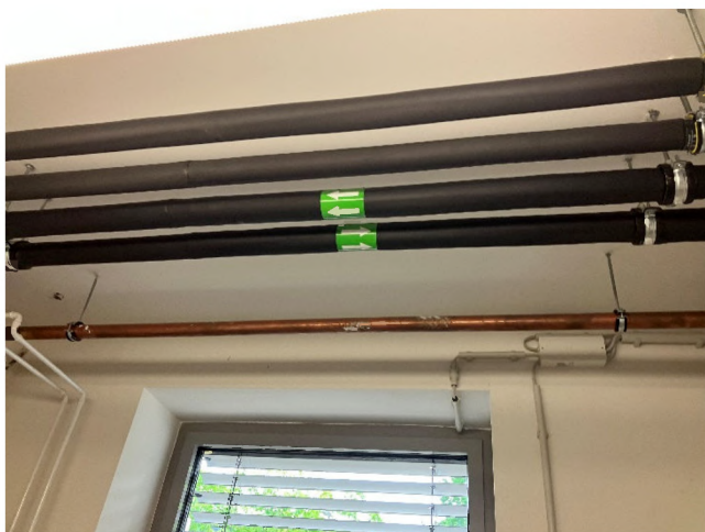
Abbildung 17: Versorgungsleitungen Heizung/Trinkwasser
