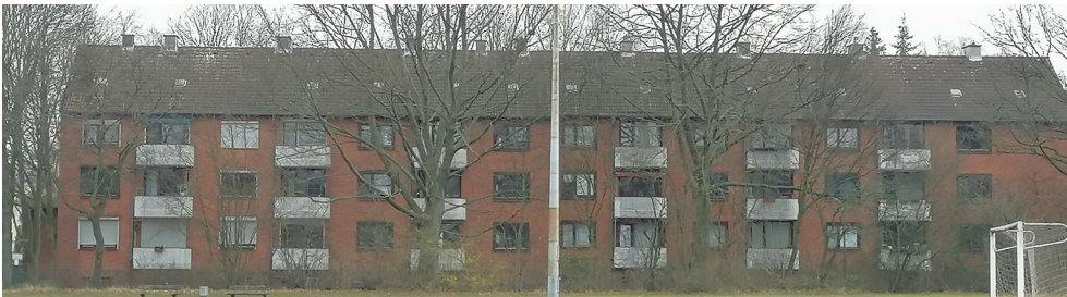
Abb. 2: Wohngebäude Am Neumarkt 21 a-d (Stand: 10.03.2021)
