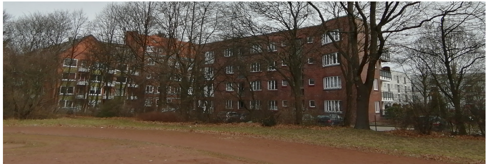
Abb. 4: Wohngebäude Fenglerstraße (Blickrichtung nach Nordosten, Stand: 10.03.2021)
