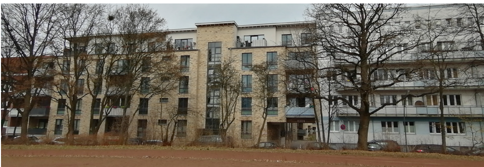
Abb. 3: Wohngebäude Fenglerstraße (Südseite, Stand: 10.03.2021)
