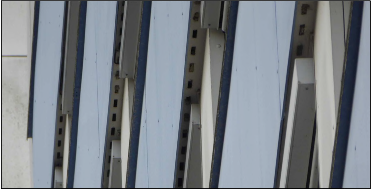
Abbildung 9: Fassadenverkleidung Gebäude Nr. 15/15a; Ansicht von unten
