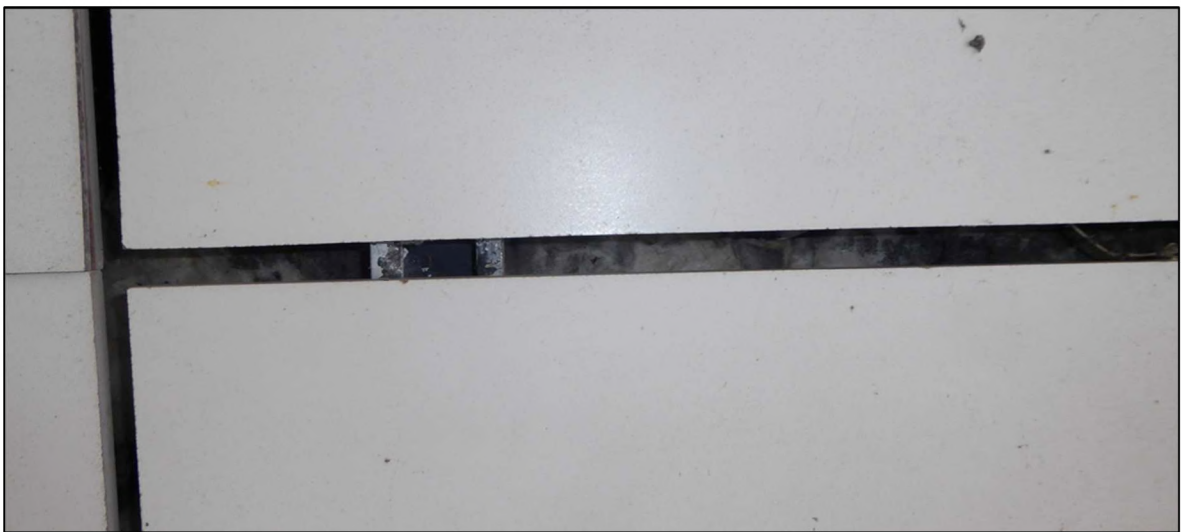
Abbildung 10: Fassadenverkleidung Gebäude Nr. 15
