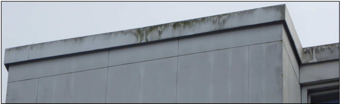
Abbildung 7: Dachkante Gebäude Nr. 15
