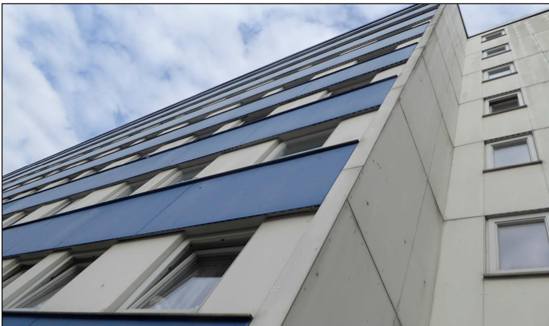
Abbildung 8: Fassade Haus Nr. 15a
