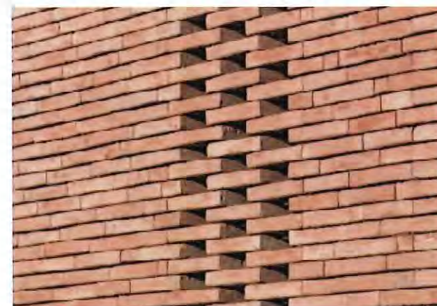
Perforierungen des Mauerwerks im Bereich der Fenster (Bad, Technikraum)
