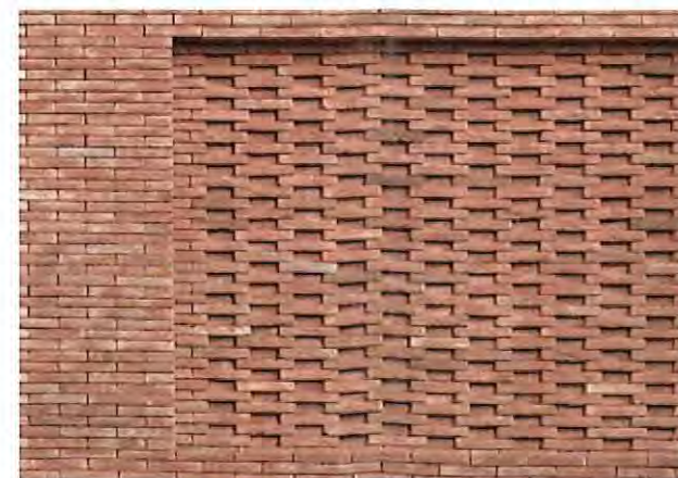
Mauerwerk mit Vertiefungen im flämischen Verband
