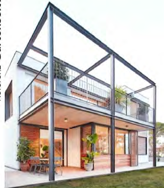
verzinkte Stahlkonstruktion als Tragkonstruktion
