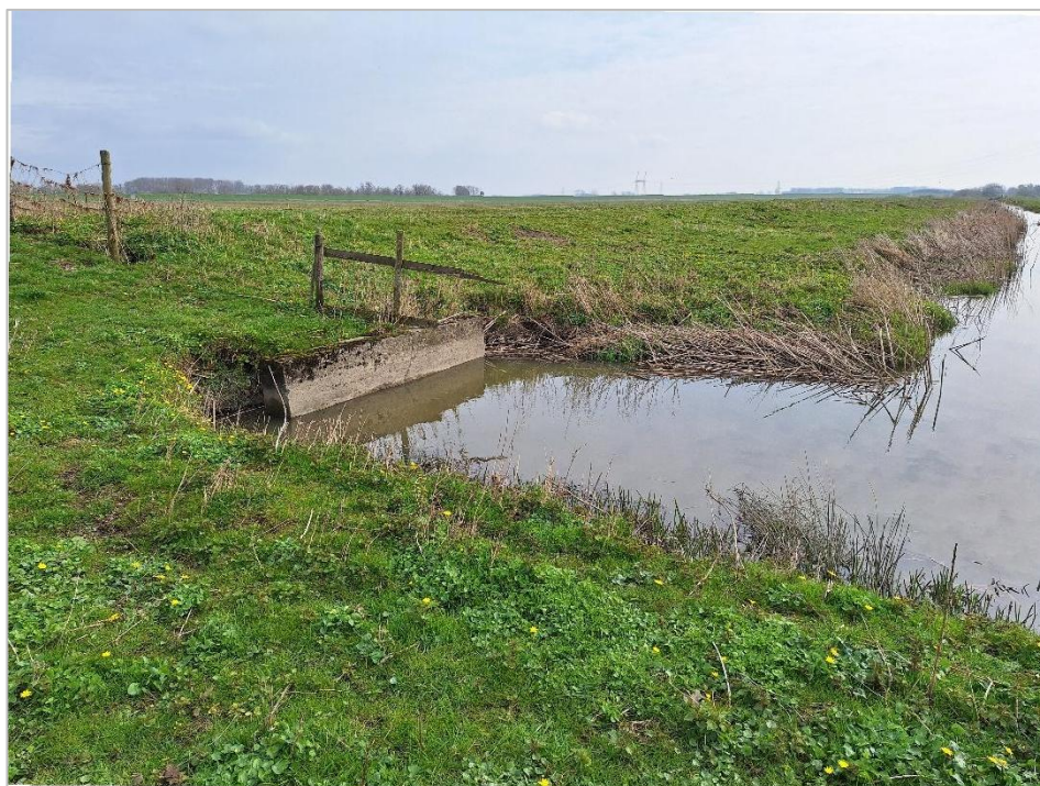
Abb. 2-5: Durchlassbauwerk zwischen Bereich 3 und Bereich 1
