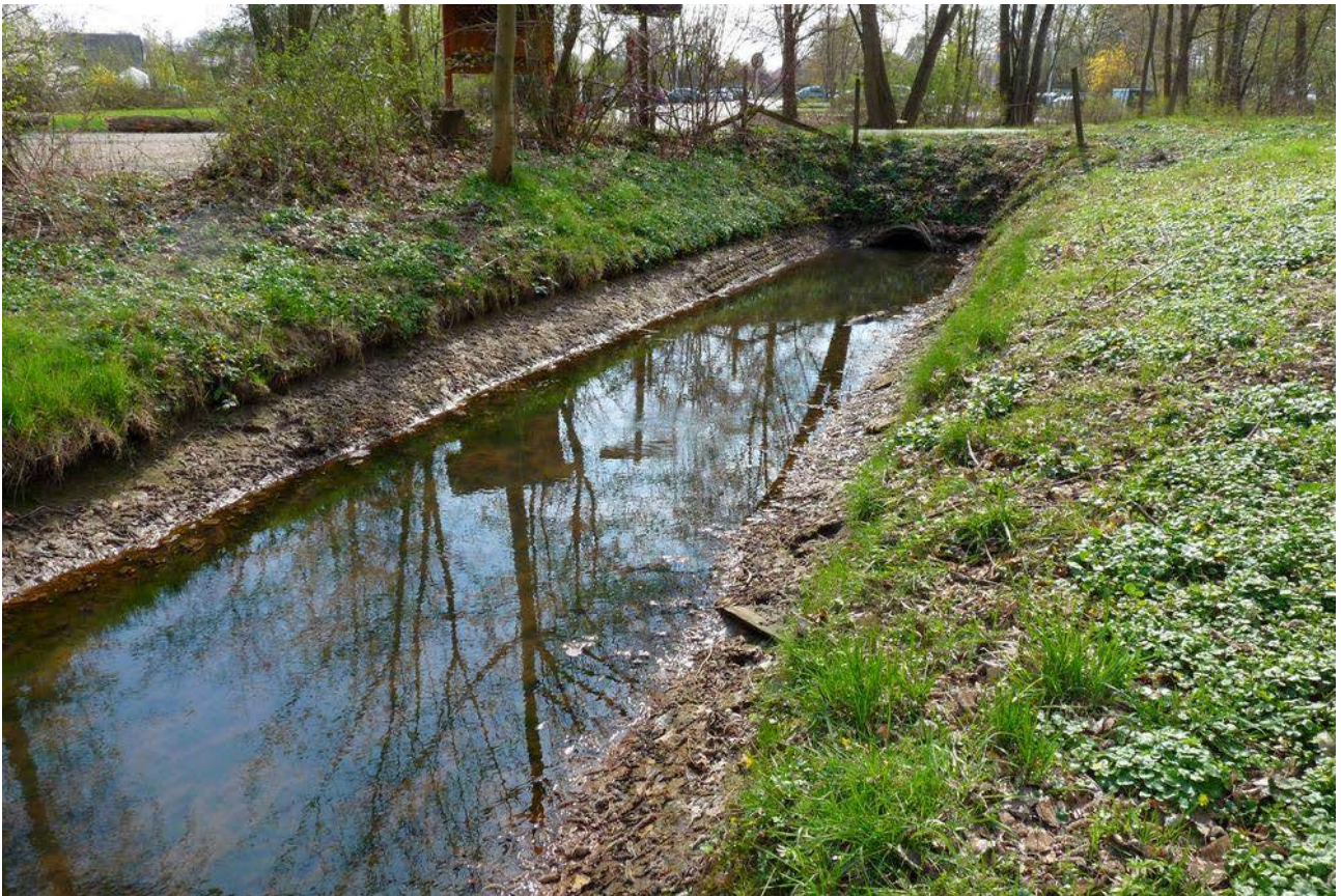
Abbildung 13: Tatenberger Hauptgraben - an den Ufern ist die deutliche Absenkung des Wasserstandes erkennbar, die Sohle ist intensiv geräumt, Wasserpflanzen fehlen, die Böschungen sind strukturarm
