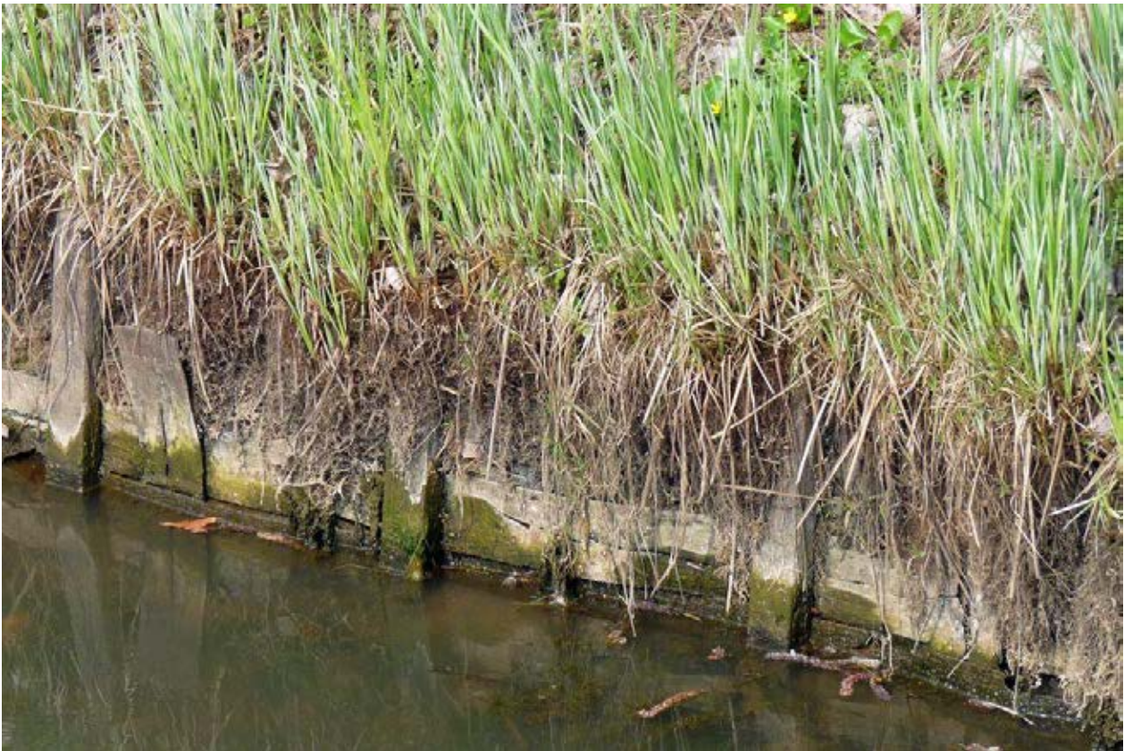
Abbildung 15: Wasserstandsschwankungen, niedrige Wasserstände und intensive Unterhaltung machen Uferbefestigungen notwendig, eine erhebliche ökologische Entwertung
