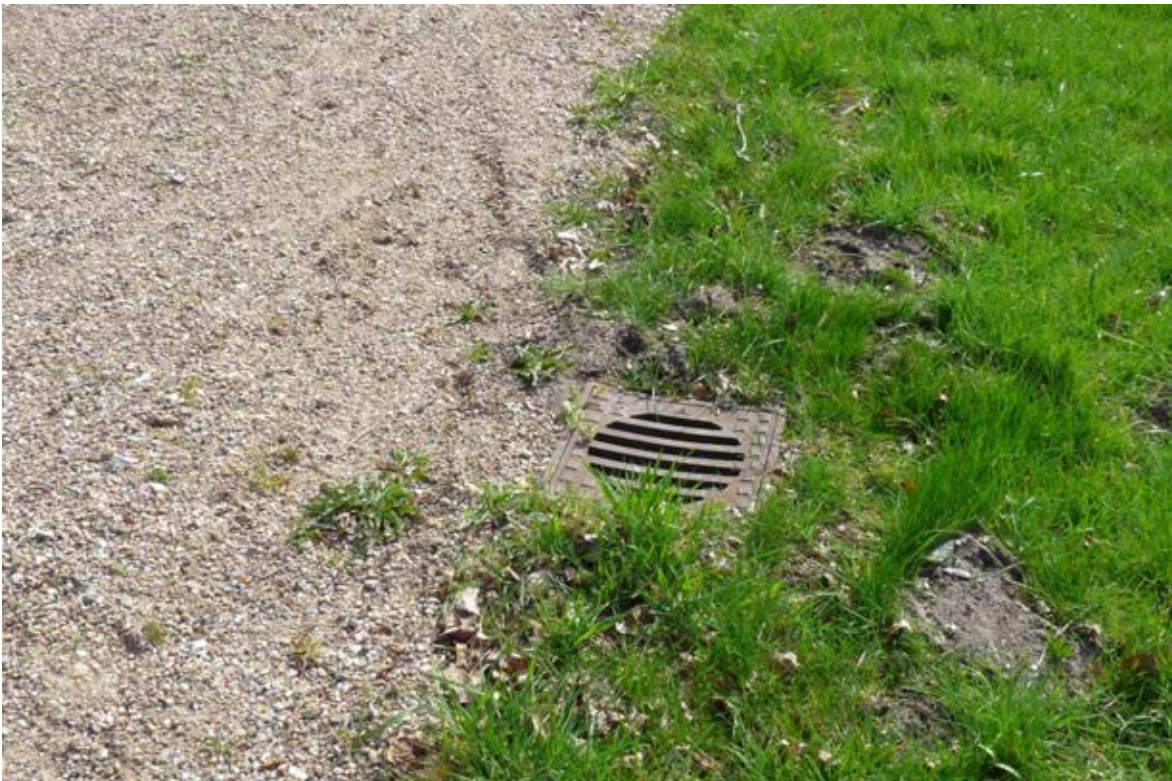
Abbildung 18: Einige Siele an den Wegen haben kaum eine entwässernde Funktion (Oberflächenwasser versickert oder läuft hier nach rechts die Böschung zum Graben hinab), sind aber für Amphibien eine gefährliche Falle.
