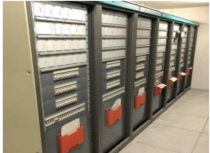
Foto 3-2 Dimmer Bühnenbeleuchtung sind kurzfristig zu erneuern. Sicherheitsgefahr
