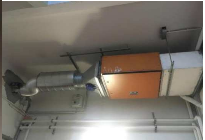
Foto 9-2 Dezentrale Lüftung im Treppenhaus - Erneuerung geplant
