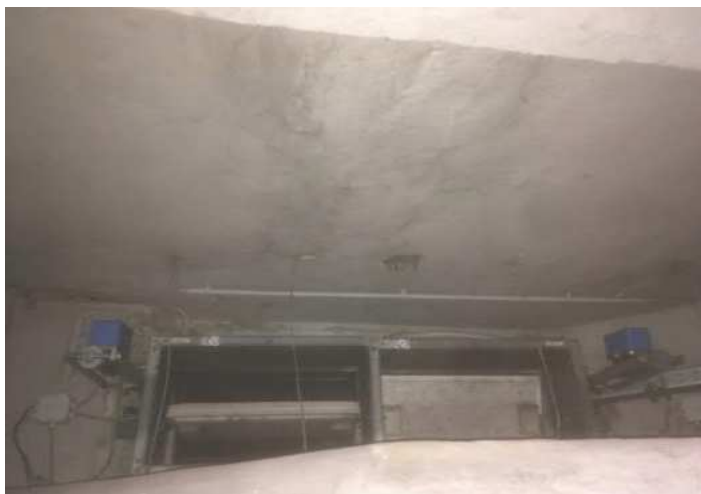
Foto 9-5 Brandschutzklappen (Übersicht)
