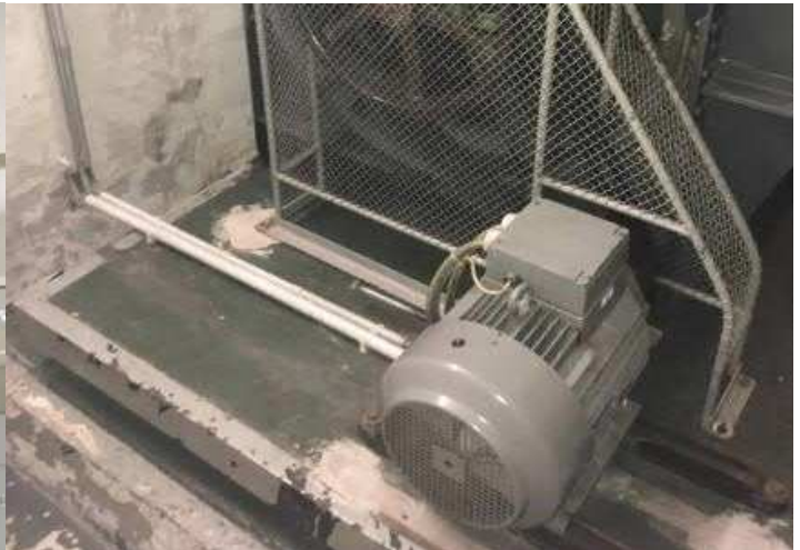
Foto 10-2 Lüftungsgerät - veraltet
