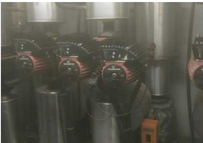
Foto 11-5 Umwelpumpen - Erneuerung geplant
