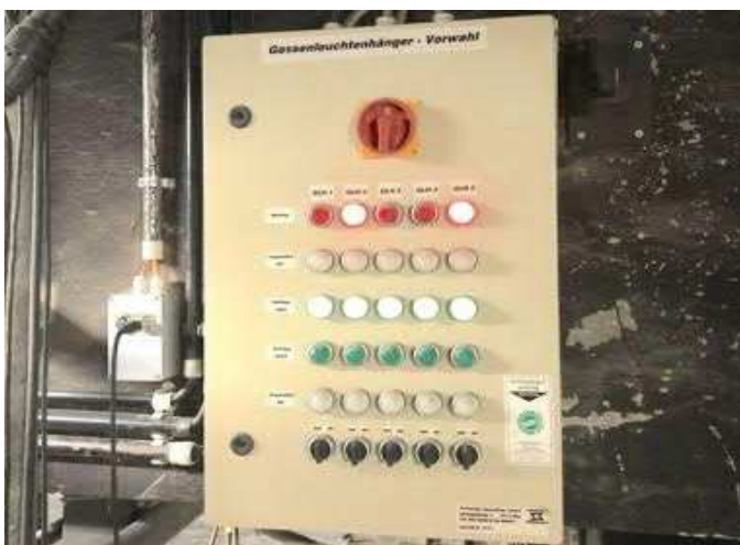
Foto 3-5 Steuerpult Gassenleuchtenhänger sind kurzfristig zu erneuern
