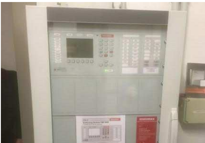
Foto 8-3 Sprinkler Steuerung (Übersicht)
