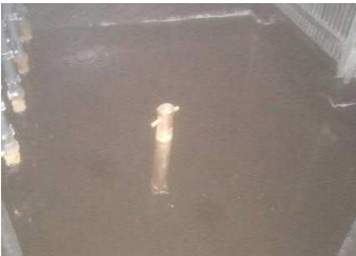
Foto 10-3 Stehendes Wasser in der Luftwäscherkammer
