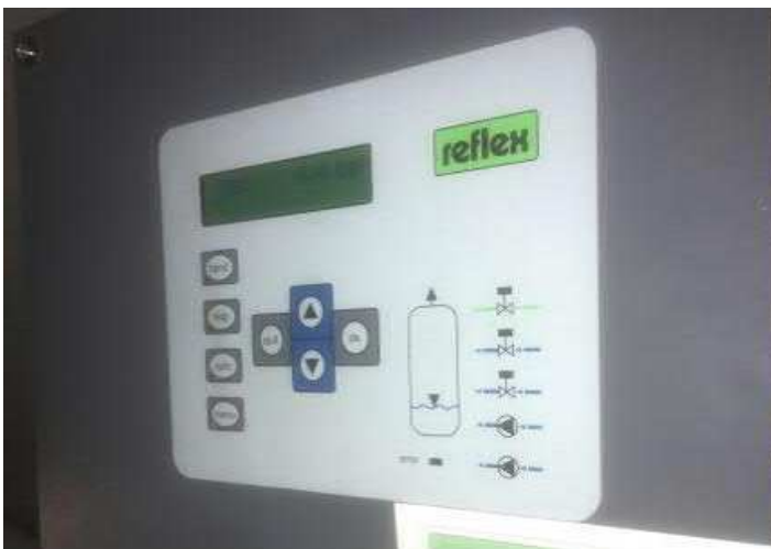
Foto 11-3 Steuerung Ausdehnungsgefäße - Erneuerung geplant
