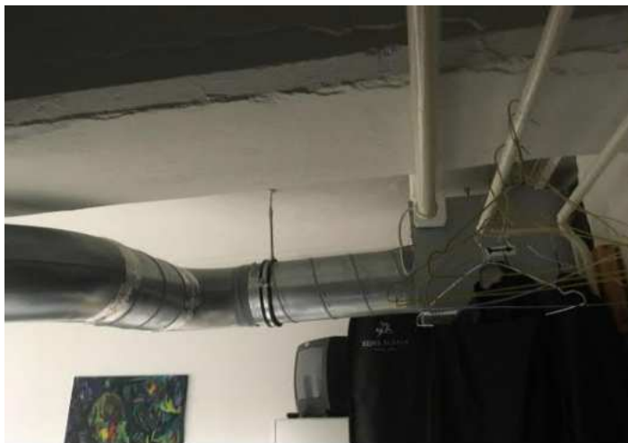
Foto 9-3 Dezentrale Belüftung Sanitärbereich - Erneuerung geplant
