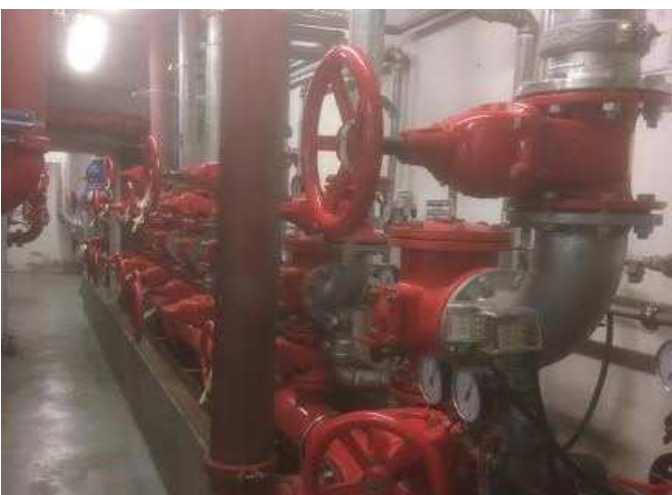
Foto 8-5 Sprinklerzentrale (Übersicht)
