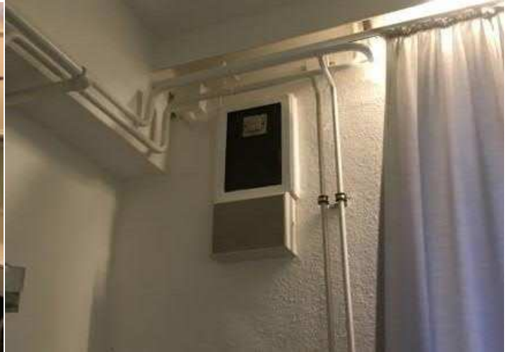
Foto 12-2 Heizungsinstallation Aufputz - Erneuerung geplant
