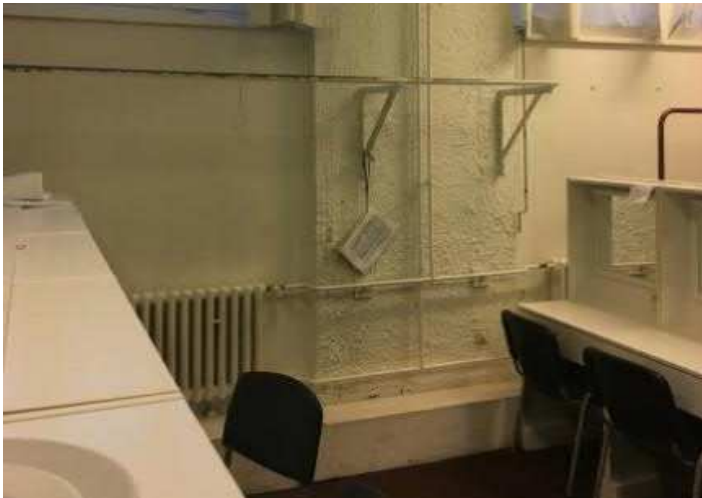
Foto 12-1 Heizkörper Anbindungen - veraltet
