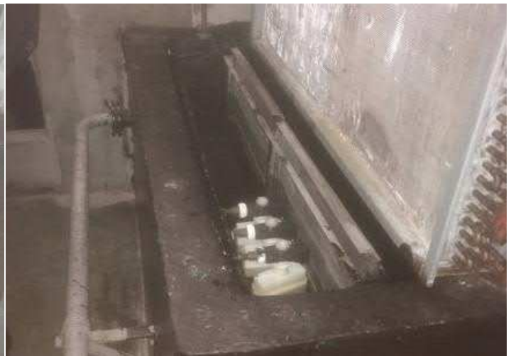
Foto 10-4 Füllereinheit Wäscherkammer
