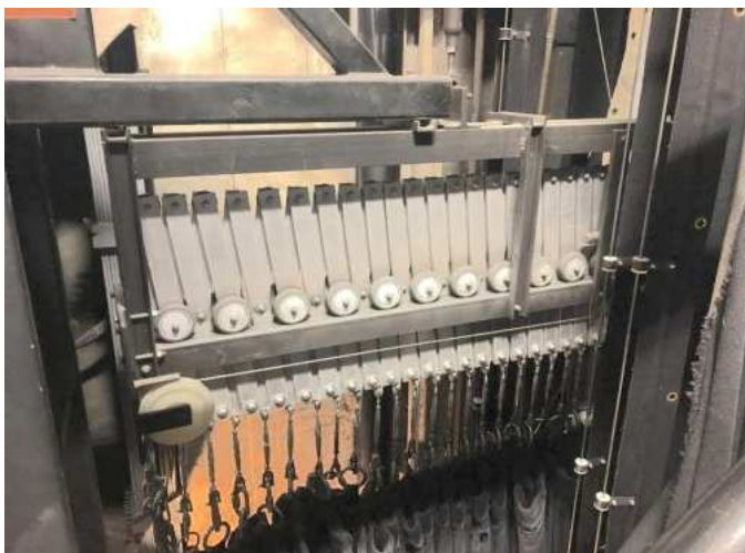
Foto 3-3 Hauptvorhangschiene mit Scherenzug ist mittelfristig zu erneuern
