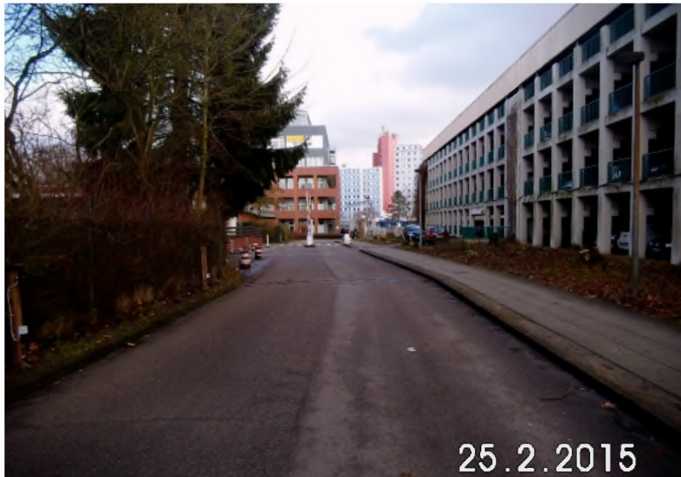
Bild 2: Verkehrsfläche Bereich Planstraße A (Westseite), Blickrichtung Osten
