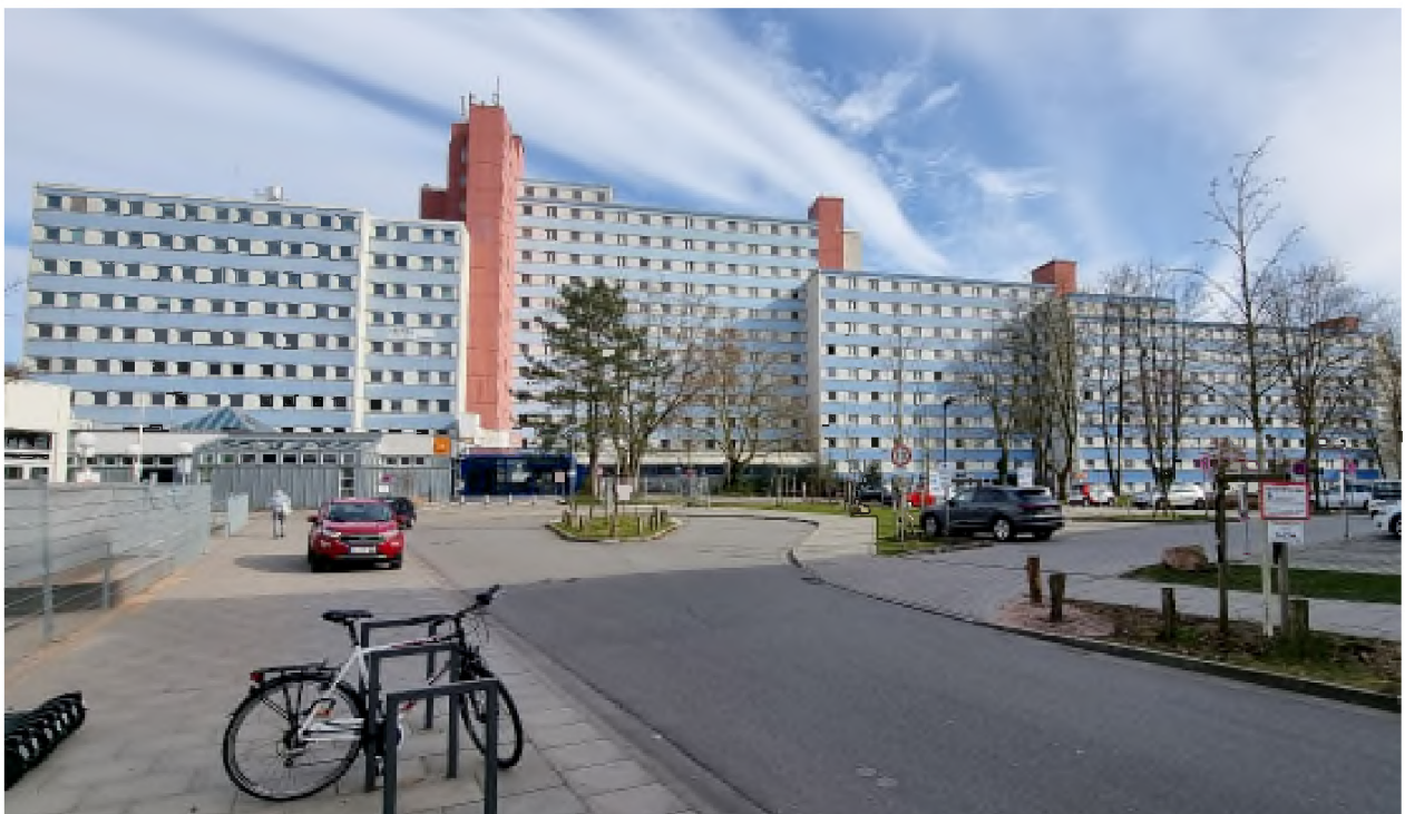
Foto 3: Westansicht ehemaliges Gebäude Berufsförderungswerks
