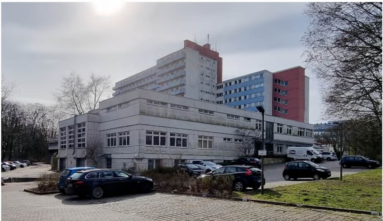
Foto 4: Nordostansicht ehemaliges Gebäude Berufsförderungswerks
