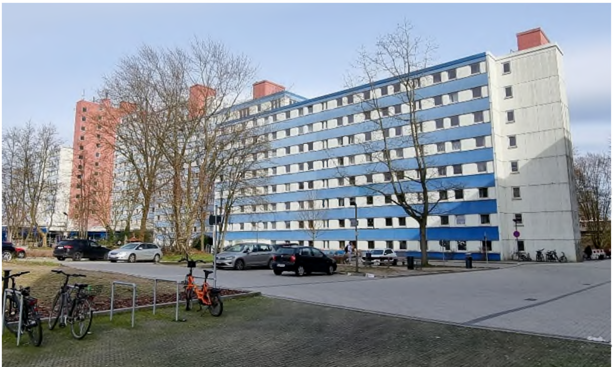
Foto 6: Südwestansicht ehemaliges Gebäude Berufsförderungswerks
