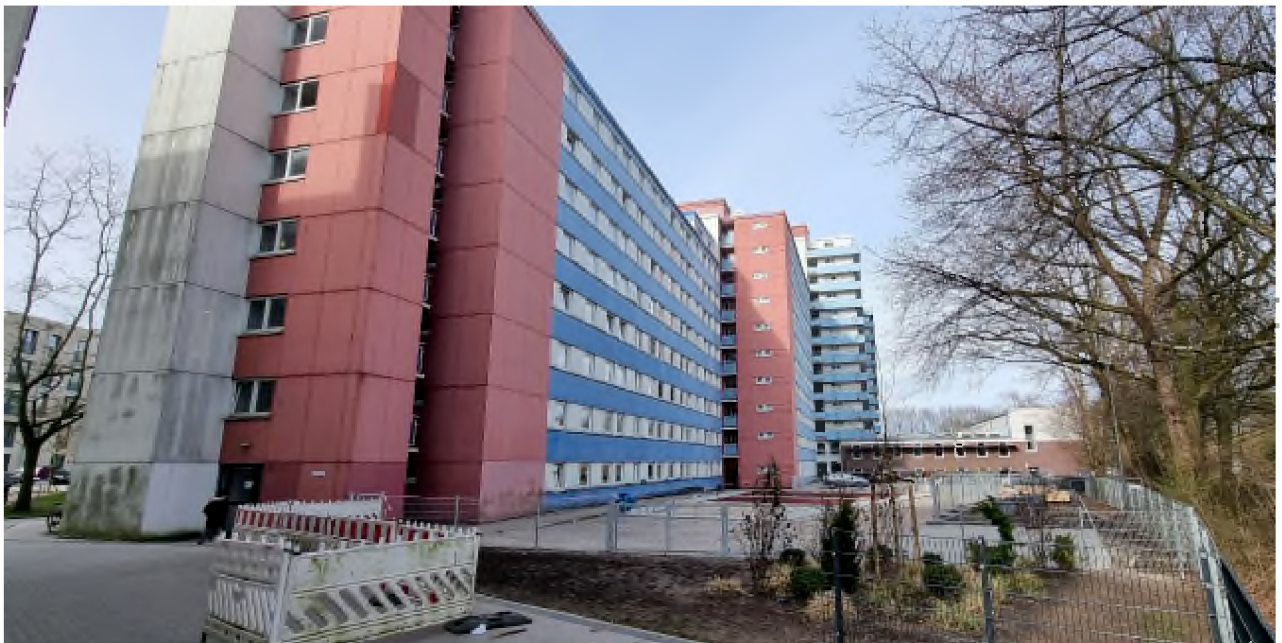
Foto 5: Südostansicht ehemaliges Gebäude Berufsförderungswerks
