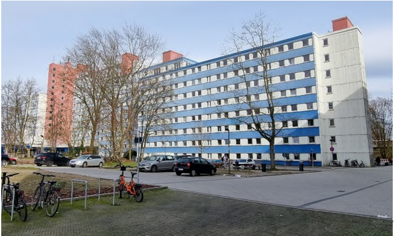
Foto 6: Südwestansicht ehemaliges Gebäude Berufsförderungswerks
