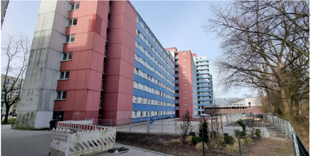
Foto 5: Südostansicht ehemaliges Gebäude Berufsförderungswerks
