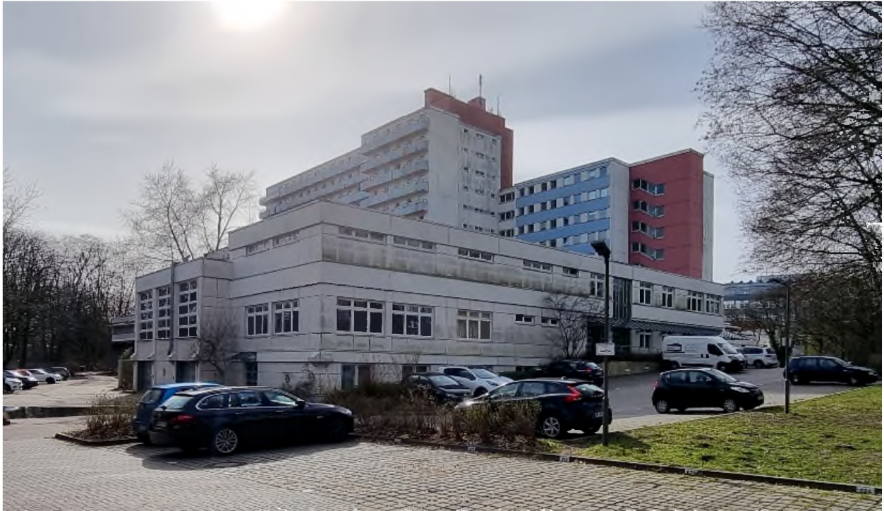
Foto 4: Nordostansicht ehemaliges Gebäude Berufsförderungswerks
