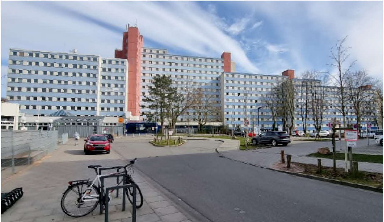
Foto 3: Westansicht ehemaliges Gebäude Berufsförderungswerks
