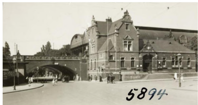
Abbildung 5: ehemaliger Bahnhof Holstenstraße
