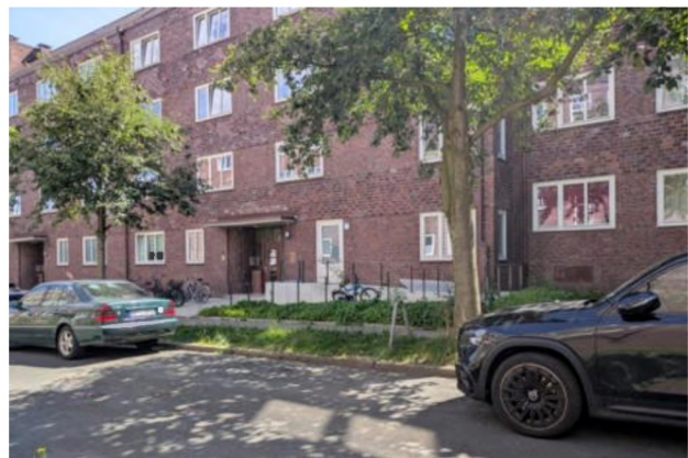
Abbildung 26: Schaffung barrierefreier Zugänge im Bestand, Anisstraße
