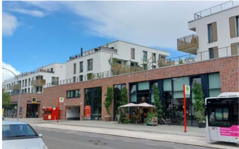
Aufstockung EKZ Meiendorf Quelle: Bezirksamt Wandsbek
