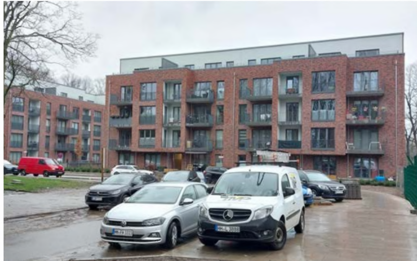
August-Krogmann-Straße 100, SAGA Typenbau Quelle: Bezirksamt Wandsbek
