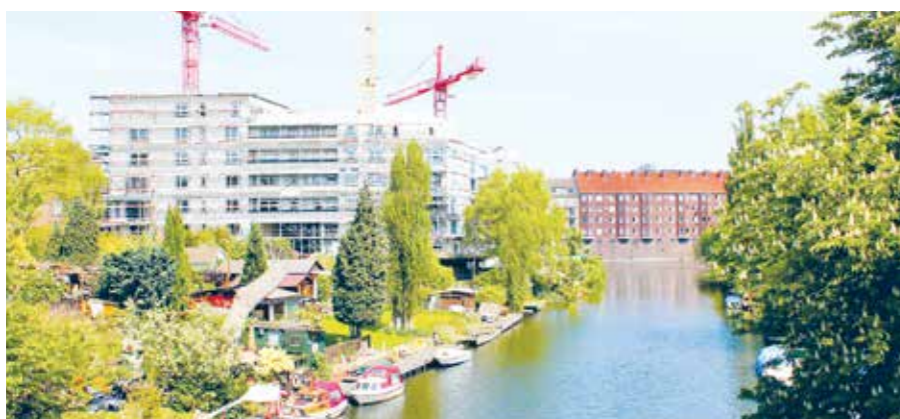
Wohnen am Wasser – die „Hansaterrassen“ im Bau in Hamm-Süd
