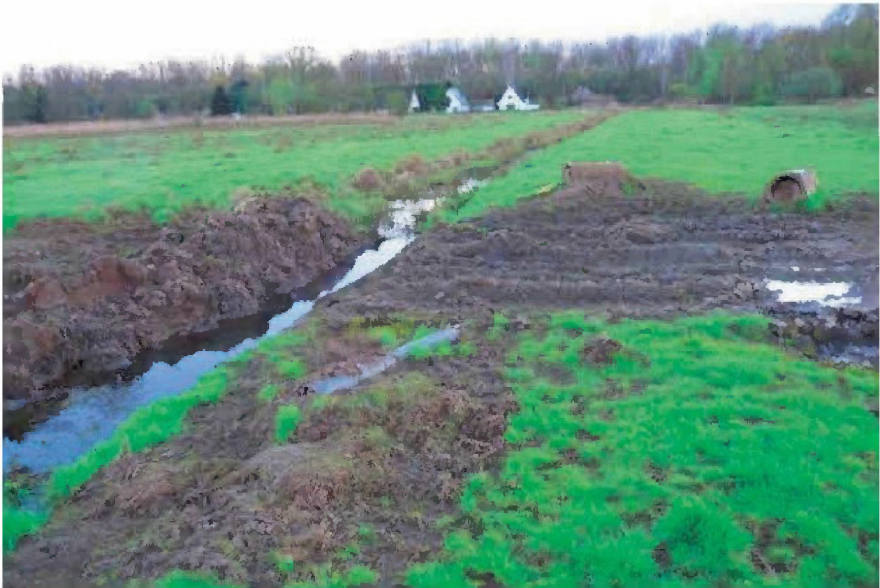
Abbildung 37: Schon bald sind aber die Abflusshindernisse beseitigt worden.
