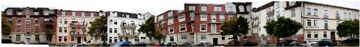
Abbildung 5: Ansicht Straßenzug Soltaustraße 17-29
