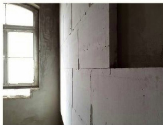
Abbildung 14: Sanierung der Backsteinfassade, Kalziumsilikat-Innendämmung
