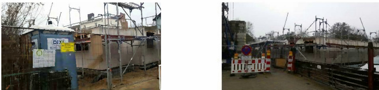
Abbildung 45: Neubau Neuer Weg 50
