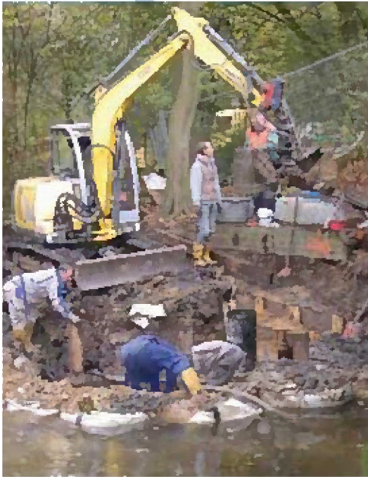
Für den neuen Messcontainer musste der Außenbereich der Station erweitert und gegen Hochwasser gesichert werden.
