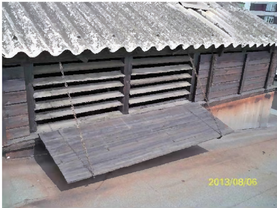
Dach-Aufbauten, Halle H3
