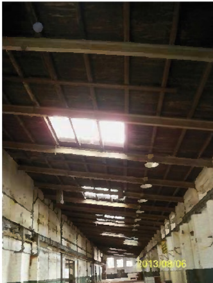
Dach-Unterkonstruktion Halle H4
