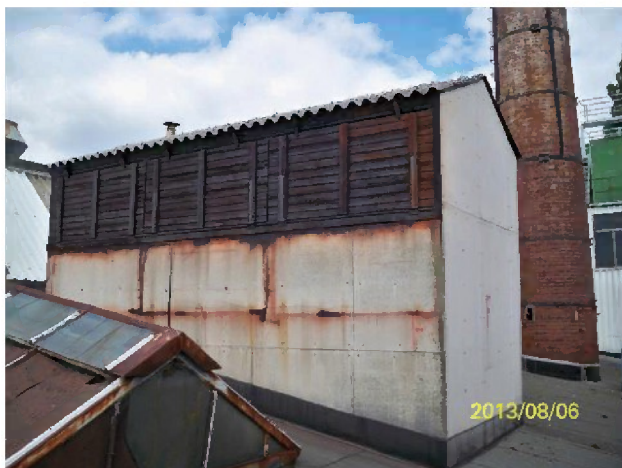
Lüfterhutze ‚Nord‘, Halle H2
