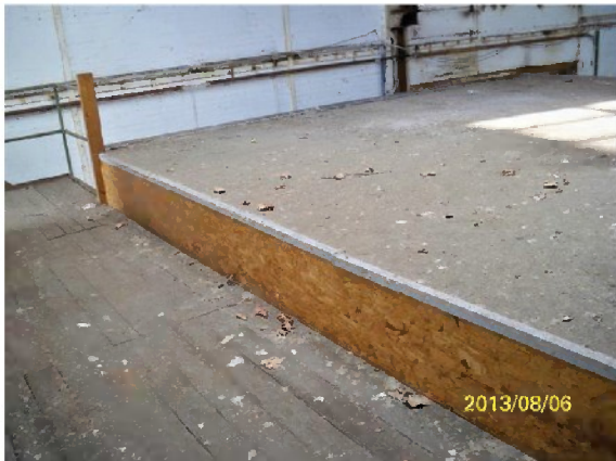
Halle H2, nachträglicher Einbau
