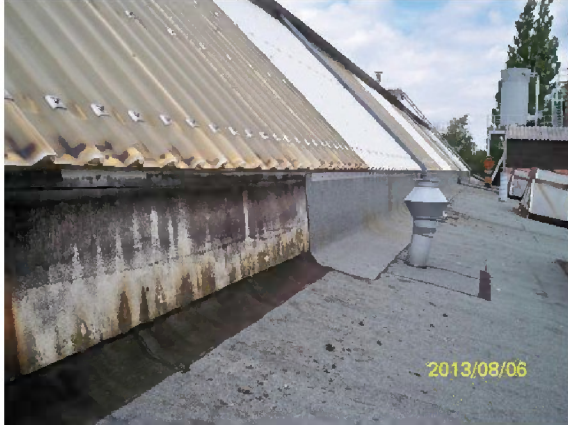
Teilbereich Dach, Halle H3
