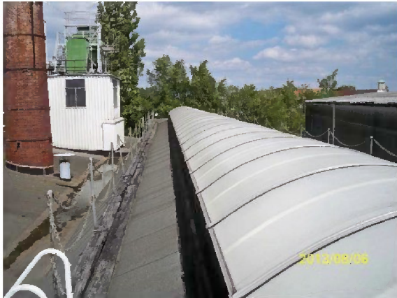
Dach Halle H1
