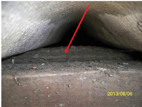
Dach Zentralbereich Hallenkomplex HN, KMF-Isolierung unter Welleternit
