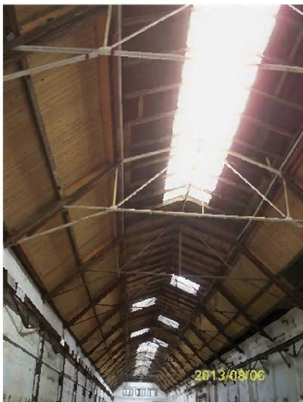
Dachkonstruktion Halle H2
