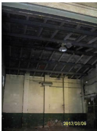
Dachunterkonstruktion ehemaliges Metalllager, Hallenkomplex HN
