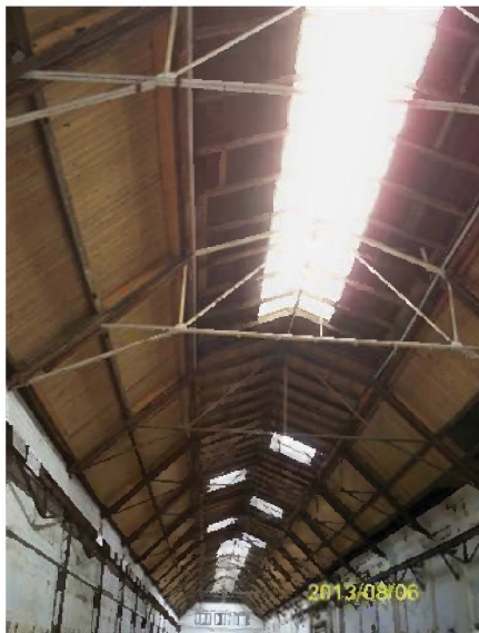
Dachunterkonstruktion Halle H1
