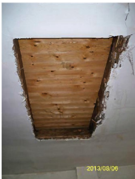
Dachunterkonstruktion Anbau Süd Halle H1
