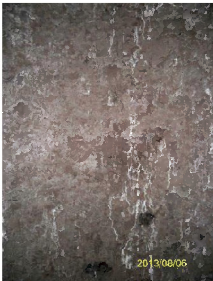
Schornstein Halle H2, Staubablagerungen
