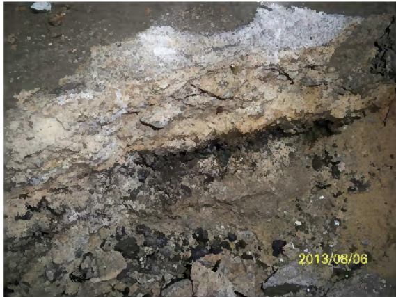
Sohlenaufbau westlicher Flügel Halle H4, Probe H4-ST2
