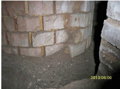
Basisbereich Schornstein, Halle H2, Probe H2-P9
