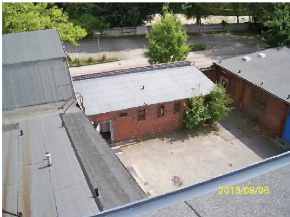
Halle H1 Anbau Süd
