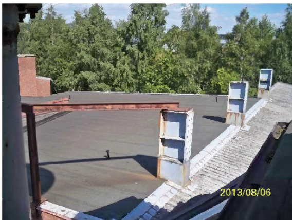
Bitumenabdichtung Dach Zentralbereich Hallenkomplex HN
