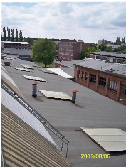
Dach, Halle H4
