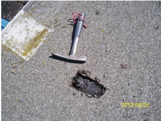
Bitumenabdichtung Dach Hallenkomplex HN, Probe HN-P25.1
