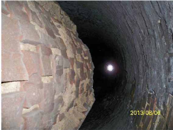
Schornstein, Mauerwerk, Halle H2
