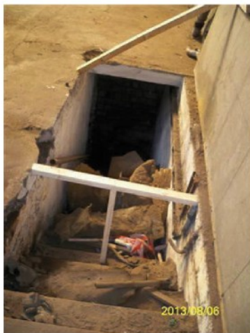
Zugang Unterkellerung, Halle H3
