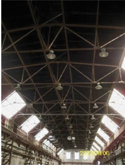
Dach-Unterkonstruktion Halle H3
