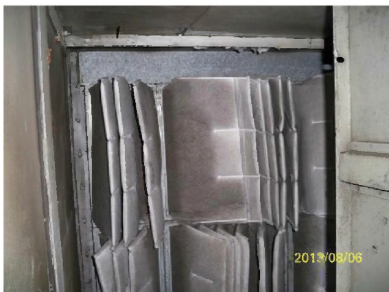
Filtereinsätze Lüftungsschacht Hallenkomplex HN
