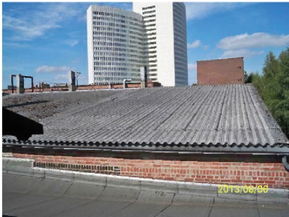
Dach Zentralbereich Hallenkomplex HN
