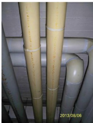
Rohrleitungen Kellergeschoß KG
