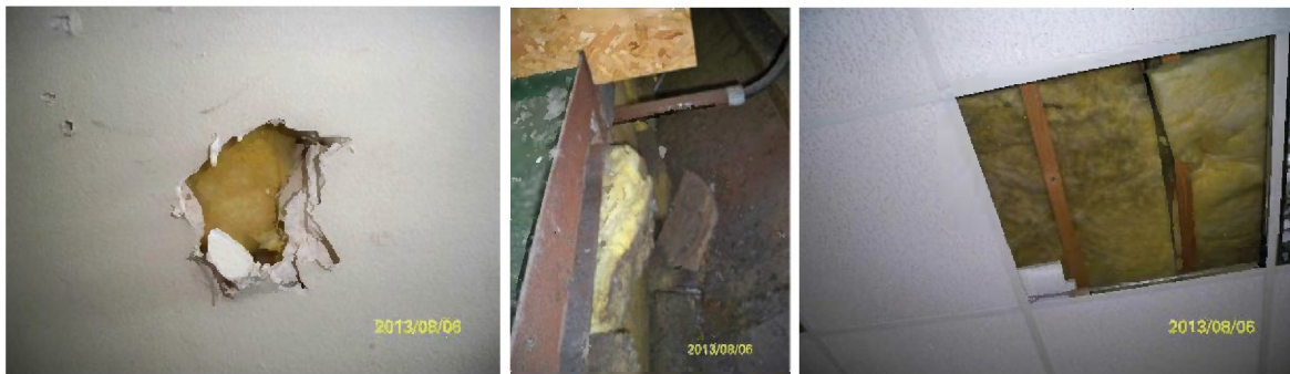
linkes, mittleres und rechtes Foto KMF-Isolierung in Bereichen nachträglicher Einbau, Halle H2
