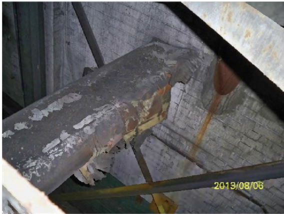
Verbindungsleitung Lüftungsgerät Hallenkomplex HN zu Halle H4
