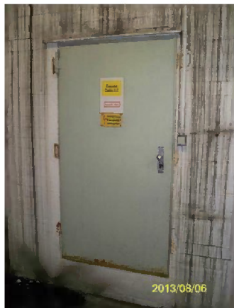
linkes und rechtes Bild: Brandschutztüren Kellergeschoß KG
