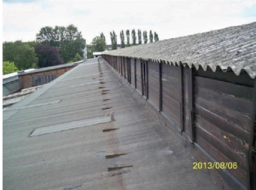
Dach, Halle H3
