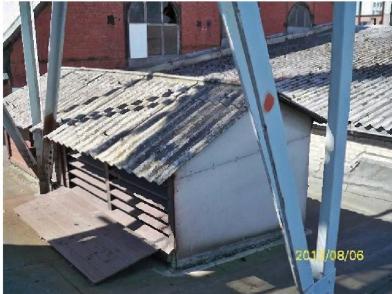
Dachaufbauten Hallenkomplex HN
