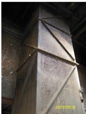
Rauchgaskanal Halle H2
