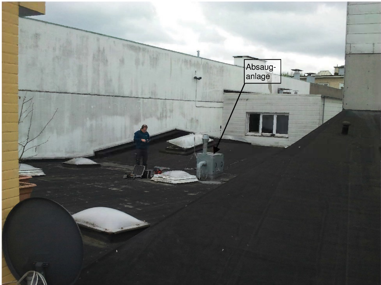
Abbildung 13: Foto Absauganlage autowerkstatt altona
