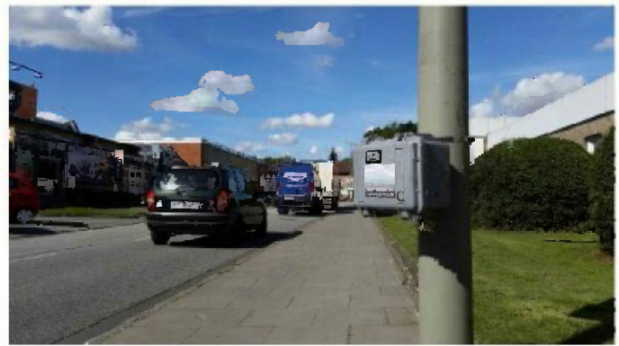
Am Lichtmast montiertes Seitenradargerät
