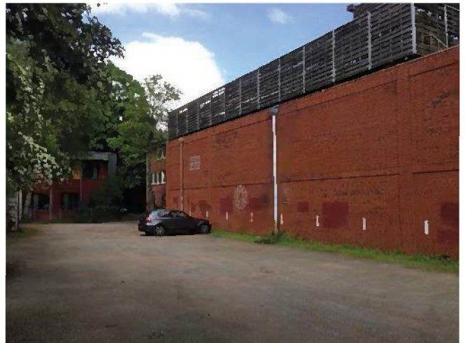
Ansicht Westseite mit Blickrichtung nach Norden
