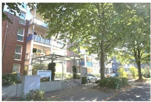
Abbildung 22: Deichgrafenhaus; Quelle: BIG Städtebau GmbH
